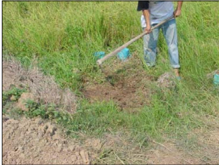
รูปที่ ๑-18 การขุดดินกลบหลุมปรับสภาพพื้นที่ให้เรียบดังสภาพเดิม
