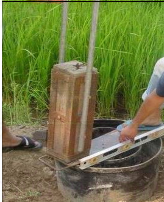
รูปที่ ๑-6 ทุ่นน้ำหนัก ใช้เพื่อกด Rings ให้จมลงในดิน
