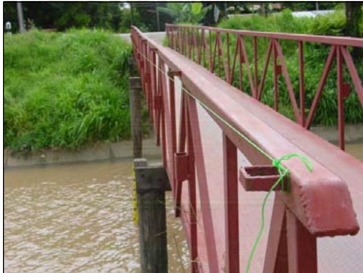
รูปที่ ง-11 การใช้เชือกตึงแนวระดับ และทำเครื่องหมายแสดงตำแหน่งของระยะที่กำหนด
