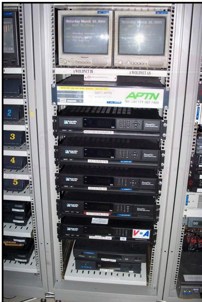
ภาพที่ 34 แสดงการติดตั้งอุปกรณ์รับและถอดรหัสสัญญาณ สถานีโทรทัศน์ยูบีซี 8 (เนชั่น แชนแนล)
