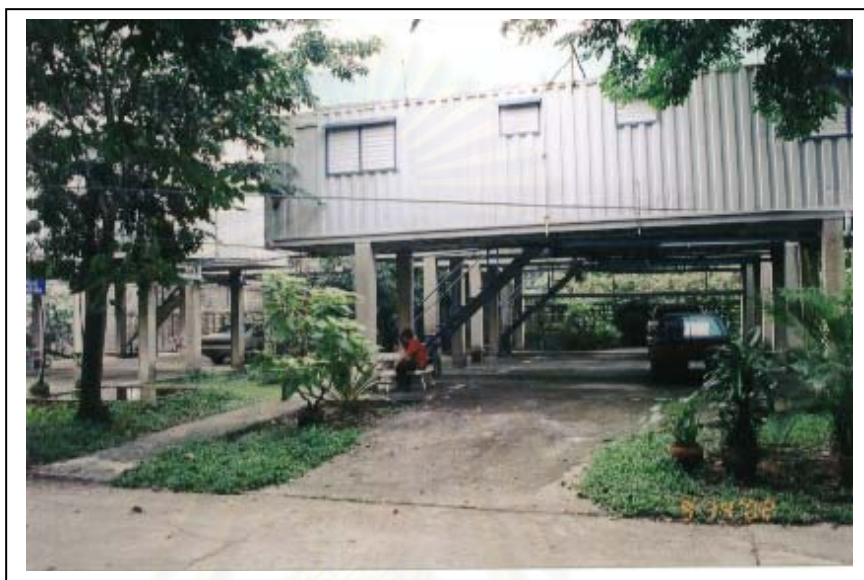
ภาพที่ 4.13 ด้านข้างตู้คอนเทนเนอร์ที่มีการเจาะใส่หน้าต่างบานเกร็ด
