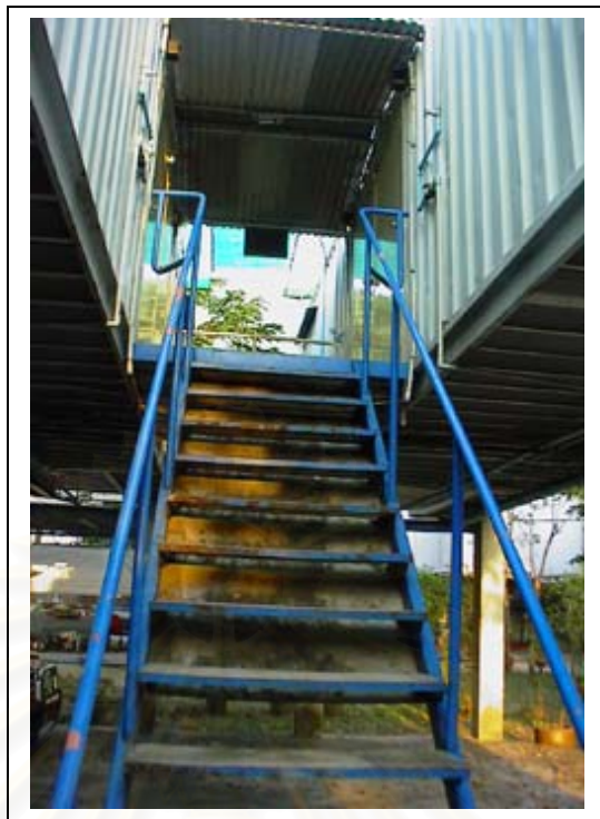
ภาพที่ 4.15 ชานพักมีหลังคาคลุมกันฝน
