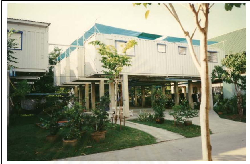
ภาพที่ 4.9 บริเวณชั้นล่างภายนอกห้องพักอาศัย
