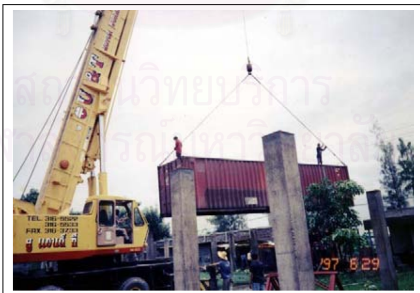
ภาพที่ 5.3. การยกตู้คอนเทนเนอร์จากรถที่ใช้ขนส่งมายังเสาคอนกรีตที่หล่อเตรียมไว้
