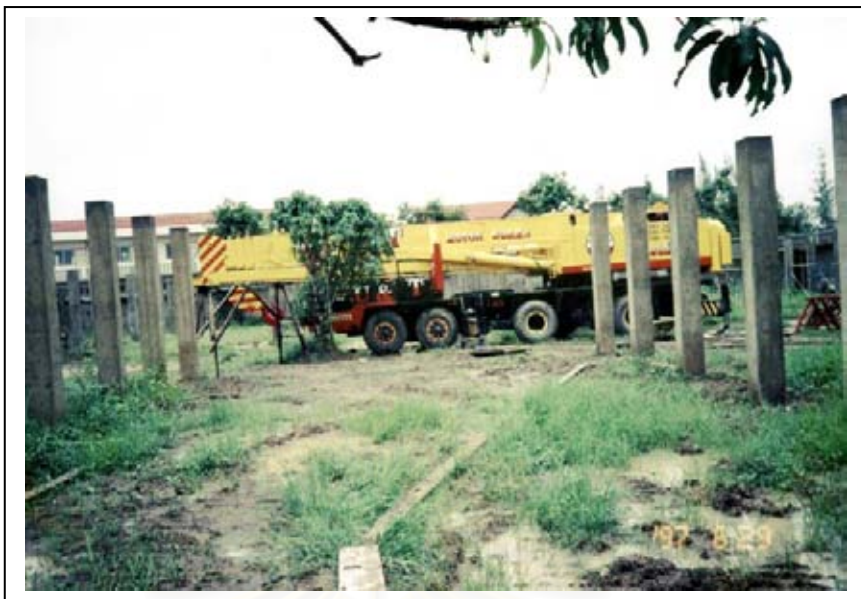
ภาพที่ 5.4 กำหนดจุดจอตระเวนในพื้นที่ก่อสร้างเพื่อให้มีการเคลื่อนที่รถน้อยที่สุด
