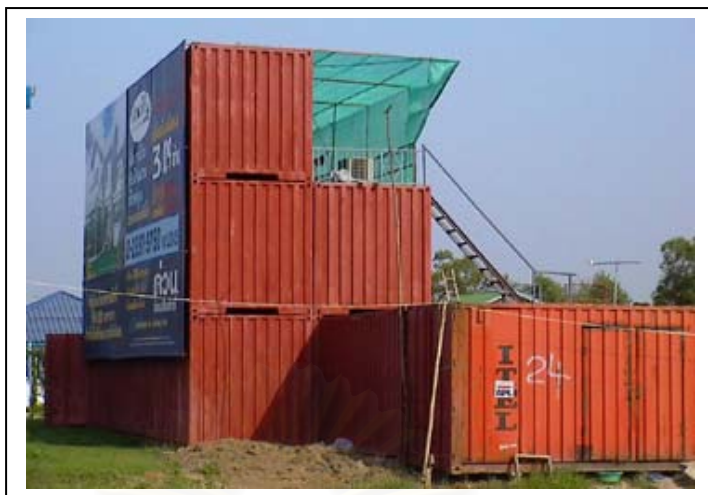
ภาพที่ 6.25 ภาพแสดงการนำตู้คอนเทนเนอร์ไปใช้เป็นบ้านพักคนงานสามารถซ้อนชั้นได้
