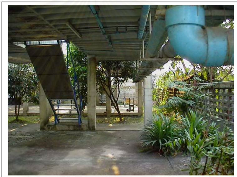
ภาพที่ 5.12 การเดินท่อน้ำเสียเพื่อรวมไปยังบ่อบำบัด
