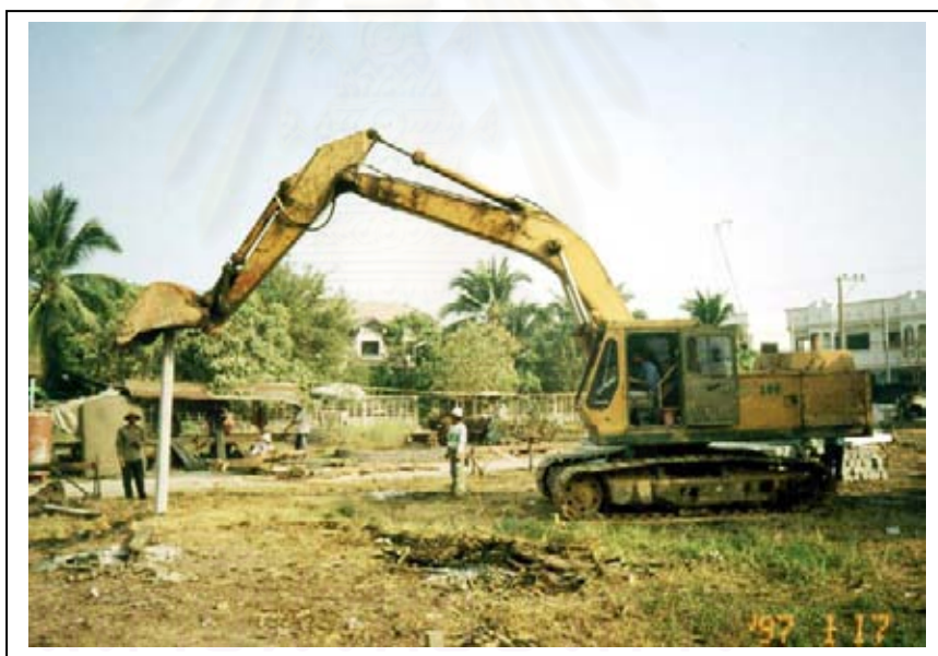
ภาพที่ 5.1 การใช้รถขุดดินกดเสาแทนการใช้แรงงานคน และปั้นจั่น
