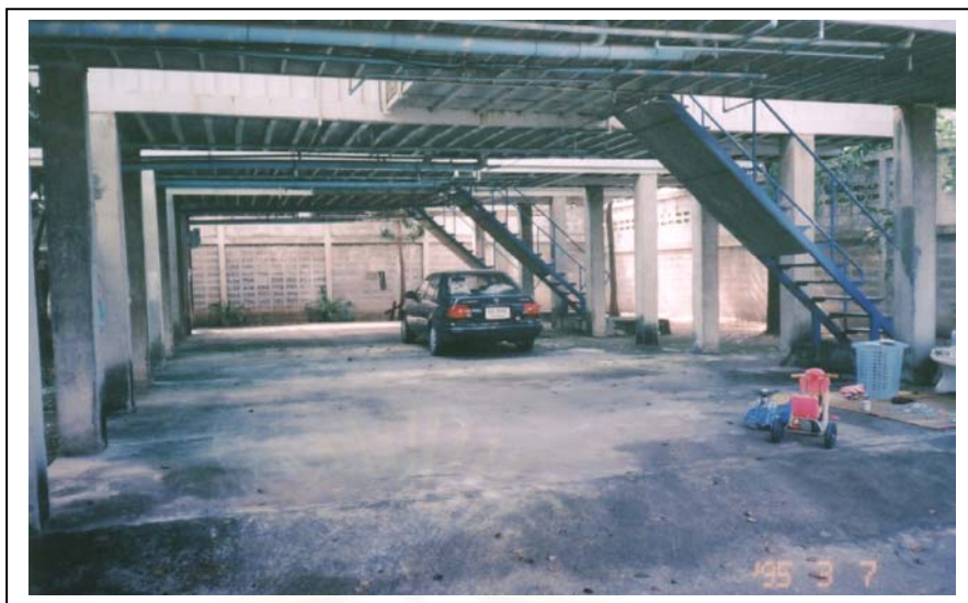
ภาพที่ 4.5 ภายในโครงการมีบริเวณใต้ถุน
