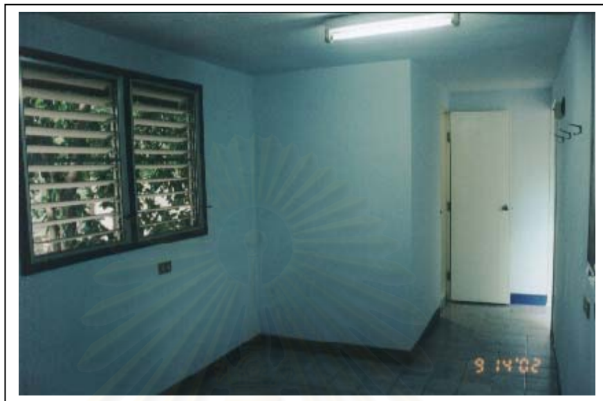
ภาพที่ 5.14 ภายในตู้คอนเทนเนอร์ หลังจากทำผนัง ฝ้าเพดาน และทาสีแล้ว
