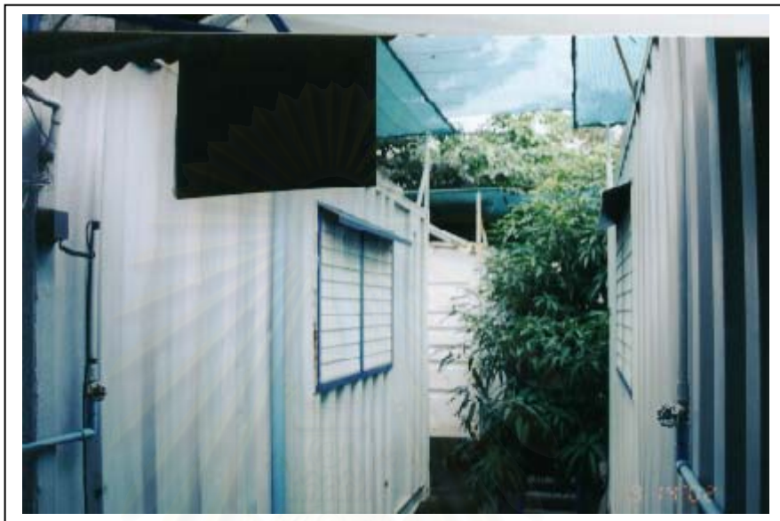
ภาพที่ 4.11 .การใช้ตาข่ายคลุมหลังคาเพื่อช่วยลดความร้อนลงบนตู้คอนเทนเนอร์
