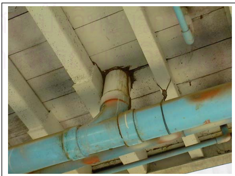
ภาพที่ 5.13 การเจาะใต้ตู้คอนเทนเนอร์ เพื่อเดินระบบท่อน้ำเสีย
