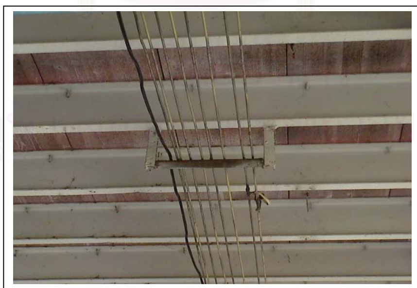
ภาพที่ 5.11 การเดินสายไฟไปยังตู้คอนเทนเนอร์
