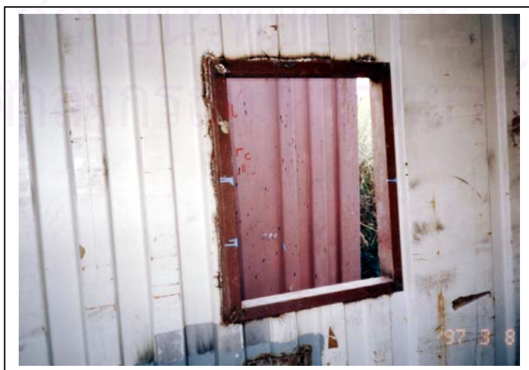
ภาพที่ 5.8 การเจาะ และติดตั้งวงกบหน้าต่าง
