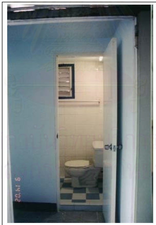
ภาพที่ 4.8 ภาพห้องน้ำในห้องพักอาศัย
