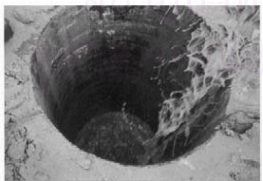
รูปที่ 2-8 เติมสารรักษาเสถียรภาพหลุมเจาะลงไปเมื่อขุดเข้าใกล้ชั้นทรายชั้นแรก
