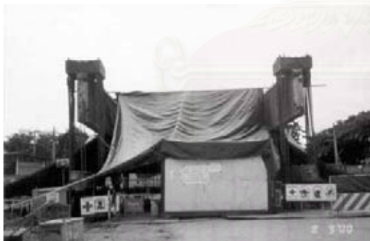
รูปที่ 2-36 สถานที่ทดสอบกำลังรับน้ำหนักบรรทุกของเสาเข็ม
