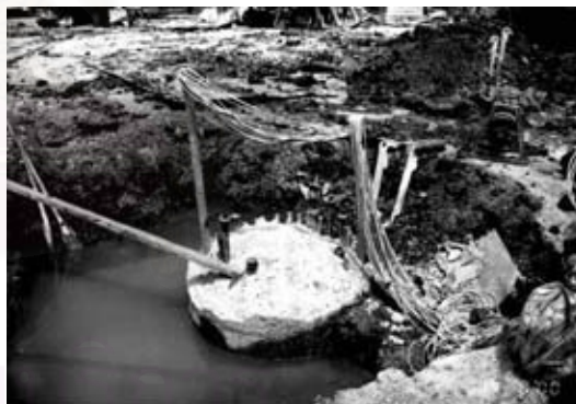
รูปที่ 2-15 เสาค้ำที่เสร็จสมบูรณ์
