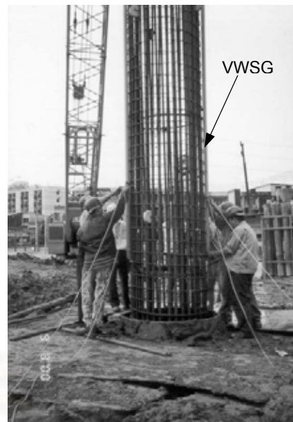
รูปที่ 2-30 การติดตั้ง VWSG
