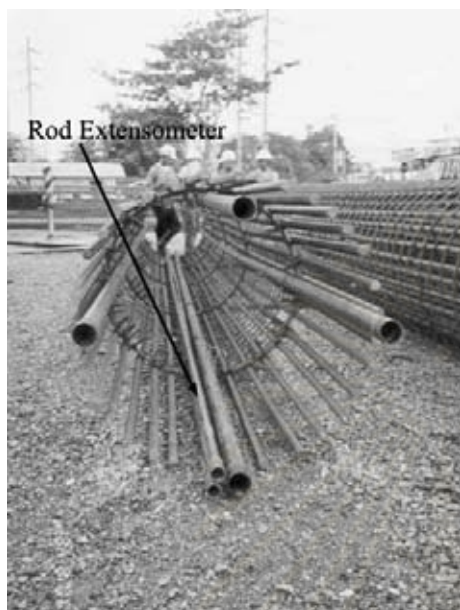
รูปที่ 2-31 Rod Extensometer
