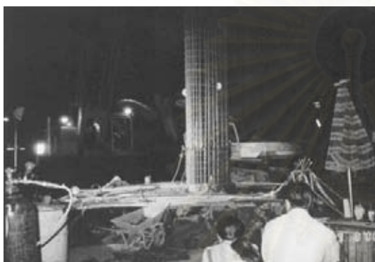
รูปที่ 2-12 การลงเหล็กเสริม
