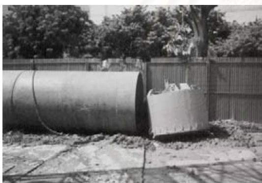
รูปที่ 2-6 ปลอกเหล็ก (Casing) ป้องกันในชั้นดินเหนียวอ่อน
