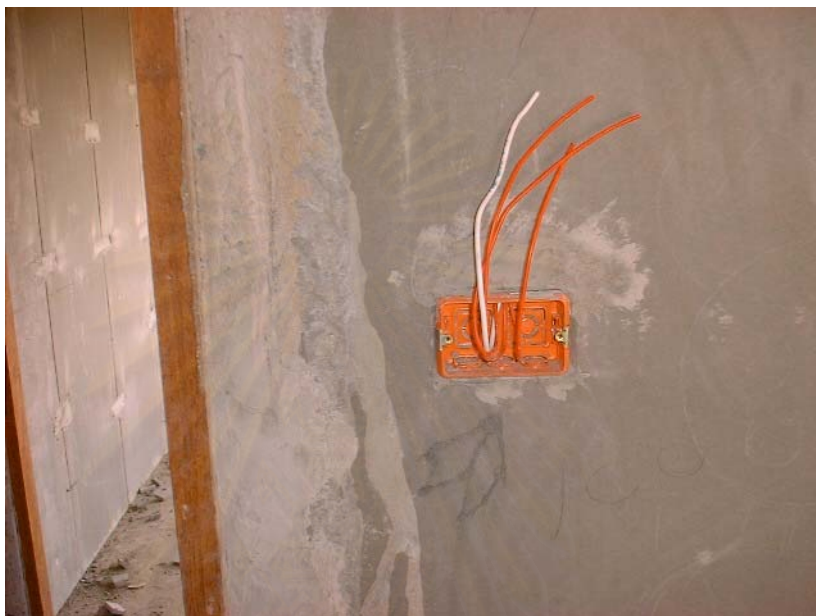
ภาพที่ 5.83 การเดินสายร้อยในผนังฝังเต้าเสียบ และสวิตช์
