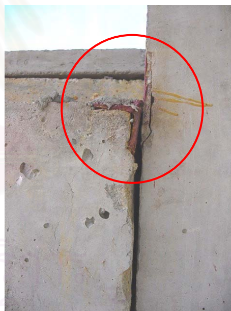
ภาพที่ 5.108 การติดตั้งคานยื่นตัว U ที่ต้องค้ำยัน ภาพที่ 5.109 บริเวณที่เกิดการแตก (Crack)
