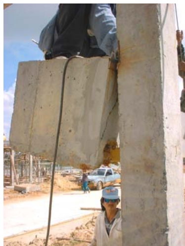
ภาพที่ 5.105 ช่างกำลังนำเอาคานบันไดออก
