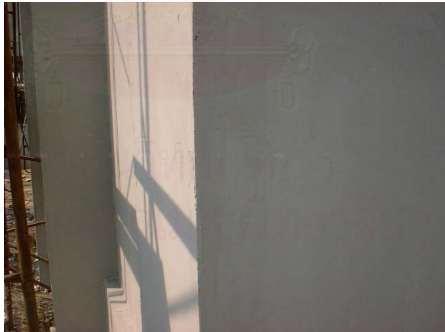
ภาพที่ 5.76 ภาพบ้านเมื่อฉาบปูนฉาบผิวรอยต่อผนังแล้ว
