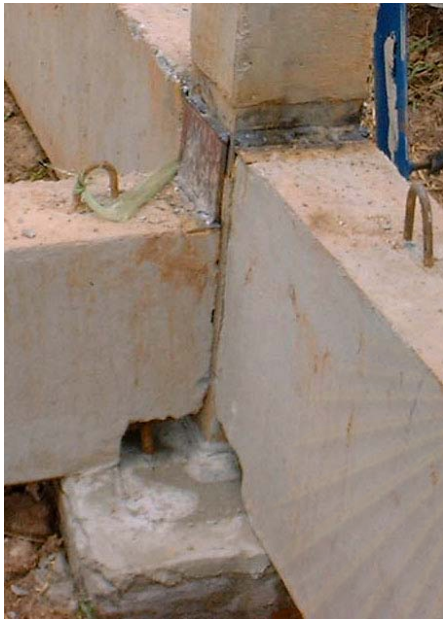
ภาพที่ 5.9 รอยต่อระหว่างเสากับเสา
