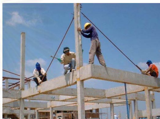
ภาพที่ 5.104 ช่างต้องใช้ค้อนตอกเสาให้เข้าตำแหน่งเพราะไม่มีจุดอ้างอิง
