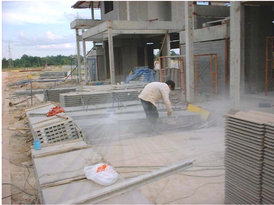
ภาพที่ 5.67 ช่างทำการวัด และตัด แผ่นผนังไฟเบอร์ซีเมนต์กอลวง
