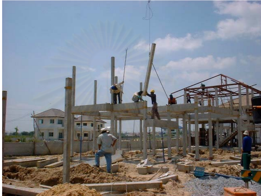
ภาพที่ 5.55 การยกติดตั้งชิ้นส่วนเสาสำเร็จรูปชั้นที่2
