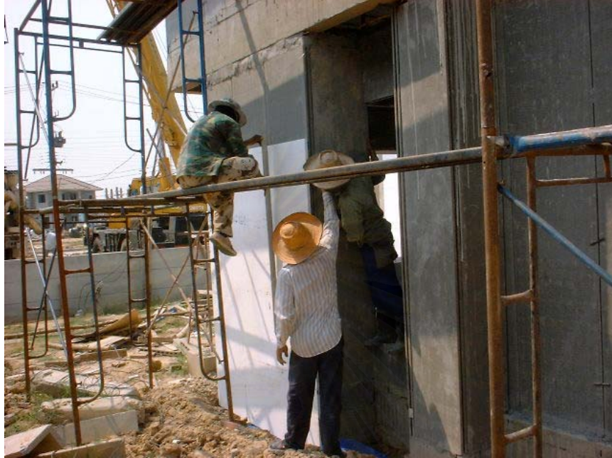
ภาพที่ 5.73 ช่างติดโฟม (EPS Foam) ด้วย Base Coat กับผนัง
