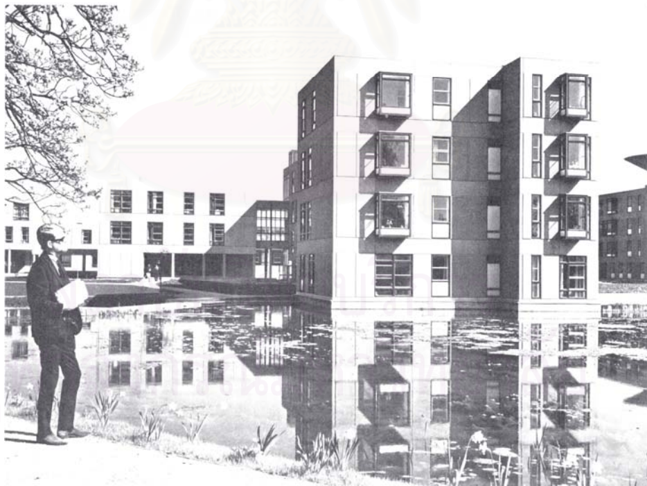
ภาพที่ 2.6 ภาพ York University อาคารที่ก่อสร้างด้วยการสร้างกลุ่มของชิ้นส่วนโดยคำนึงถึง ระบบประสานทางฟักัด
