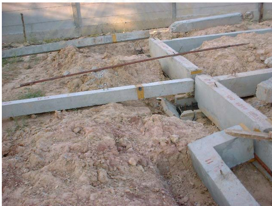
ภาพที่ 5.98 ระดับฐานราก Center Pin ไม่ได้ระดับ 2 ต้น ในผัง 209
