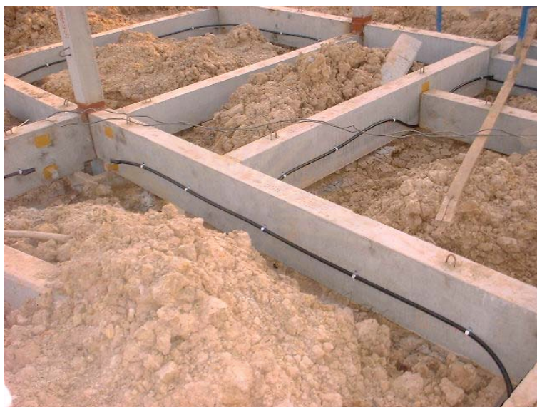
ภาพที่ 5.48 งานเดินระบบท่อน้ำยาป้องกันปลวก
