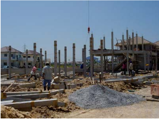
วันที่ 08/10/45 ติดตั้งเสาสำเร็จรูปชั้นที่ 1
