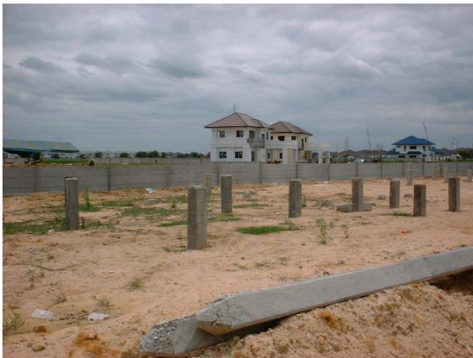
ภาพที่ 5.21 เสาเข็มคอนกรีตอัดแรงเมื่อตอกเสร็จแล้ว
