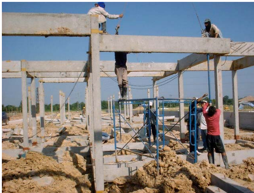
ภาพที่ 5.53 คานยื่นที่จะทำการยกติดตั้งหลังสุด เพราะต้องใช้ค้ำยัน
