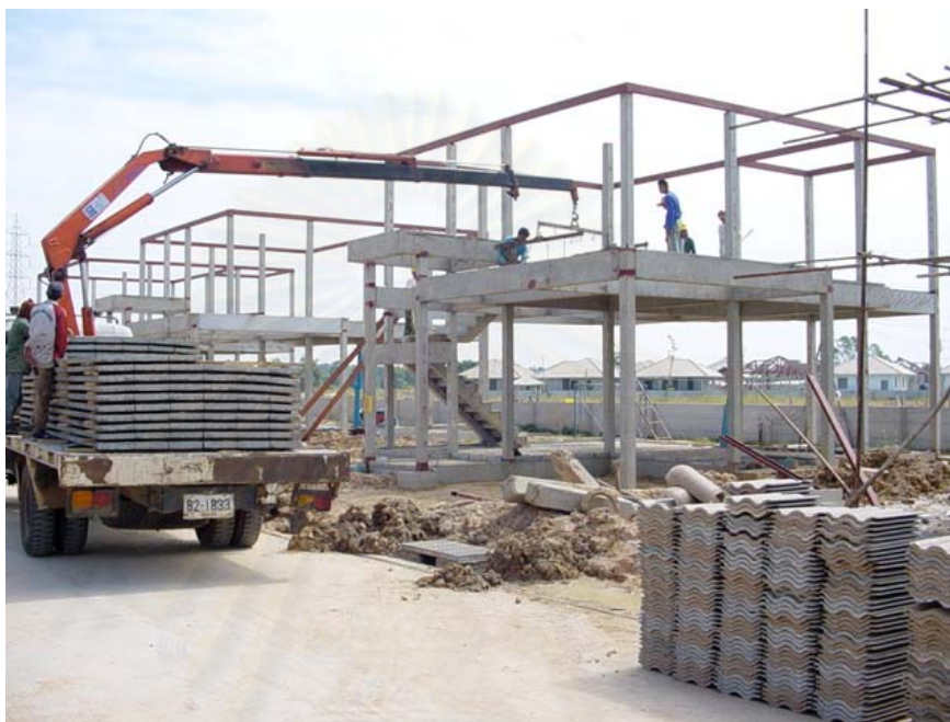
ภาพที่ 5.59 การยกแผ่นพื้นสำเร็จรูปวางโดยใช้ Crane ของรถขนส่งวัสดุ
