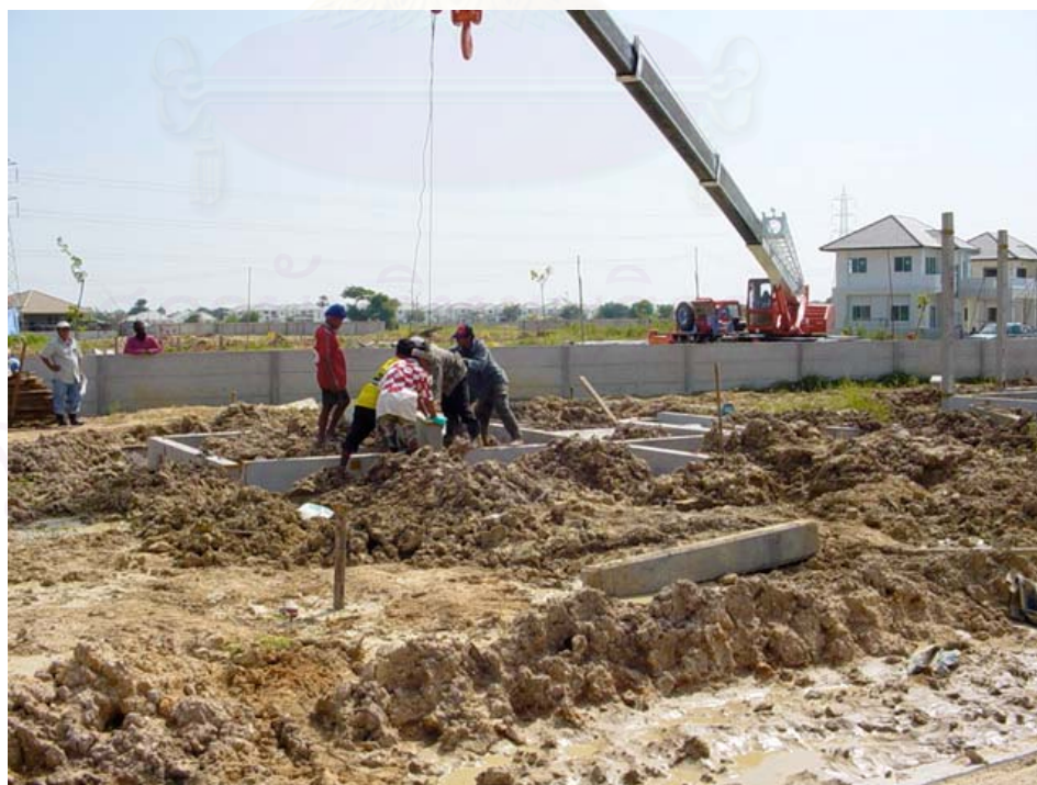
ภาพที่ 5.30 การยกขึ้นส่วนคานคอนกรีตสำเร็จรูปชั้นที่ 1 วางตามตำแหน่ง
