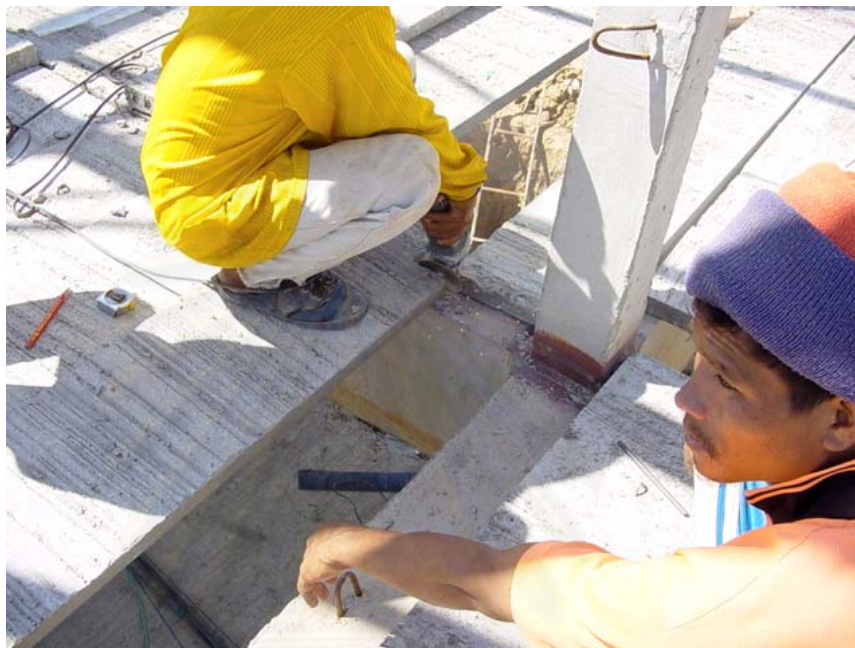
ภาพที่ 5.61 ช่วงตัดปากแผ่นพื้นให้พอดีบริเวณเสา
