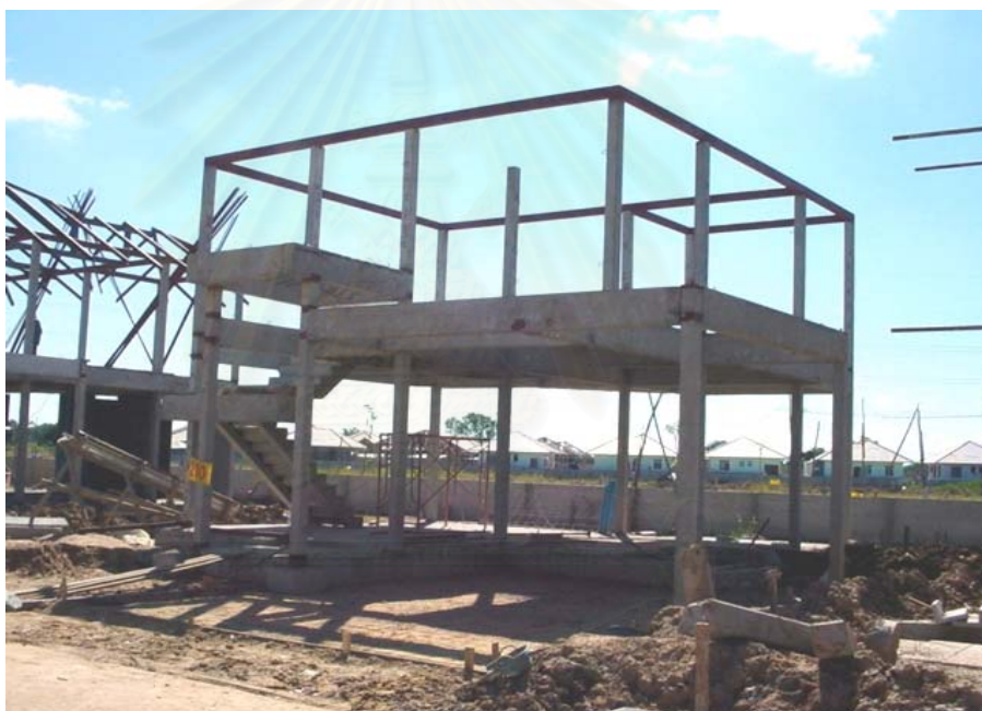
ภาพที่ 5.63 คานหลังคาเหล็กรูปพรรณที่ติดตั้งบนหัวเสา
