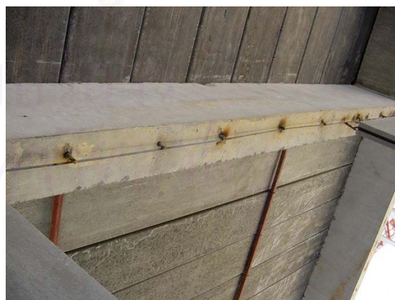
ภาพที่ 5.113 ช่างเสียบกรอกปูนเหล็กสำหรับหัวผนัง ภาพที่ 5.114 การยึดแผ่นผนังไฟเบอร์ซีเมนต์กับคาน ค.ส.ล
