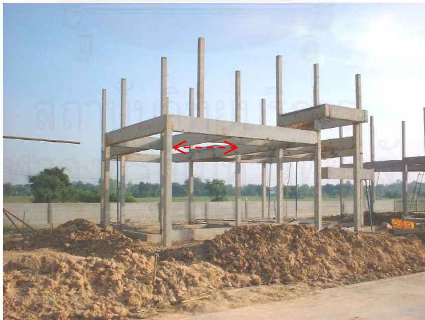
ภาพที่ 5.93 ชิ้นส่วนคาน B8 ที่ขาดไป ยังไม่ได้ยกในผัง 209 เนื่องจากขนส่งชิ้นส่วนมาไม่ครบ
