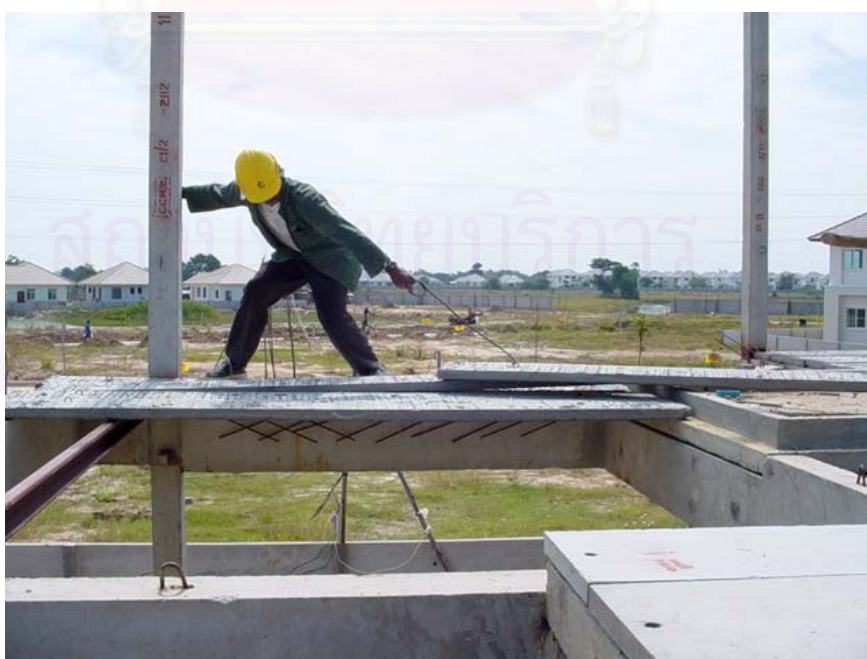
ภาพที่ 5.60 ช่างใช้เหล็กเกี่ยวลากแผ่นพื้นสำเร็จรูปเข้าที่
