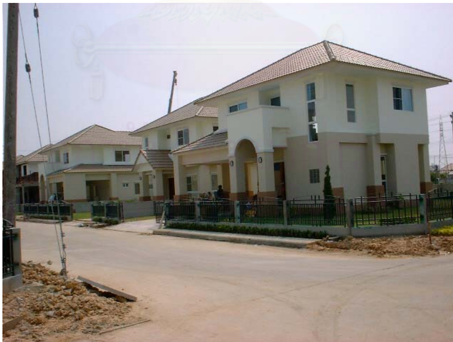
ภาพที่ 4.12 ทัศนียภาพของกลุ่มบ้านแบบ “ชลวารี” ที่ก่อสร้างด้วยระบบเดิม ก่ออิฐฉาบปูน
