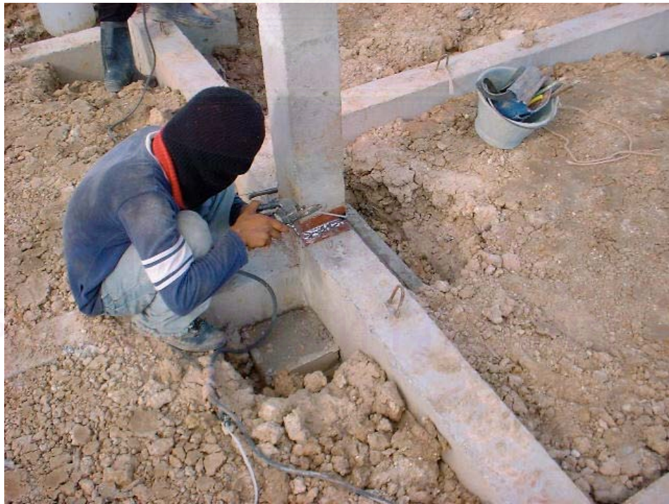
ภาพที่ 5.47 ช่างเชื่อมเก็บรอยต่องานเชื่อมที่ไม่เรียบร้อย
