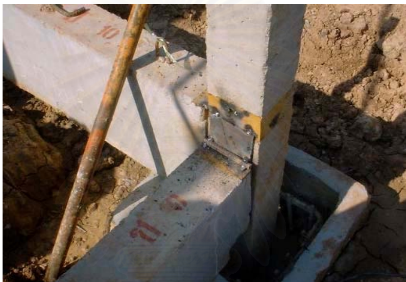
ภาพที่ 5.44 รอยต่อลดระดับที่ใช้เหล็กแผ่น และเหล็กข้ออ้อย 9 มม. ในการเชื่อมติด
