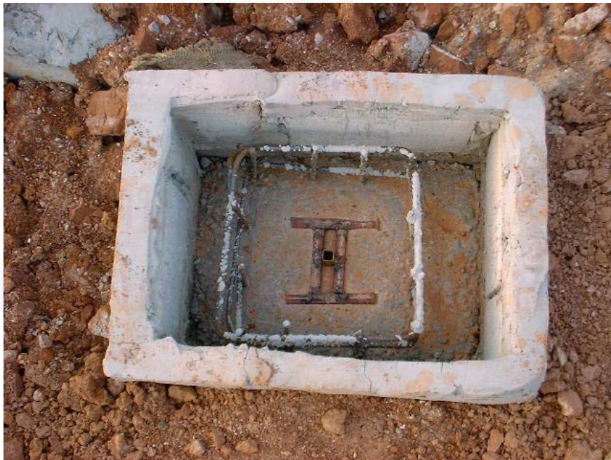
ภาพที่ 5.29 วางเหล็กเสริมฐานราก, หมุดเหล็ก แล้วเทคอนกรีตด้านล่างยึดเหล็กไว้กับหัวเสาเข็ม
