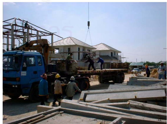
ภาพที่ 5.97 ชิ้นส่วนขนส่งมาไม่พร้อมกัน ทำให้แยกชิ้นส่วนไปตามฝั่งได้ลำบาก
