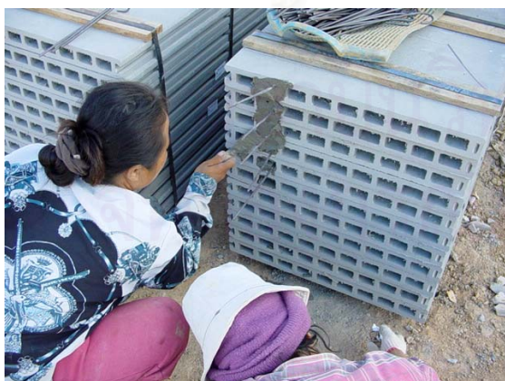
ภาพที่ 5.113 ช่างเสียบกรอกปูนเหล็กสำหรับหัวผนัง ภาพที่ 5.114 การยึดแผ่นผนังไฟเบอร์ซีเมนต์กับคาน ค.ส.ล
