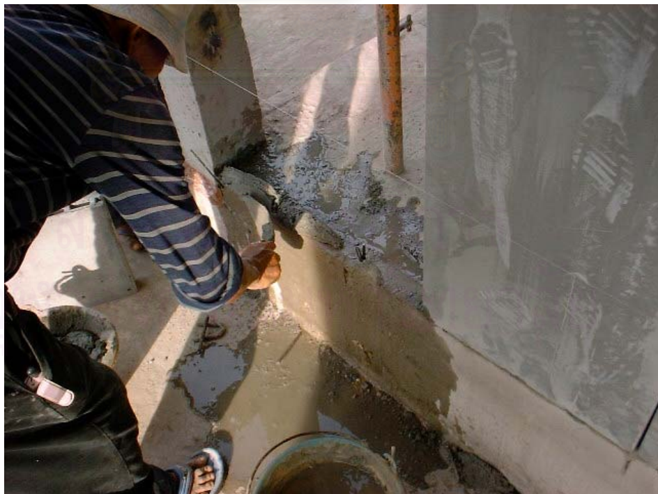
ภาพที่ 5.68 ช่างก่อปูน Mortar บริเวณที่เสียบเหล็กไว้แล้ว เพื่อยึดแผ่นผนัง
