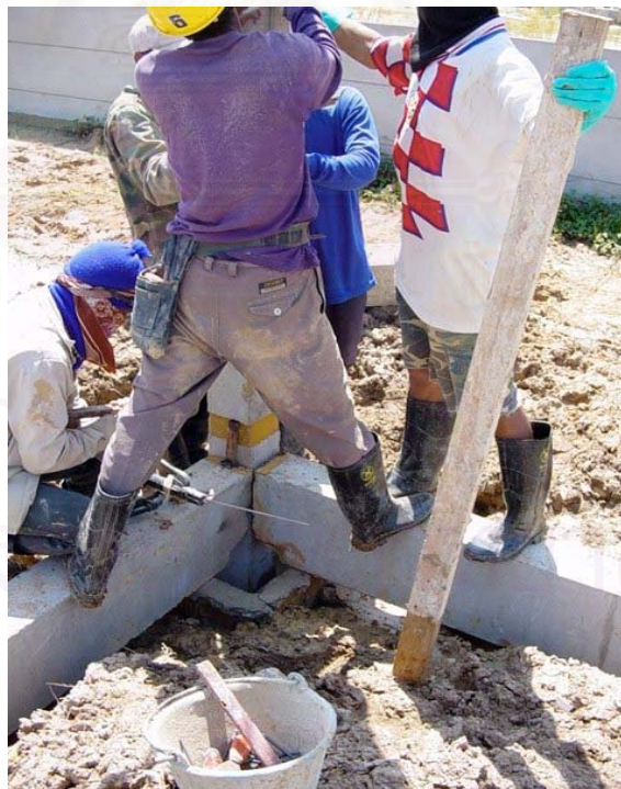
ภาพที่ 5.38 เชื่อมเสาและคานชั้นที่ 1 ให้พออยู่ก่อน เพื่อสามารถปรับระยะ ปรับตั้งเสาอีกครั้งก่อนการเชื่อมแน่น เก็บรอยต่อต่อไป
