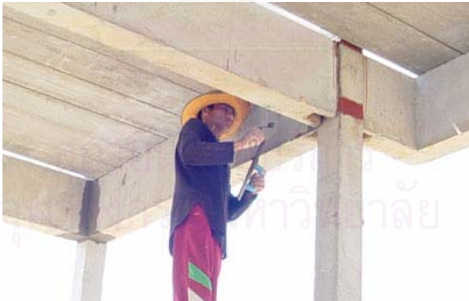
ภาพที่ 5.17 ช่างกำลังยัดปูนเค็มเข้ารอยต่อคานเพื่อป้องกันไฟไหม้ และเพื่อเก็บความเรียบร้อย
