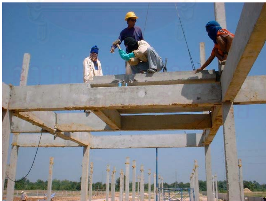
ภาพที่ 5.56 การยกติดตั้งถาดห้องน้ำสำเร็จรูปในชั้นที่2
