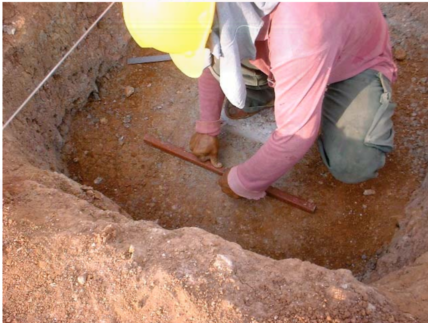
ภาพที่ 5.27 ช่างวัดขนาดเตรียมก่ออิฐบล็อกจากเป็นแบบเทฐานรากตอม่อ
