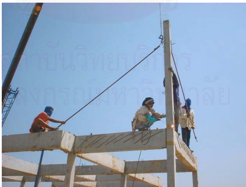
ภาพที่ 5.54 ช่างจับระดับน้ำ ดึงเสาให้ได้ดัง และเชื่อมติดเสาชั้นที่ 2
