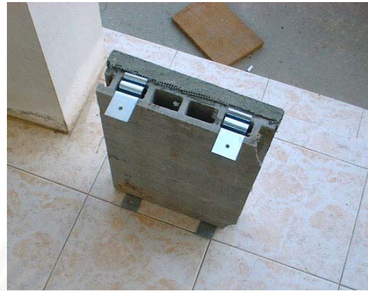
ภาพที่ 5.115 การติดตั้งแผ่นผนังกับอะไหล่เหล็ก ภาพที่ 5.116 อุปกรณ์การยึดเกาะแผ่น
