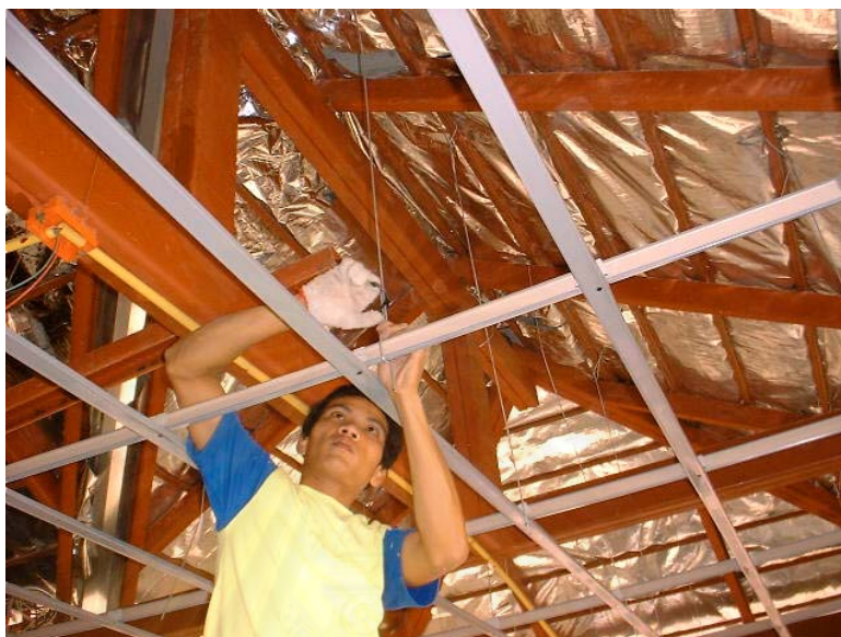
ภาพที่ 5.85 ช่างกำลังยึดโครงฝ้ากับโครงหลังคา
