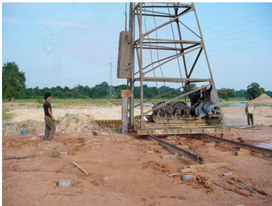
ภาพที่ 5.20 การตอกเสาเข็มคอนกรีตอัดแรงด้วยปั้นจั่น
