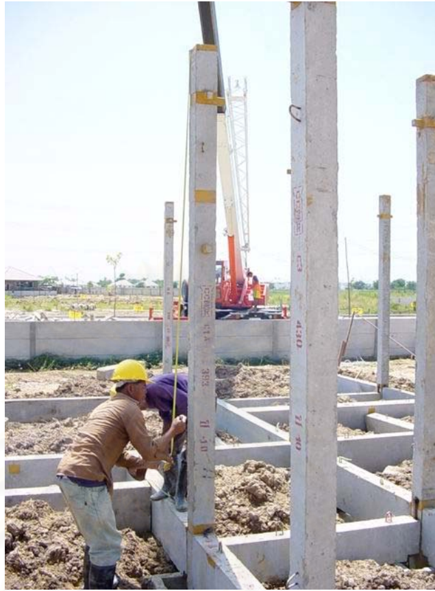
ภาพที่ 5.41 ช่างวัดระยะจากบนหัวเสาถึงจุดระดับ +1.00 ม. ตรวจสอบ ความต่างระดับหัวเสาทุกต้นเทียบกัน
