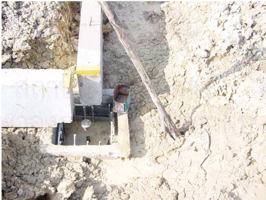
ภาพที่ 5.32 ทิ้งคานจุดกึ่งกลางเสาเพื่อนำไปวัดระยะ ตรวจสอบแนวของคาน
