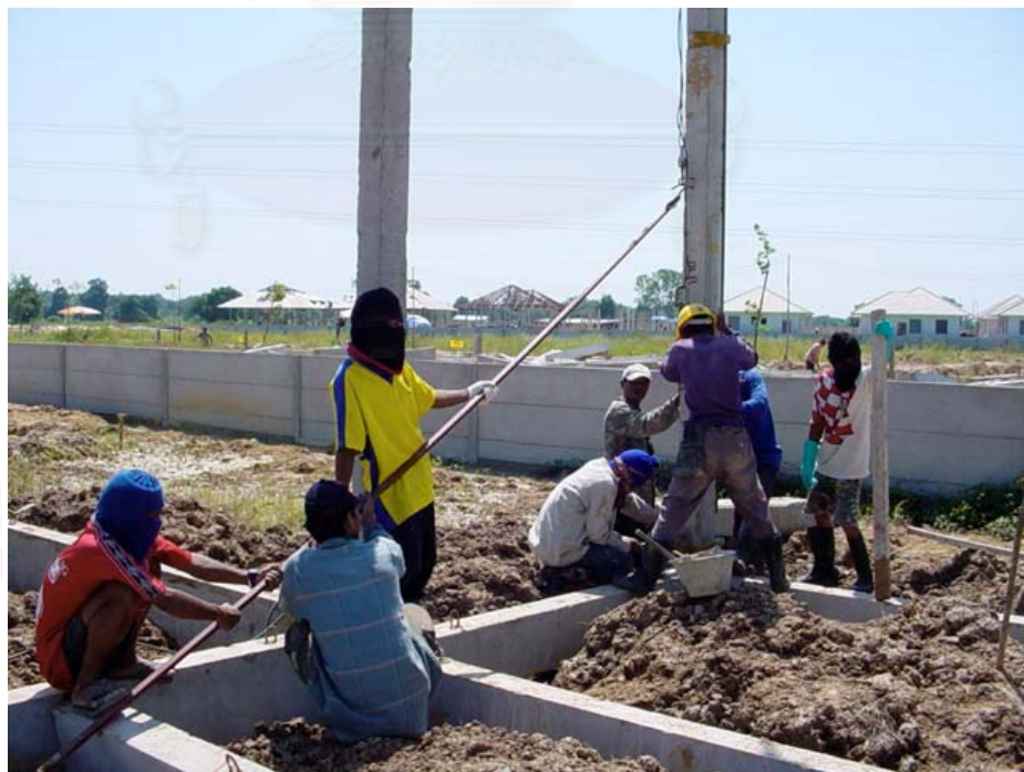
ภาพที่ 5.36 การตั้งเสาให้เข้าแนวตั้ง
