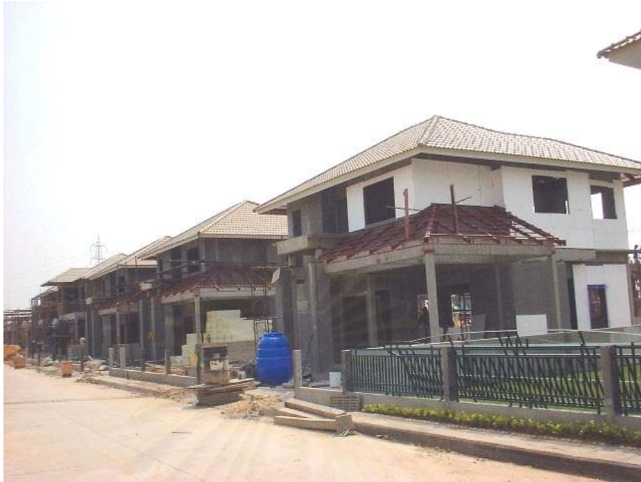
ภาพที่ 4.11 ทัศนียภาพของกลุ่มบ้านแบบ “ชลวารี” ที่ก่อสร้างด้วยระบบสำเร็จรูป
