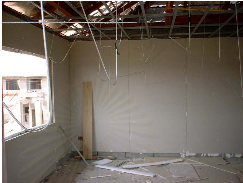
ภาพที่ 5.77 ผนังด้านในยิบช้บอร์ตฉาบเรียบทาสี
