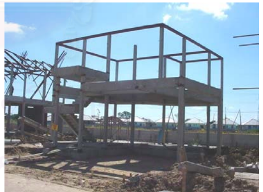
วันที่ 13/11/45 ถึงงานติดตั้งบันไดสำเร็จรูป, พื้นชั้นที่ 1, ติดตั้งอะเสเหล็กรูปพรรณ
