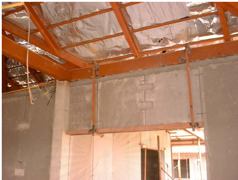
ภาพที่ 5.71 ในบริเวณช่องเปิดจะต้องทำค้ำยัน หรือหิ้วแผ่นผนังไว้จนมีความแข็งแรงก่อน
