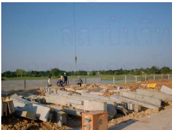
ภาพที่ 5.96 แสดงการกองเก็บที่ไม่เป็นระเบียบ
