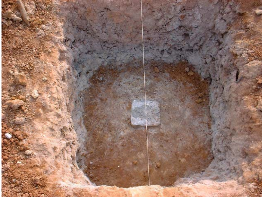
ภาพที่ 5.26 เสาเข็มที่ได้ทำการตัดแล้ว เตรียมหล่อทำฐานราก
