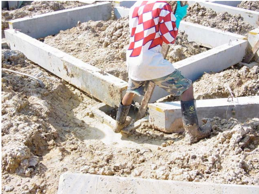
ภาพที่ 5.31 เมื่อยกคานชั้นที่ 1 เสร็จ กิ่งดปรับคานให้ตรงแนว, ระยะเวลา
