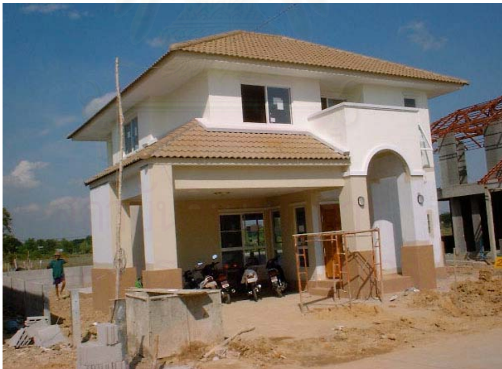
ภาพที่ 4.14 ทักษณียภาพของบ้านพักอาศัย “ ชลวารี “ ระบบเดิม ก่ออิฐฉาบปูน ผัง 207 ที่ทำการศึกษา
