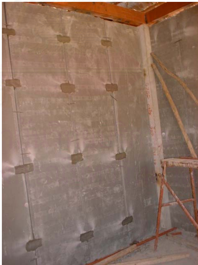
ภาพที่ 5.70 เมื่อติดตั้งแผ่นผนังเรียบร้อยแล้ว จะบากยึดแผ่นเข้าด้วยกันโดยเสียบเหล็กไว้
