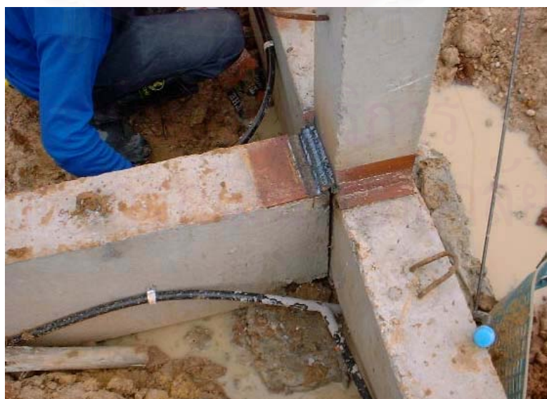
ภาพที่ 5.45 รอยต่อที่ทำการเชื่อมแน่นแล้ว
