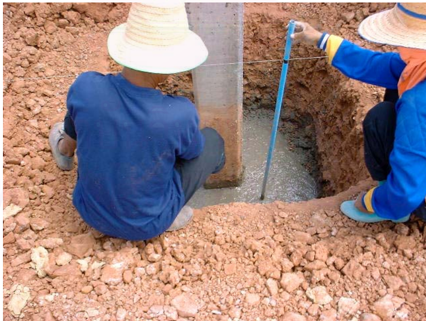
ภาพที่ 5.25 การวัดระดับคอนกรีตหยาบ (เท่ากับระดับใต้ท้องฐานราก)
