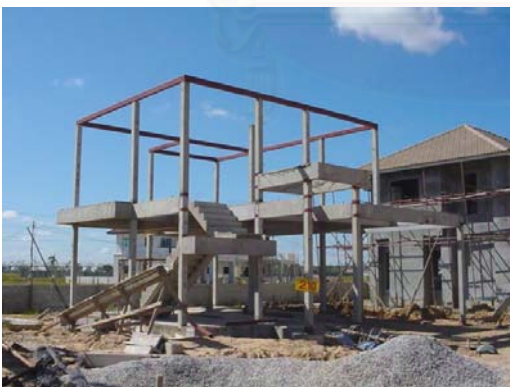
วันที่ 13/11/45 ถึงงานติดตั้งบันไดสำเร็จรูป, พื้นชั้นที่ 1, ติดตั้งอะเสเหล็กรูปพรรณ
