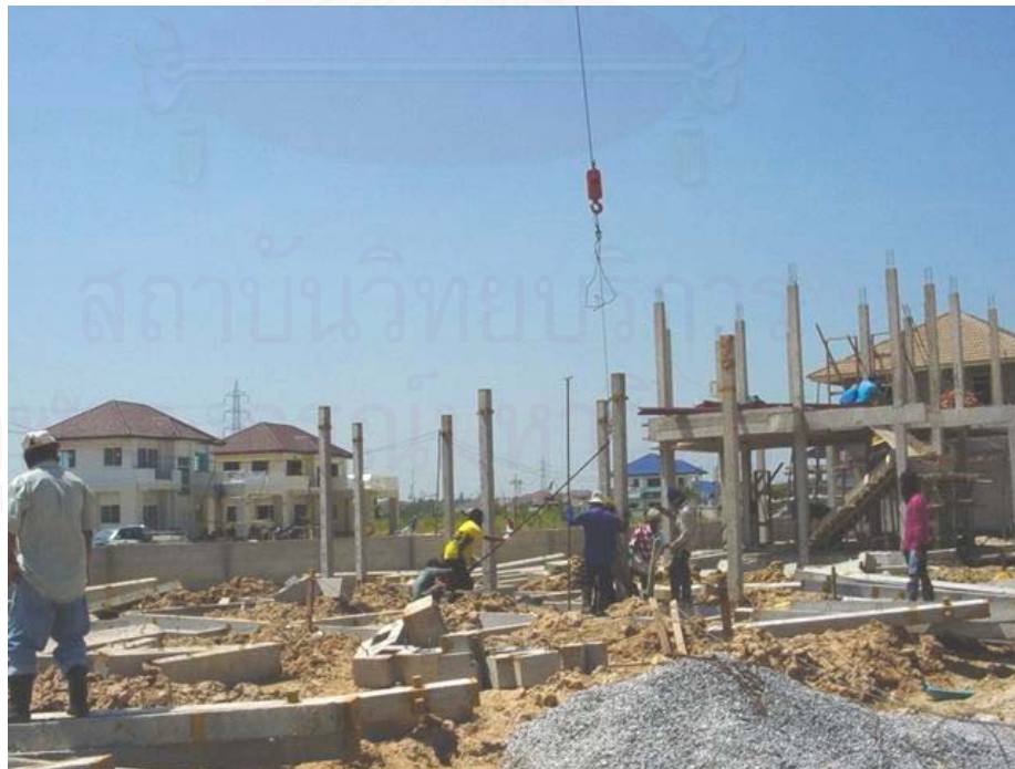
ภาพที่ 5.34 การยกติดตั้งเสาคอนกรีตสำเร็จรูปชั้นที่ 1
