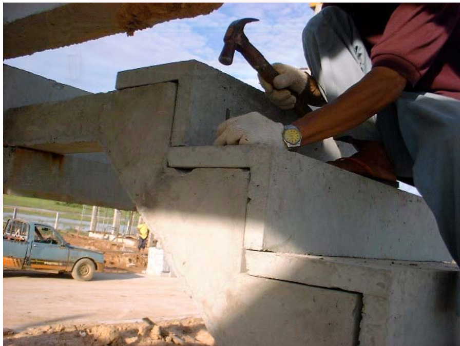
ภาพที่ 5.58 ช่างตอกเหล็กเส้นกลมเข้ายึดลูกบันไดกับแม่บันไดสำเร็จรูป
