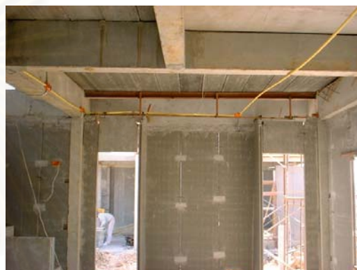
ภาพที่ 5.110 ช่างติดตั้งเตรียมตัดแผ่น ภาพที่ 5.111 การติดตั้งต้องตัดแต่งแผ่นหน้างานมาก
