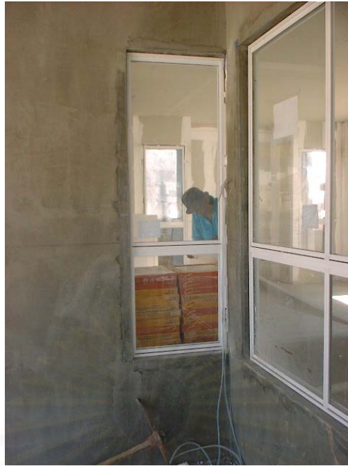
ภาพที่ 5.80 หน้าต่างอลูมิเนียมที่มาติดตั้งที่หลังจากงานกรุผนังฉนวนแล้ว
