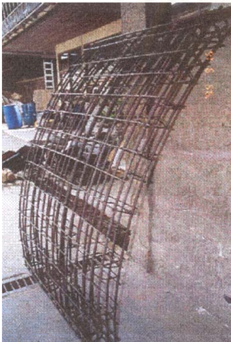
ภาพที่ 5.1 เหล็กตะแกรงโครงสร้าง (Engineering Steel Wire Mesh) ซึ่งพับเป็นรูปหน้าตัดของเหล็กในองค์อาคารนั้นๆ ด้วยเครื่องจักรพับเหล็กของโรงงาน
