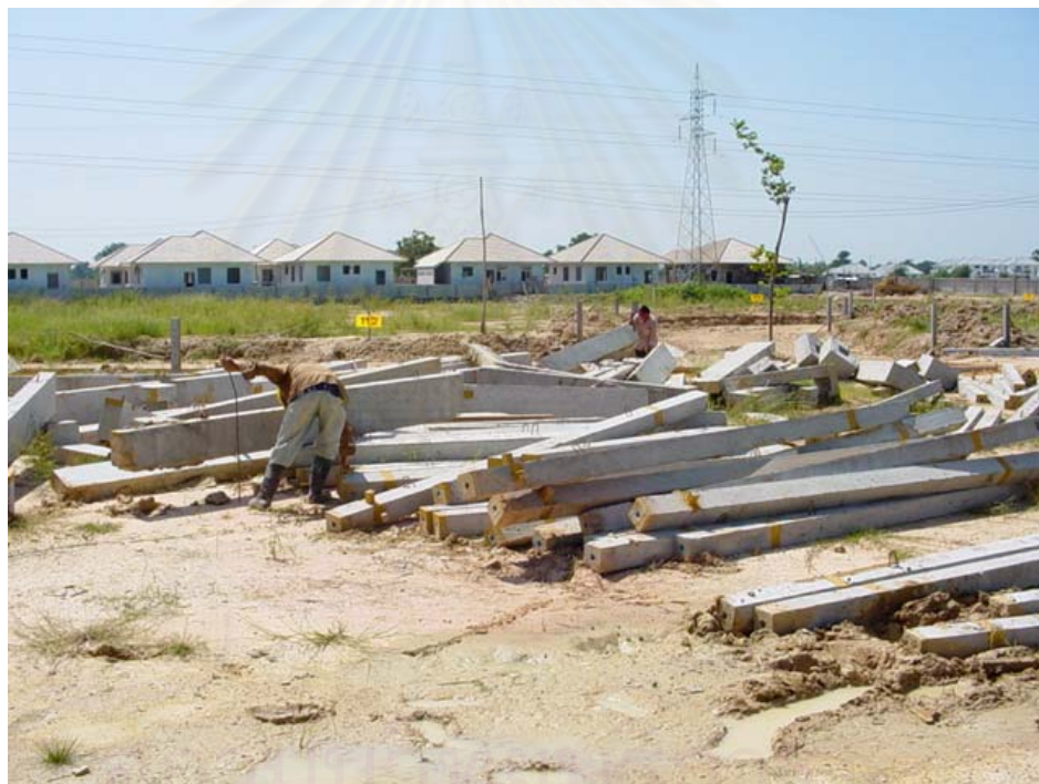
ภาพที่ 5.94 ชิ้นส่วนสำเร็จที่วางระเกะระกะในฝังอื่นที่ไม่ใช่ตำแหน่งฝังในการก่อสร้าง เนื่องจากกำลังก่อสร้างถนน รถขนส่งชิ้นส่วนสำเร็จรูปไม่สามารถเข้าได้
