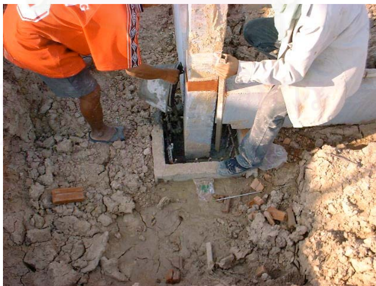
ภาพที่ 5.49 ช่างกำลังเทคอนกรีตต่อม่อ
