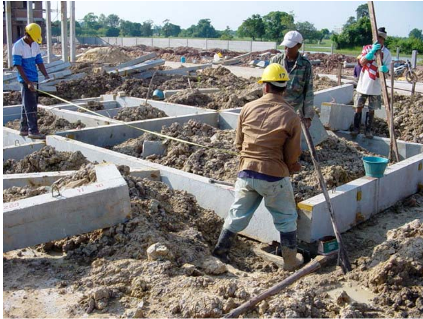
ภาพที่ 5.33 ตรวจสอบ และปรับระยะแนววางของคาน
