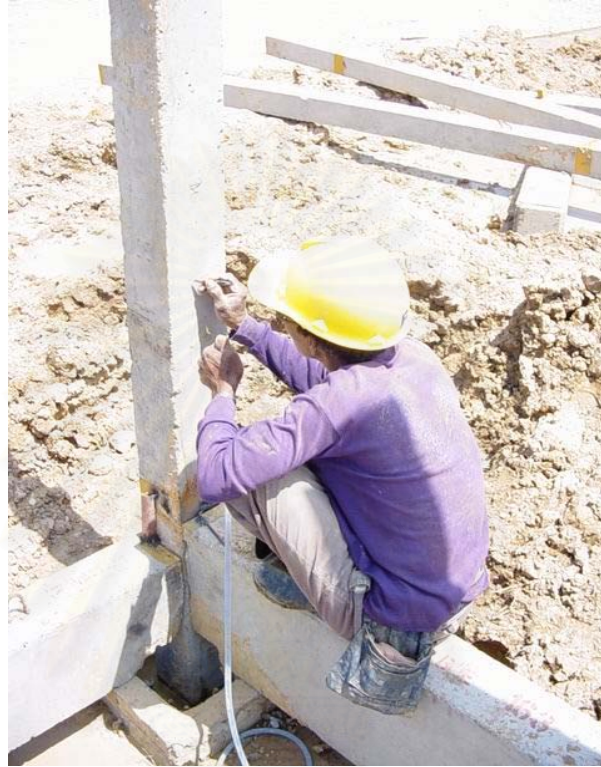
ภาพที่ 5.39 ช่างถ่ายระดับ (+1.00 ม.จากถนน) ลงบนเสาทุกต้นโดยใช้สายยางน้ำ
