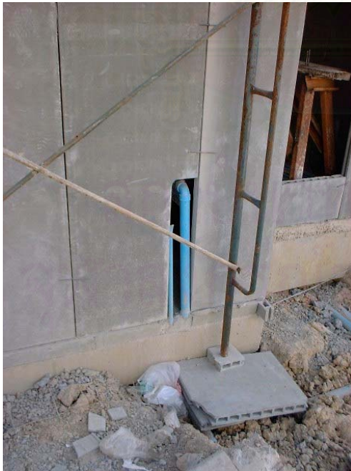
ภาพที่ 5.81 การฝังท่อไปกับผนังตัดแต่งได้ง่าย ภาพที่ 5.82 ท่อบางส่วนฝังมาในชั้นสำเร็จรูป
