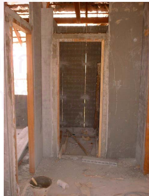
ภาพที่ 5.79 วงกบไม้ที่หล่อเอ็นทับหลังแล้ว
