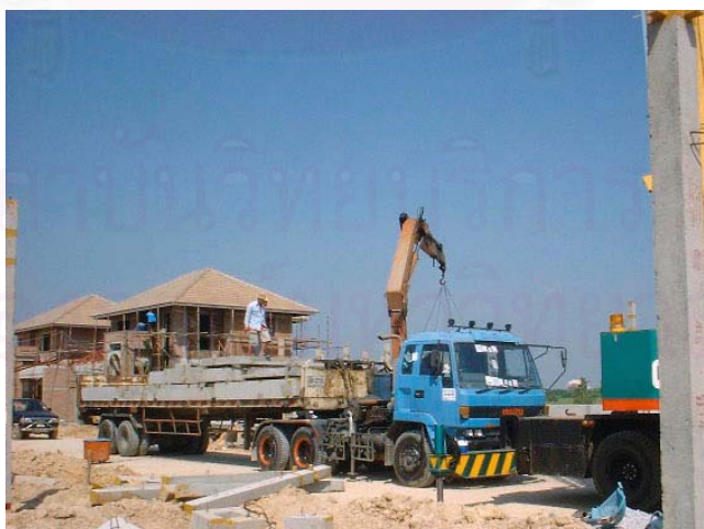
ภาพที่ 5.18 รถบรรทุก 16 ล้อ (Trailer) ที่ใช้ในการขนส่งชิ้นส่วนคอนกรีตสำเร็จรูป
