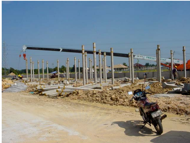
ภาพที่ 5.95 ถนนคอนกรีตเพิ่งสร้างเสร็จต้องบ่มคอนกรีต รถCrane เข้าไม่ได้ จึงต้องเข้าไปตั้ง Crane ในฝั่งด้านหลังฝั่งก่อสร้าง
