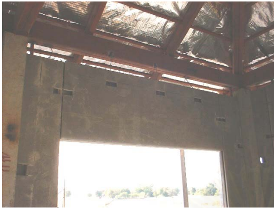
ภาพที่ 5.115 การติดตั้งแผ่นผนังกับอะไหล่เหล็ก ภาพที่ 5.116 อุปกรณ์การยึดเกาะแผ่น
