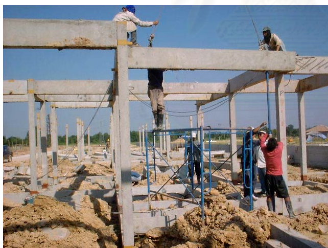
ภาพที่ 5.108 การติดตั้งคานยื่นตัว U ที่ต้องค้ำยัน ภาพที่ 5.109 บริเวณที่เกิดการแตก (Crack)
