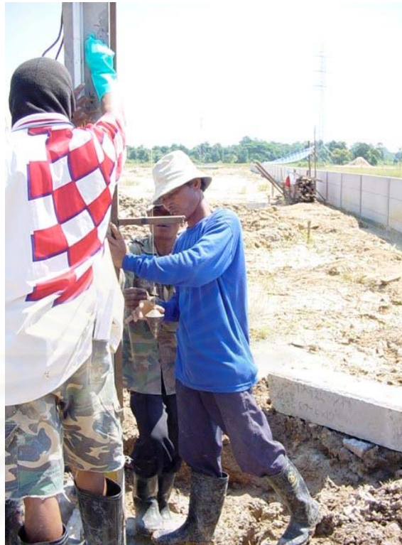
ภาพที่ 5.37 การจับตั้งเสา
