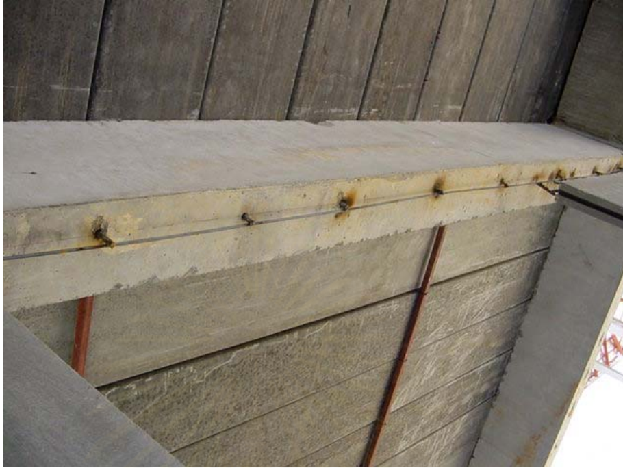
ภาพที่ 5.69 การยึดแผ่นผนังไว้กับคาน หลังจากได้ตั้งผนังแล้ว
