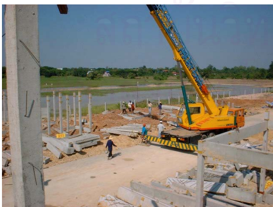
ภาพที่ 6.1 การยกชิ้นส่วนต้องไม่มีสิ่งกีดขวาง
