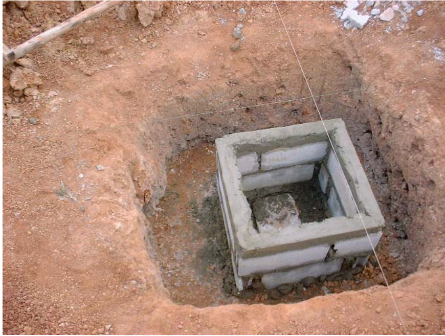
ภาพที่ 5.28 อีฐบล็อคอที่ก่อเป็นแบบเทฐานรากตอม่อ
