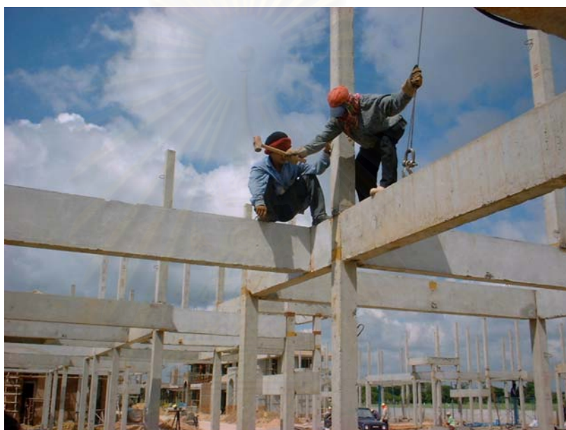
ภาพที่ 5.99 ในการติดตั้งคานชั้นที่ 2 บางครั้งช่างต้องใช้ค้อนกระแทก หรือ ใช้เหล็กงัดคานลงในช่วงเสา เนื่องจากระยะระหว่างเสานั้นแคบไป
