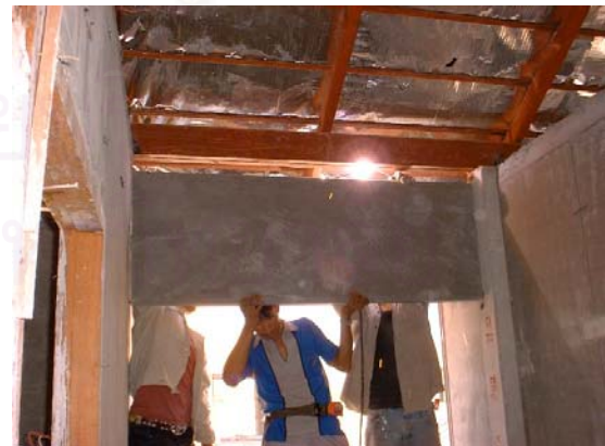
ภาพที่ 5.118 การติดตั้งขวางแผ่นผนังส่วนช่องเปิด
