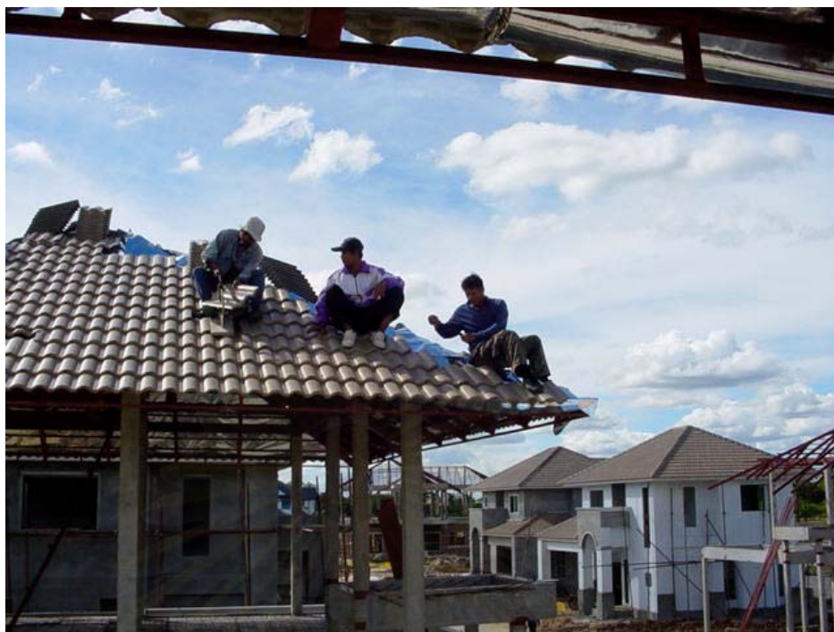
ภาพที่ 5.66 ช่างทำการวัด และกระเบื้องคอนกรีต และนำมาปูในบริเวณมุมหลังคา
