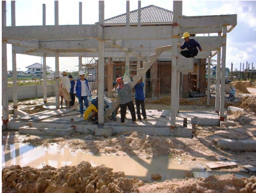
ภาพที่ 5.57 การยกติดตั้งแม่บันไดสำเร็จรูป
