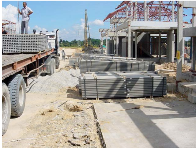
ภาพที่ 5.19 รถบรรทุก 16 ล้อ (Trailer) ยกแผ่นผนังไฟเบอร์ซีเมนต์กึ่งกลางลงสถานที่ก่อสร้าง
