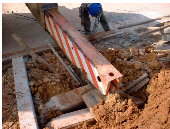
ภาพที่ 6.2 การรองฐานCrane ต้องแข็งแรงพอ
