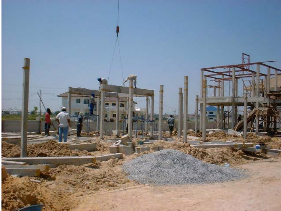
ภาพที่ 5.51 การยกคานชั้นที่ 2 ให้ต่อเนื่องกันเป็นโครง (ตั้งโต๊ะ)
