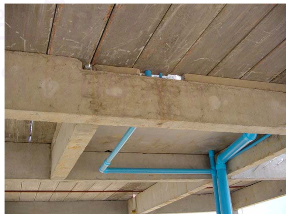
ภาพที่ 5.81 การฝังท่อไปกับผนังตัดแต่งได้ง่าย ภาพที่ 5.82 ท่อบางส่วนฝังมาในชั้นสำเร็จรูป
