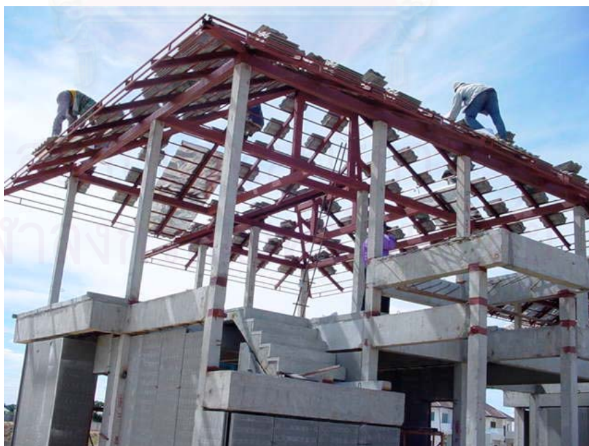
ภาพที่ 5.65 การลำเลียงแผ่นกระเบื้องขึ้นวางกระจายบนหลังคา และปูฉนวนแบบพอยล์
