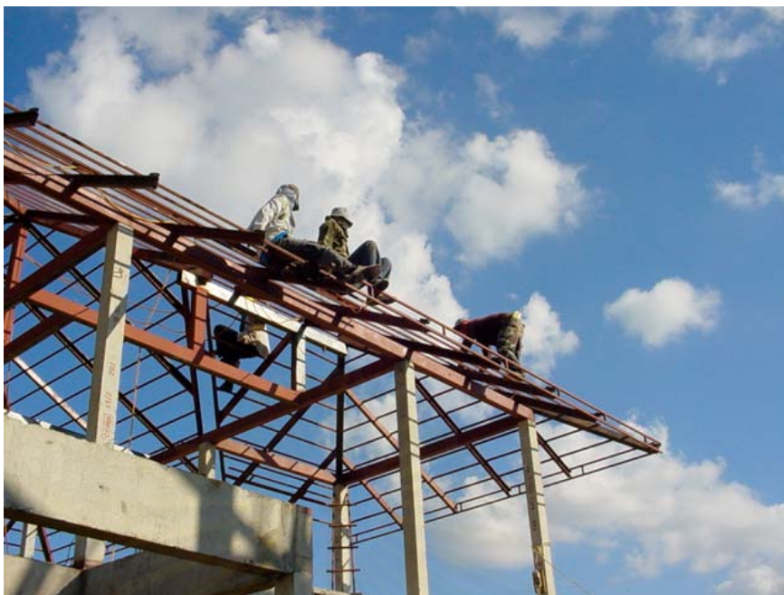
ภาพที่ 5.64 ช่างทำการเชื่อมระแนง
