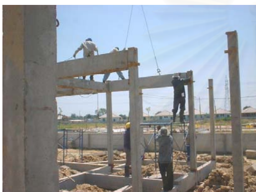
ภาพที่ 5.103 การติดตั้งคานชั้นที่2บางตัว ระยะเสาแคบ เสียเวลางัด ดึงเอาคานลง
