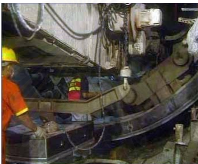
รูปที่ 4.31 เครื่องยกตาดูโมงค์ยกตาดูโมงค์ไปวางด้านหลังหัวเจาะ
