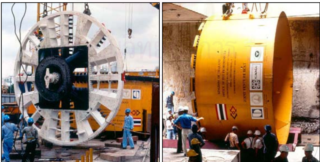
รูปที่ 4.19a การยกเครื่องชุดเจาะลงไปในสถานีเพื่อประกอบและติดตั้ง
