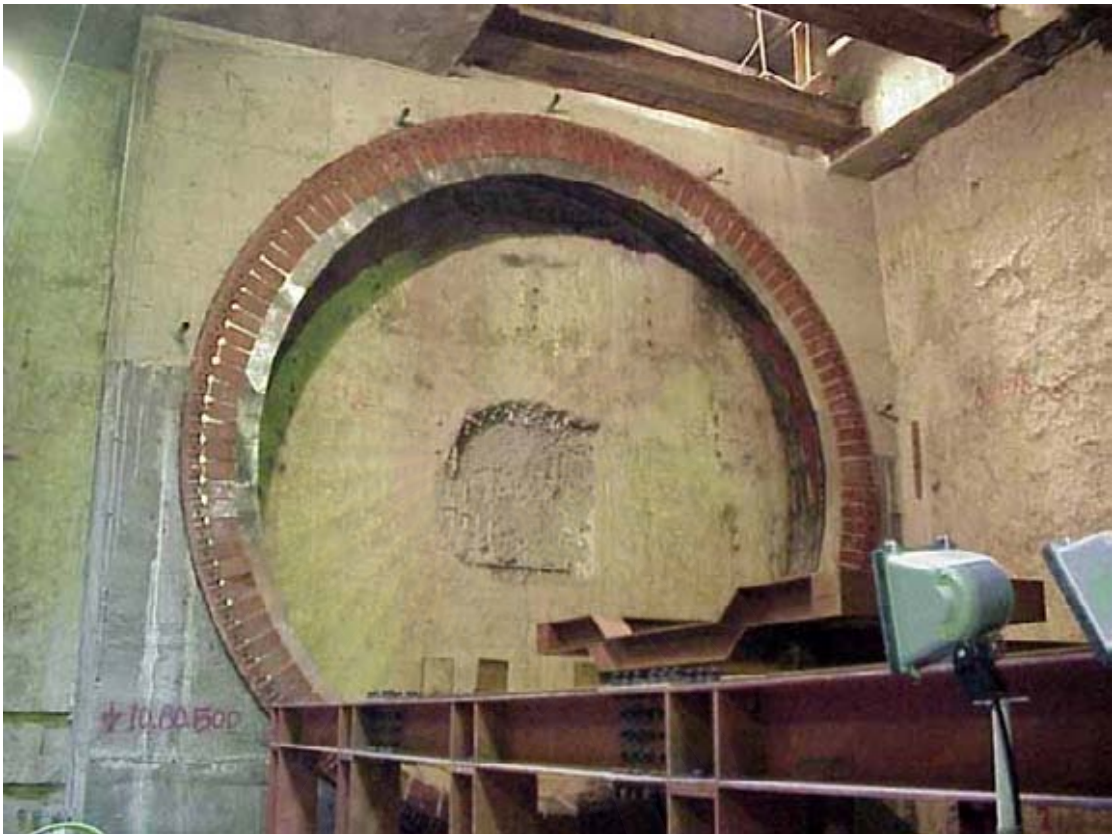
รูปที่ 4.18 ตำแหน่งแนวที่จะสกัดช่องเปิดของสถานี
