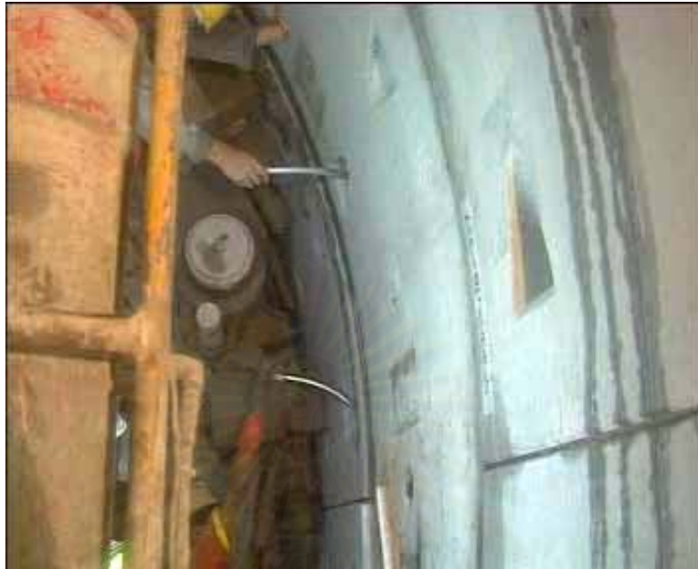
รูปที่ 4.33 การยึดตาดคูโมงค์ด้วยสลักโค้งปลายเกลียวรูปตัวยู
