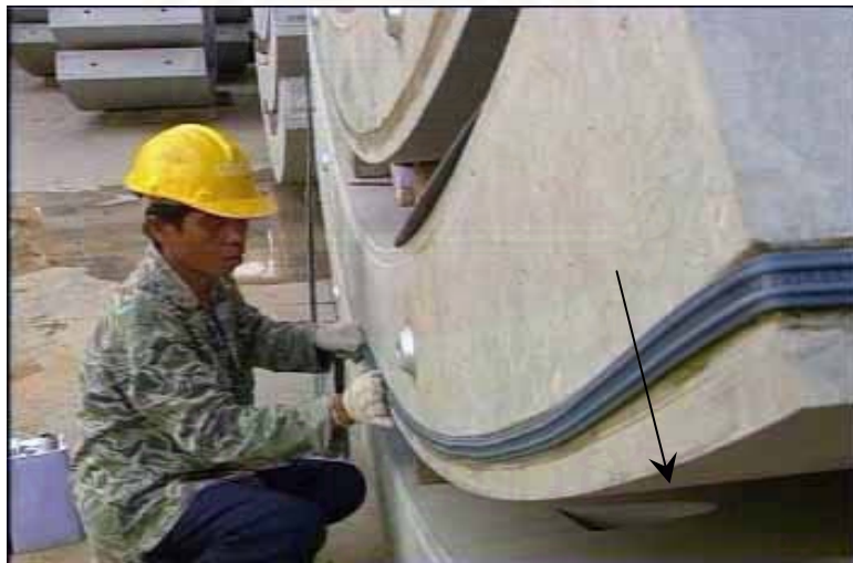
รูปที่ 4.34 การติดตั้งยางกันซึม (Hydro Filling Seal)
