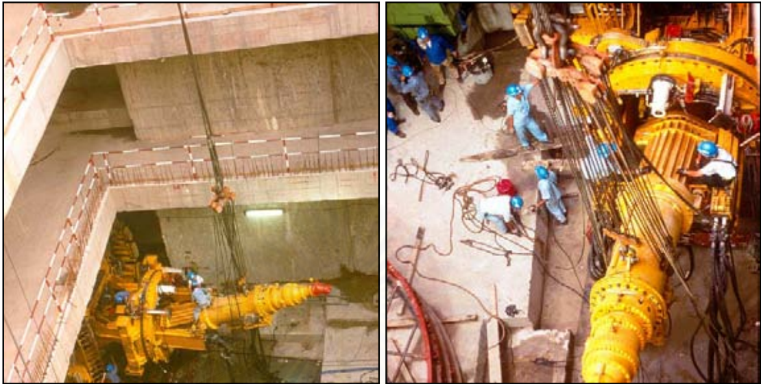
รูปที่ 4.19b การยกเครื่องขุดเจาะลงไปในพื้นที่เพื่อประกอบและติดตั้ง
