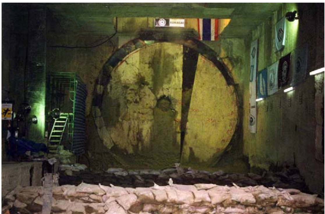
รูปที่ 4.24 เครื่องขุดเจาะอุโมงค์เจาะทะลุผ่านผนังสถานีช่วงหัวลำโพง-ห้วยขวาง (ส่วนใต้)
