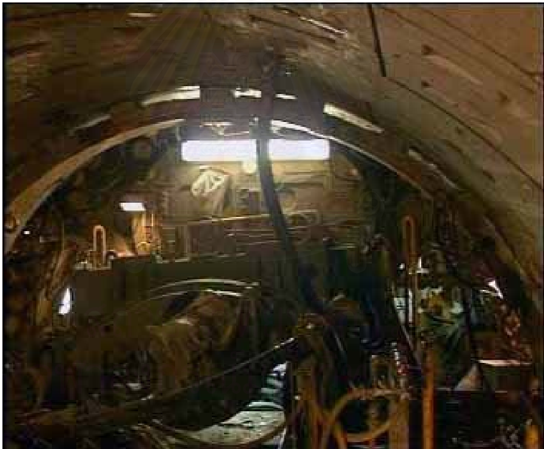
รูปที่ 4.15 การ Grout น้ำปูนผ่านตาดูโมงค์
