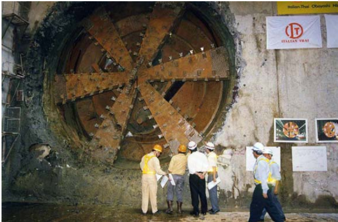
รูปที่ 4.23 เครื่องขุดเจาะอุโมงค์เจาะทะลุผ่านผนังสถานีช่วงห้วยขวาง-บางซื่อ (ส่วนเหนือ)
