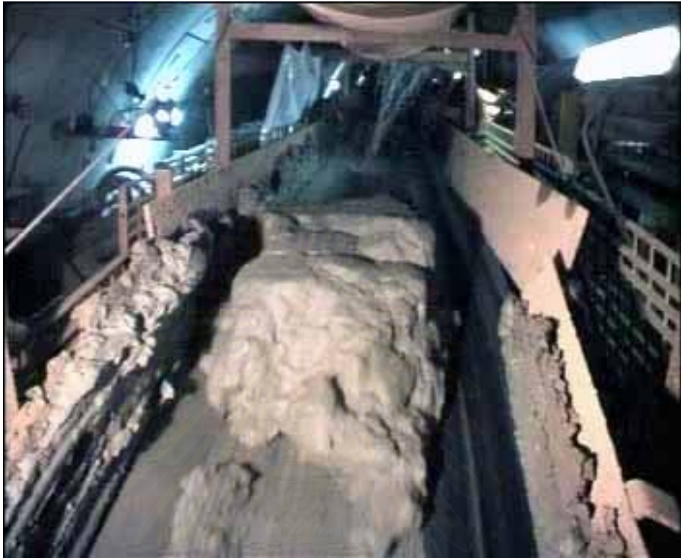
รูปที่ 4.10 ดินที่ถูกลำเลียงออกมาโดย Belt Conveyor
