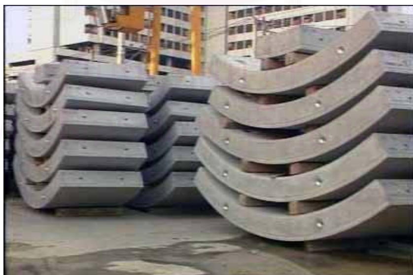
รูปที่ 4.26 คานาดูโมงค์คอนกรีตเสริมเหล็ก
