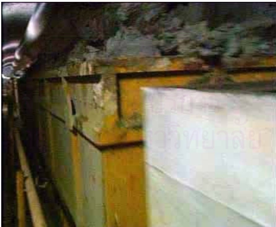
รูปที่ 4.22 รถขนดินออกไปนอกอุโมงค์
