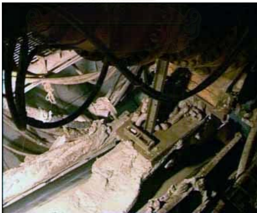
รูปที่ 4.9 ดินที่ถูกลำเลียงออกมาโดย Screw Conveyor
