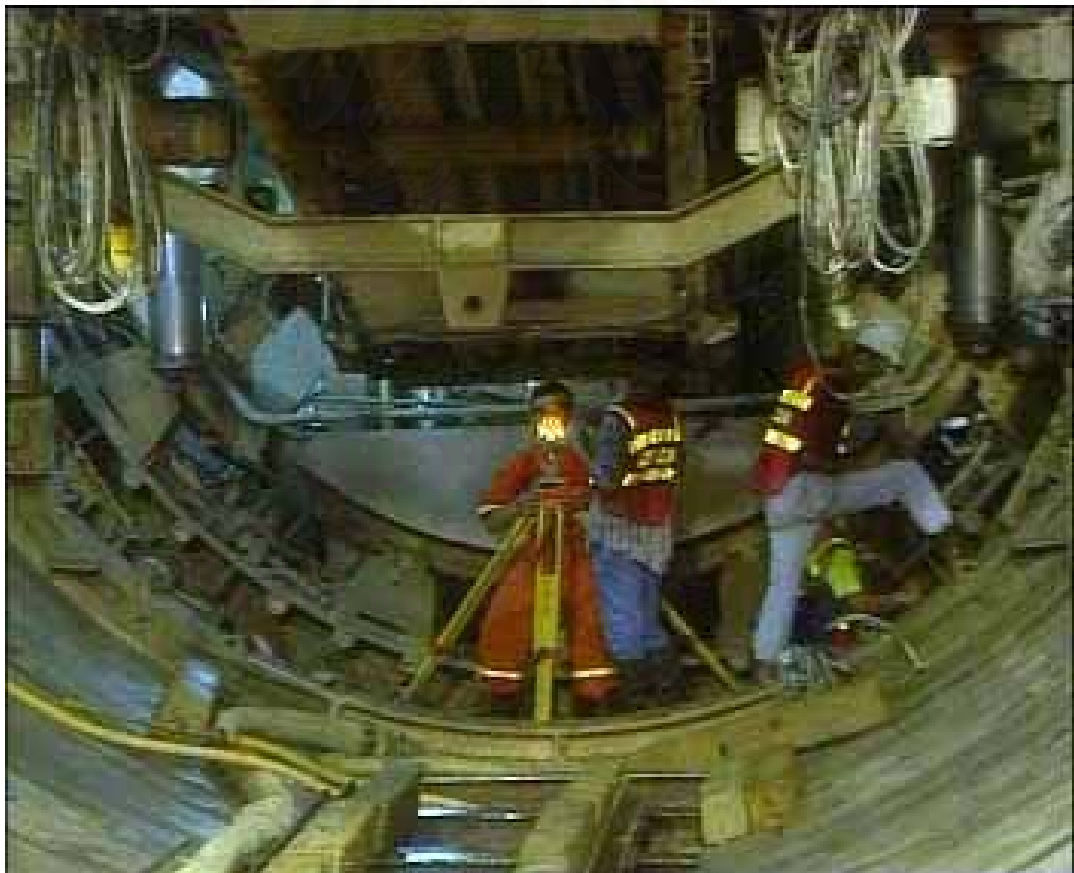
รูปที่ 4.35 การสำรวจแนวขุดเจาะอุโมงค์โดย Manual Survey
