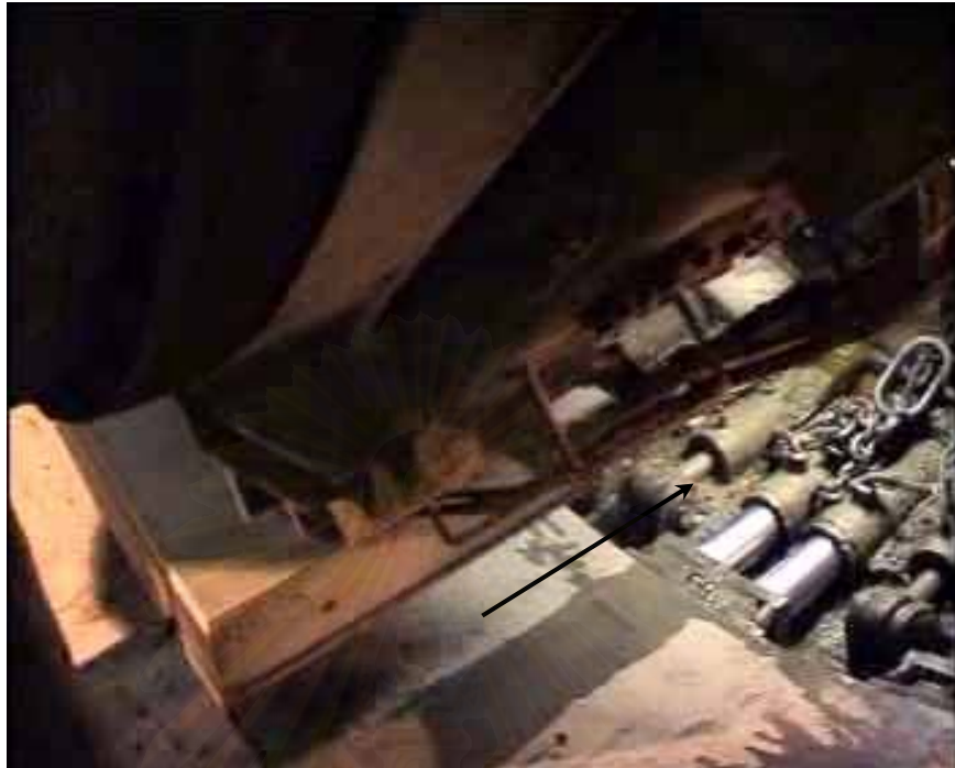
รูปที่ 4.12 การลดระยะของ Thrust Jack เพื่อติดตั้งดาตคูโมงค์
