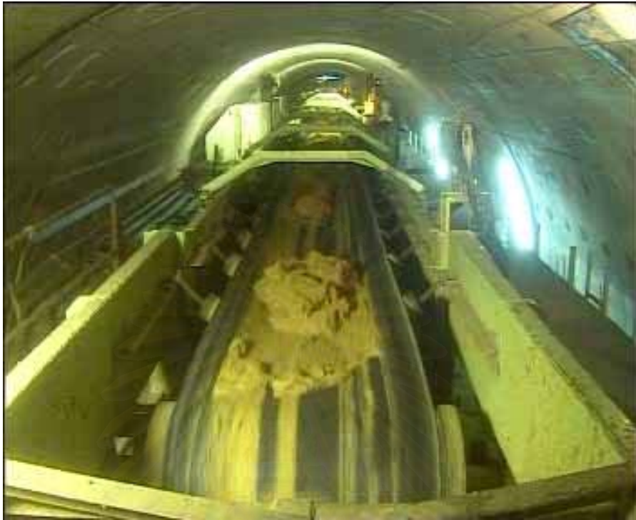
รูปที่ 4.21 ดินจากการขุดเจาะจะถูกส่งมาตามสายพานลำเลียง
