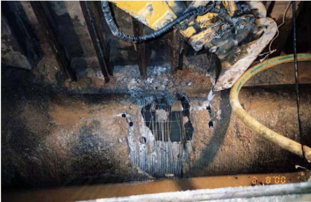
รูปที่ 5.13a ถนนเกิดการทรุดประมาณ 250 มิลลิเมตร ทำให้น้ำท่วมขึ้นมา อันเนื่องมาจากท่อส่งน้ำประปาแตกเสียหาย (MRTA, 2000)
