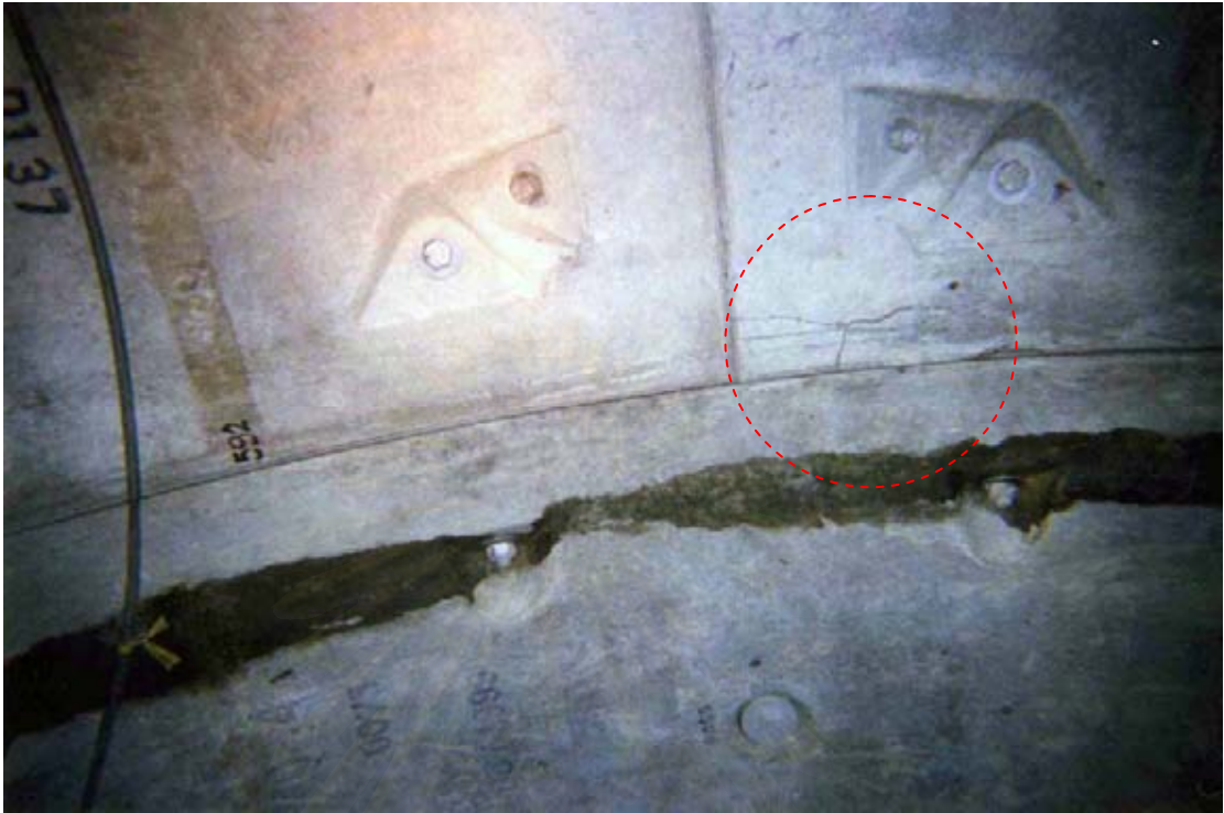
รูปที่ 5.23 ลักษณะของดาดอุโมงค์ที่แตกร้าว
