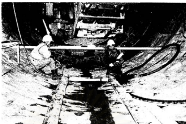
รูปที่ 4.36 การตรวจสอบแนวโดย Manual Survey
