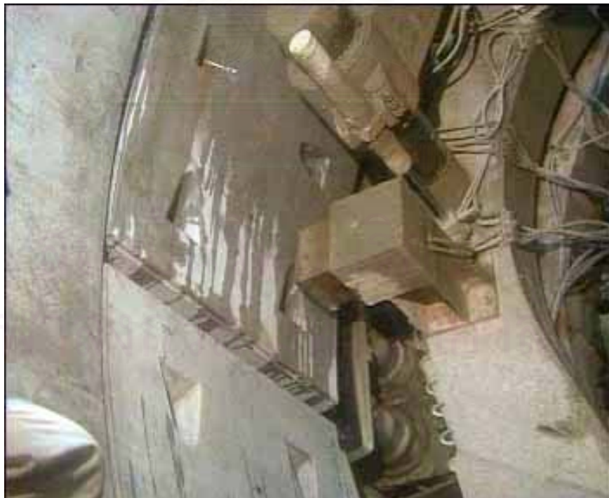
รูปที่ 4.13 เครื่องติดตั้งดาตคูโมงค์
