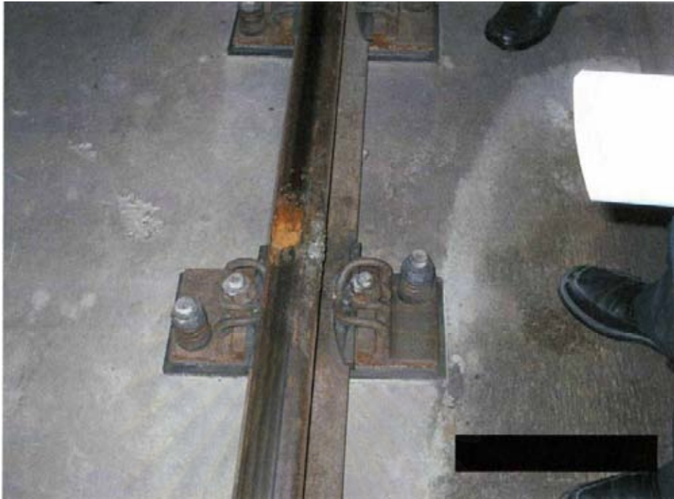
รูปที่ 5.16 น้ำรั่วซึมผ่านดาดคูโมงค์แล้วหยดลงรางรถไฟ (Rail)
