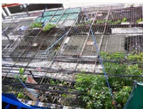
สภาพอาคารพาณิชย์ในซอยละลายทรัพย์
