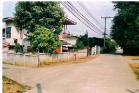
รูปที่ 29 แสดงรั้วคอนกรีตบล็อก
