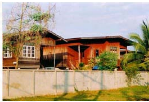
รูปที่ 17 พื้นที่ส่วนพักอาศัยใหม่และภูมิทัศน์
