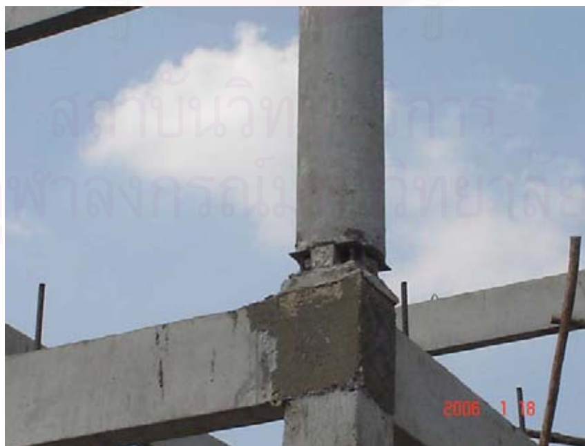
ภาพที่ 5.38 แสดงการเทคอนกรีต (Grouting) ด้วย Non Shrink Sika 731 ที่รอยต่อเสา-คาน
