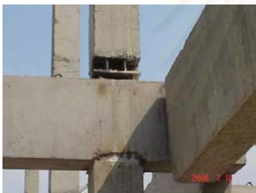
ภาพที่ 5.36 แสดงการเชื่อมต่อของคานชั้นบน
