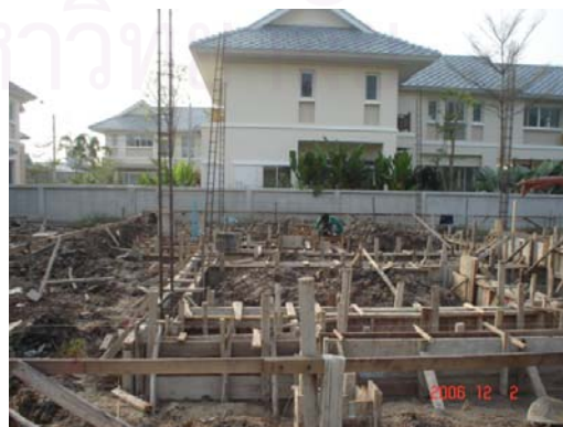
ภาพที่ 5.68 แสดงการเข้าแบบคานคอดิน
