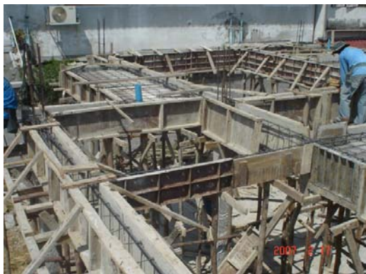
ภาพที่ 5.77 แสดงการเข้าแบบคานชั้นที่ 2
