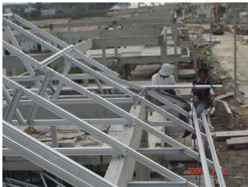
ภาพที่ 5.86 แสดงการติดตั้งโครงหลังคาสำเร็จรูป
