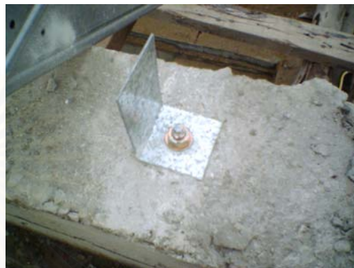
ภาพที่ 5.47 แสดงการติดตั้งตัวยึดโครงถัก
