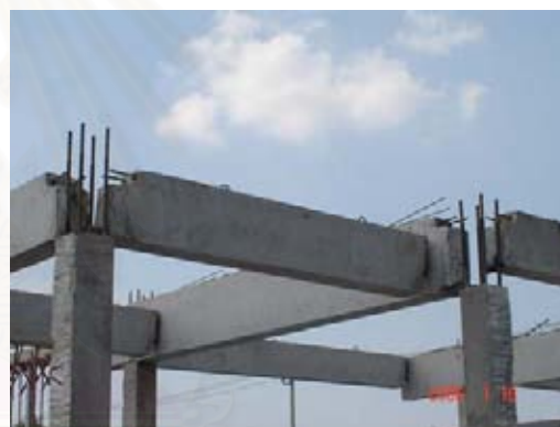
ภาพที่ 5.37 แสดงการรวมการเชื่อมต่อของคานชั้นบน
