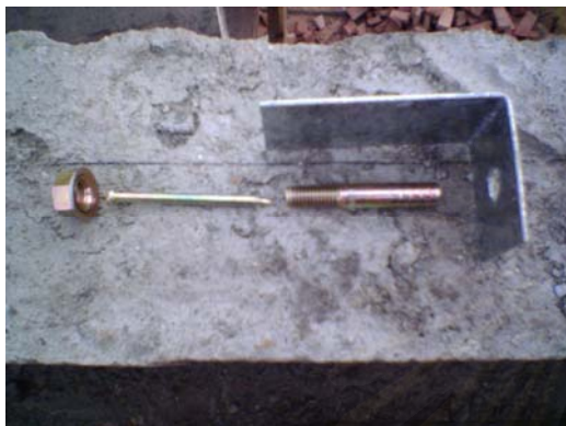
ภาพที่ 5.46 แสดงส่วนประกอบของตัวยึดโครงถัก
