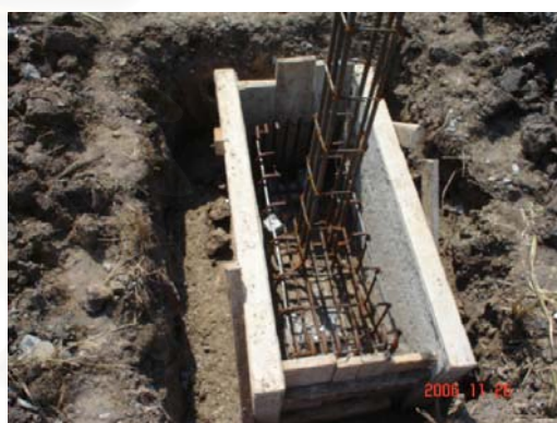
ภาพที่ 5.66 แสดงการเข้าแบบฐานรากก่อนเทคอนกรีต
