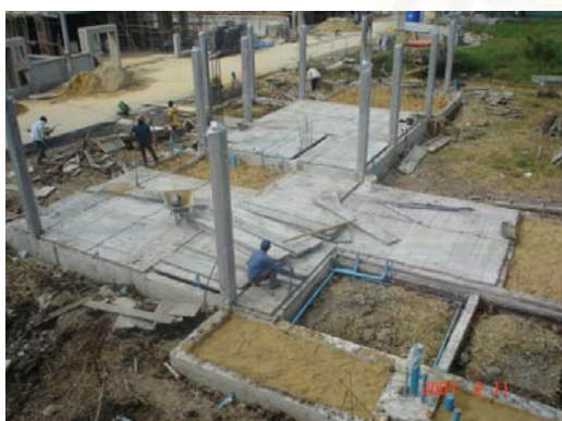
ภาพที่ 5.75 แสดงการวางแผ่นพื้นสำเร็จรูปชั้นที่ 1
