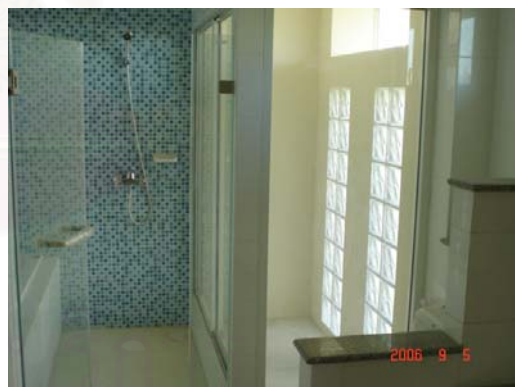
ภาพที่ 5.63 แสดงงานกระเบื้องภายในบ้าน
