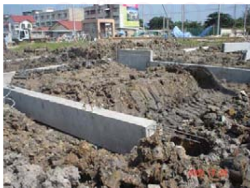
ภาพที่ 5.11 แสดงการวางคานคอดินสำเร็จรูป
