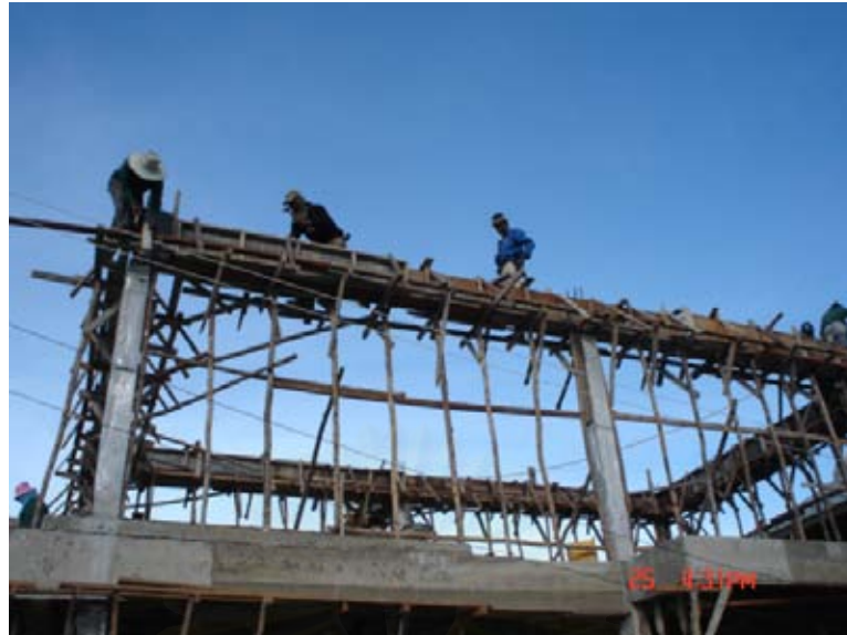
ภาพที่ 5.85 แสดงการเข้าแบบคานคอนกรีตเสริมเหล็กกับโครงหลังคา
