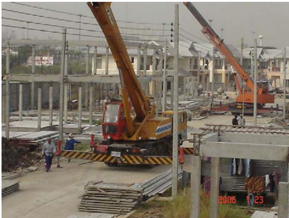
ภาพที่ 5.3 แสดงการยกชิ้นส่วนสำเร็จรูปเพื่อการติดตั้ง
