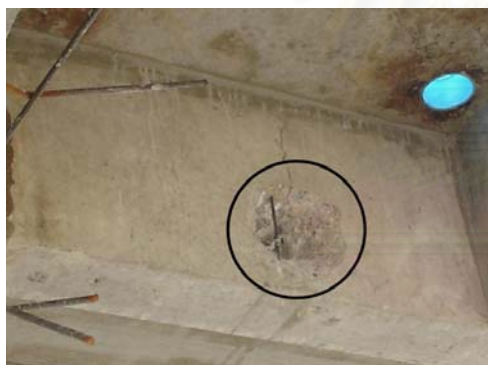
ภาพที่ 5.101 แสดงคานที่ไม่ได้เตรียมตำแหน่งท่อ
