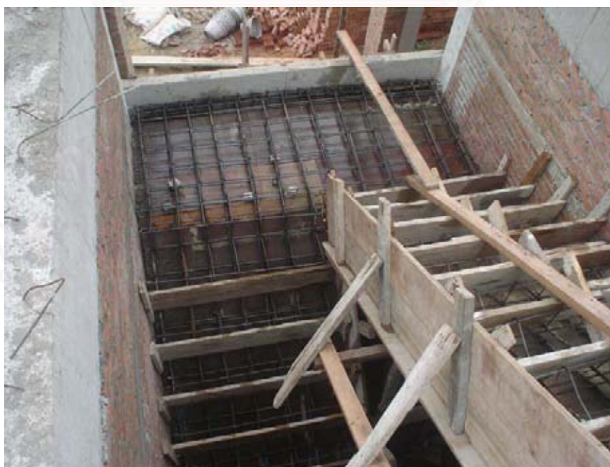
ภาพที่ 5.82 แสดงการเข้าแบบบันได และเหล็กโครงสร้างบันได ก่อนการเทคอนกรีต
