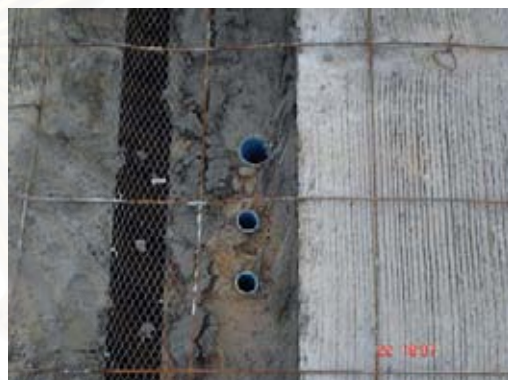
ภาพที่ 5.33 แสดงการวางตะแกรงเหล็กสำเร็จรูป
