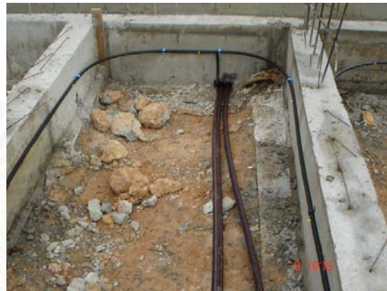
ภาพที่ 5.24 แสดงการวางตำแหน่งท่อระบบกำจัดปลวก
