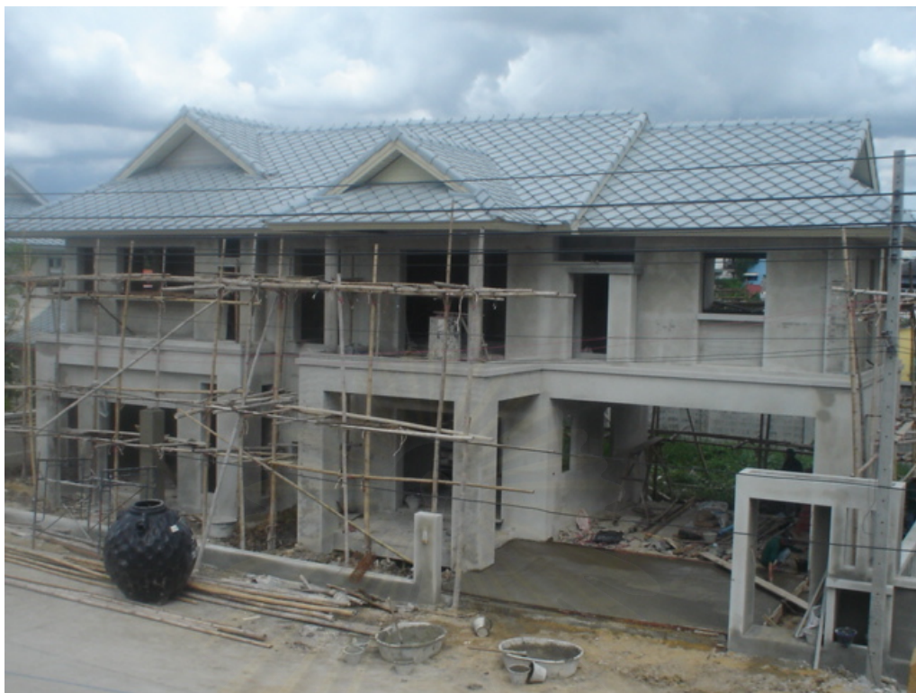
ภาพที่ 5.55 แสดงการฉาบปูนผนังภายนอกอาคาร
