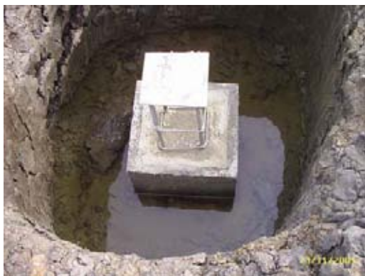
ภาพที่ 5.9 แสดงการเชื่อมแผ่นเหล็กต่อม่อ
