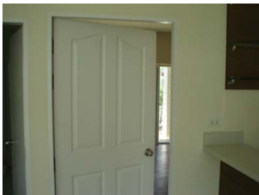
ภาพที่ 5.58 แสดงงานติดตั้งประตู
