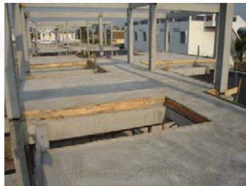
ภาพที่ 5.45 แสดงการกันแบบเทคอนกรีต (Topping)
