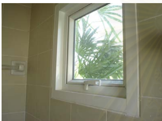
ภาพที่ 5.60 แสดงงานติดตั้งอลูมิเนียม
