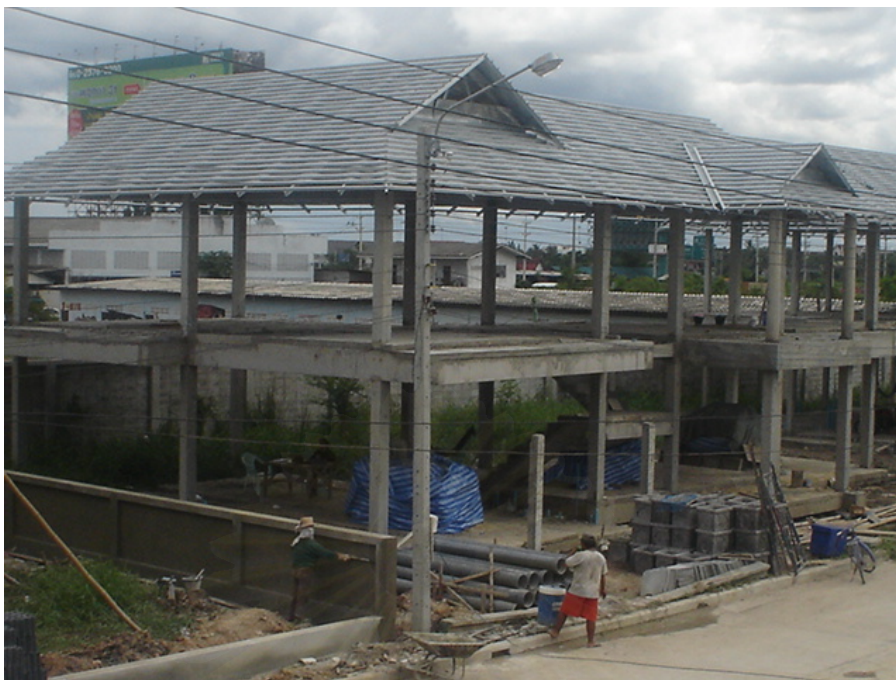
ภาพที่ 5.52 แสดงการติดตั้งโครงหลังคาที่เสร็จเรียบร้อยแล้ว
