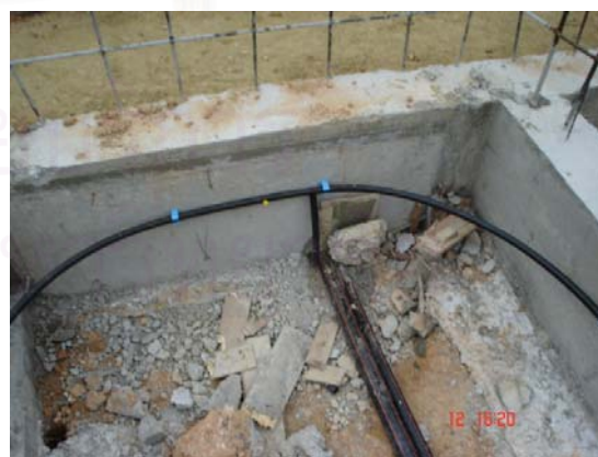
ภาพที่ 5.22 แสดงการเดินท่อไฟฟ้าชั้นล่าง
