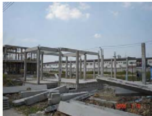
ภาพที่ 5.35 แสดงการรอการเชื่อมต่อของคานชั้นบน
