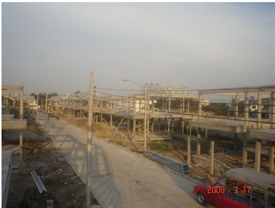
ภาพที่ 7.3 แสดงความสะอาดบริเวณที่ก่อสร้างด้วยระบบสำเร็จรูป
