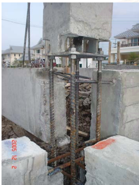
ภาพที่ 5.27 แสดงการเชื่อมต่อเสาชั้นล่าง
