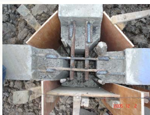
ภาพที่ 5.16 แสดงแบบก่อนเท Non Shrink Sika 731
