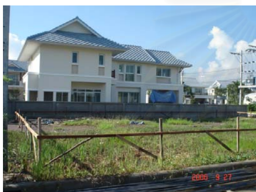
ภาพที่ 5.65 แสดงการเปิดผังเพื่อวางตำแหน่งฐานราก
