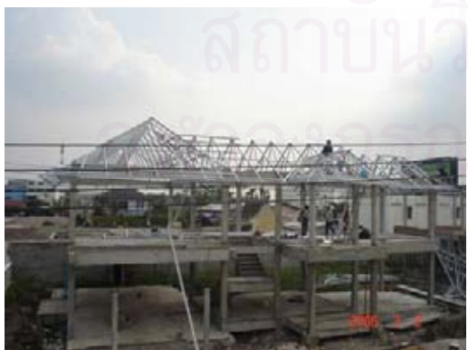
ภาพที่ 5.50 แสดงการติดตั้งโครงหลังคา
