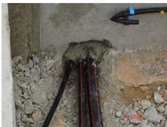
ภาพที่ 5.21 แสดงการเดินท่อไฟฟ้าชั้นล่าง
