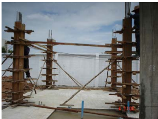
ภาพที่ 5.73 แสดงการเข้าแบบเสาชั้นที่ 1
