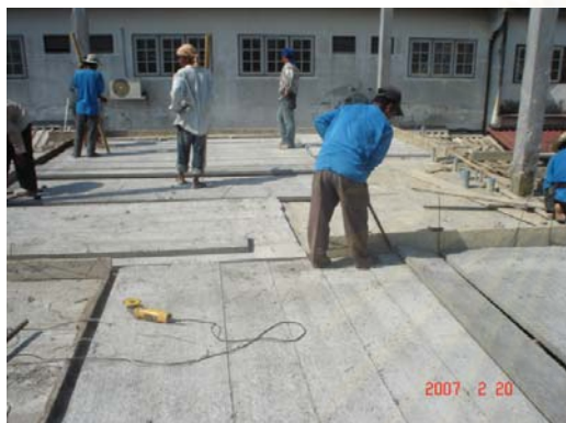
ภาพที่ 5.83 แสดงการวางแผ่นพื้นสำเร็จรูปชั้นที่ 2
