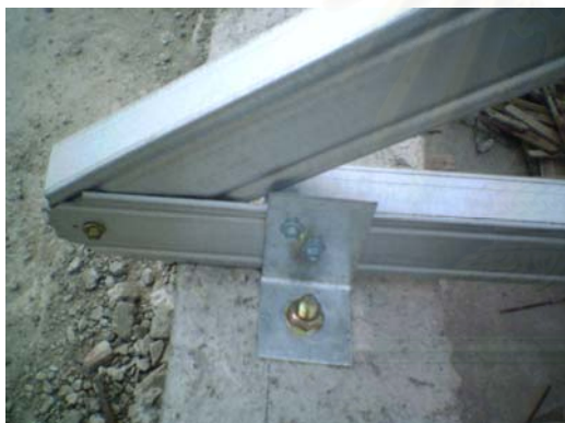
ภาพที่ 5.48 แสดงการติดตั้งตัวยึดเข้ากับโครงถัก
