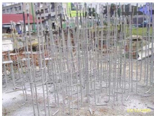
ภาพที่ 5.7 แสดงการเตรียมเหล็กตอม่อ
