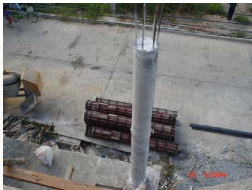
ภาพที่ 5.81 แสดงเสาชั้นที่ 2 ที่หล่อเสร็จแล้ว
