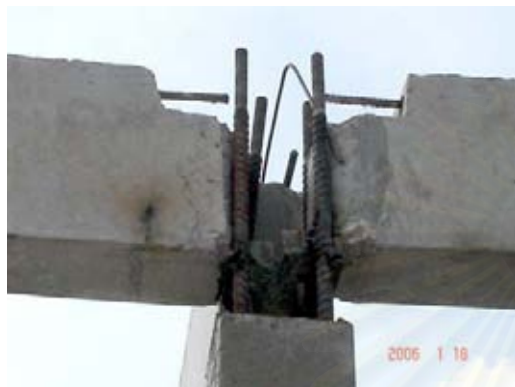
ภาพที่ 5.34 แสดงการเชื่อมต่อของคานชั้นบน
