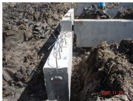
ภาพที่ 5.12 แสดงการวางคานคอดินสำเร็จรูป
