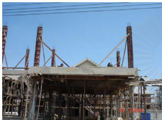
ภาพที่ 5.80 แสดงการเข้าแบบหล่อเสาชั้นที่ 2
