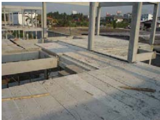
ภาพที่ 5.44 แสดงวางแผ่นพื้นสำเร็จรูปชั้นบน
