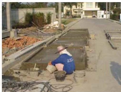
ภาพที่ 5.2 แสดงเก็บรายละเอียดชิ้นส่วนที่หล่อหน้างาน
