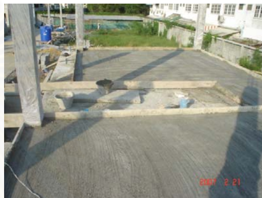
ภาพที่ 5.84 แสดงการเทคอนกรีตทับแผ่นพื้นสำเร็จรูป
