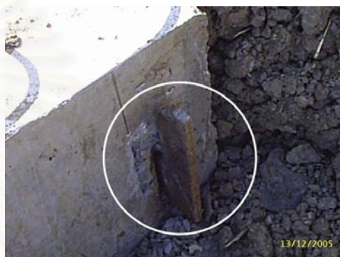
ภาพที่ 5.93 แสดงความคลาดเคลื่อนของสลักเดือย
