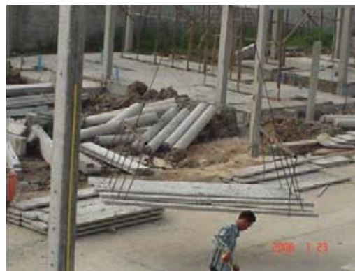
ภาพที่ 5.31 แสดงการยกแผ่นพื้นสำเร็จรูปเพื่อติดตั้ง
