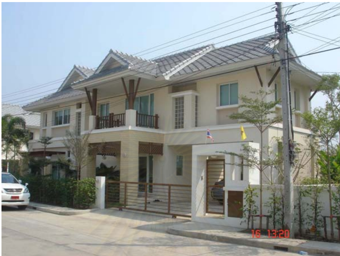
ภาพที่ 5.64 แสดงบ้านที่ก่อสร้างด้วยระบบเสา-คานสำเร็จรูป เมื่อก่อสร้างแล้วเสร็จ
