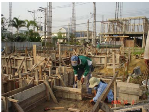
ภาพที่ 5.69 แสดงการเข้าแบบคานคอดิน
