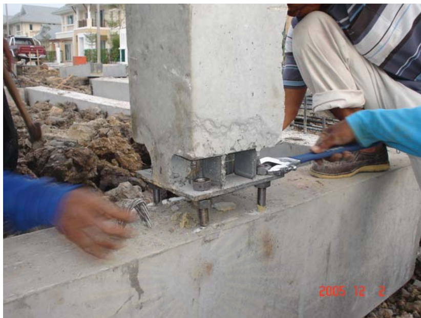
ภาพที่ 5.29 แสดงการปรับระดับเสาชั้นล่าง ก่อนการเทพื้น
