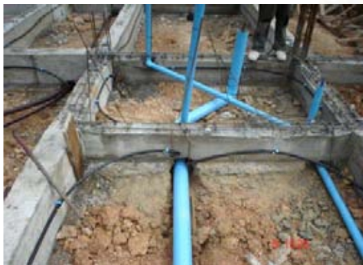
ภาพที่ 5.19 แสดงการวางระบบสุขาภิบาลชั้นล่าง
