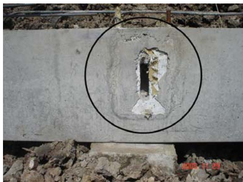
ภาพที่ 5.90 แสดงความคลาดเคลื่อนของช่องข้างคาน
