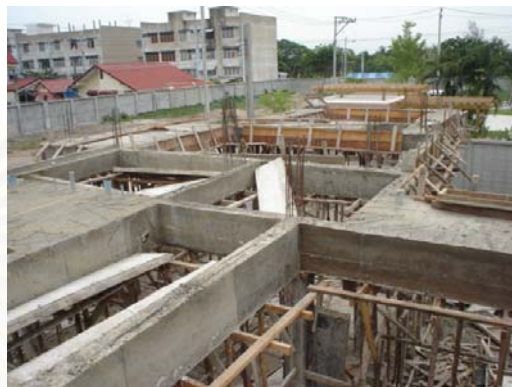
ภาพที่ 5.78 แสดงคานชั้นที่ 2 ที่หล่อเสร็จเรียบร้อยแล้ว
