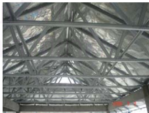
ภาพที่ 5.51 แสดงการใส่แผ่นสังกะสีบางป้องกันหลังคารั่ว
