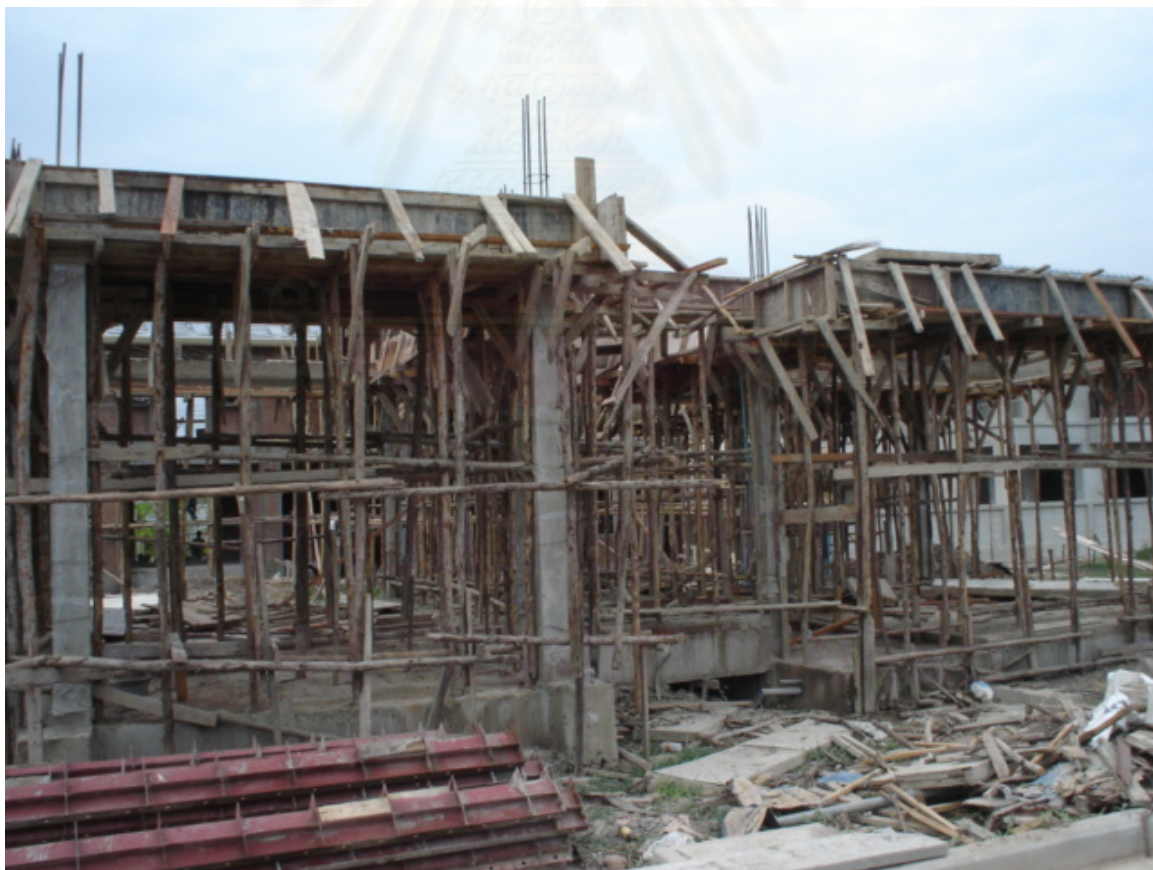
ภาพที่ 5.79 แสดงการเข้าแบบคานชั้นที่ 2
