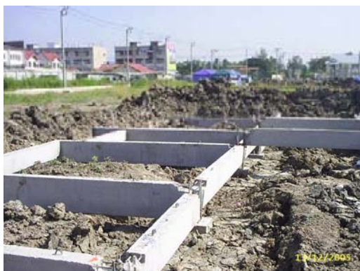
ภาพที่ 5.13 แสดงการวางคานคอดินสำเร็จรูป
