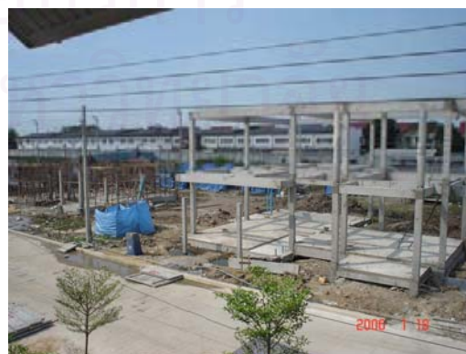
ภาพที่ 7.2 แสดงบริเวณที่ก่อสร้างด้วยระบบสำเร็จรูป
