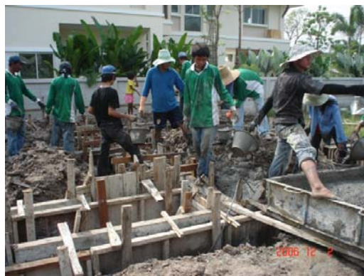
ภาพที่ 5.70 แสดงการเทคอนกรีตคานคอดิน
