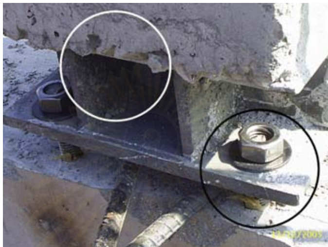
ภาพที่ 5.96 แสดงความผิดพลาดในการตัดนอตปรับระดับ
