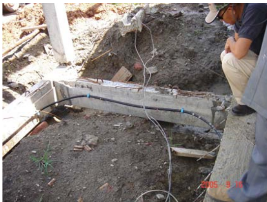
ภาพที่ 5.23 แสดงท่อของระบบกำจัดปลวก
