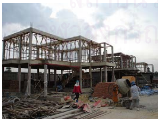
ภาพที่ 7.1 แสดงบริเวณที่ก่อสร้างด้วยระบบเดิม
