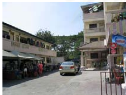
อาคารพักอาศัยรวม ช.ประชากรราษฎร์ ฯ
