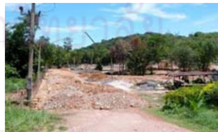
ภาพที่ 2.23 การนำดินถมลงในพื้นที่ก่อสร้าง
