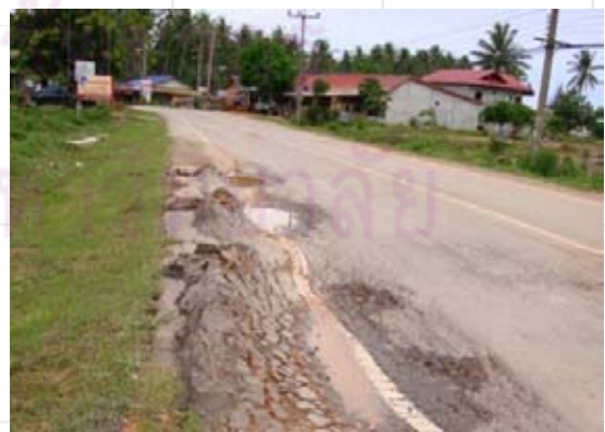
ภาพที่ 2.46 ไหล่ทางทรุดตัวจากรถบรรทุก
