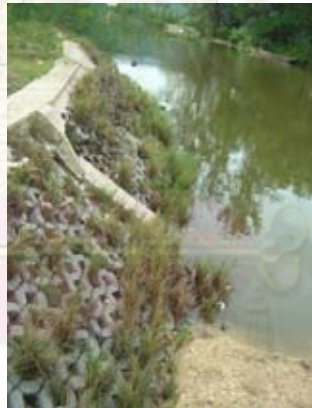
ภาพที่ 2.25 การใช้วัสดุเพื่อลดการพังทลายของริมตลิ่งแต่ในขณะเดียวกันก็เป็นการลดพื้นที่อยู่อาศัยของสัตว์น้ำริมตลิ่ง
