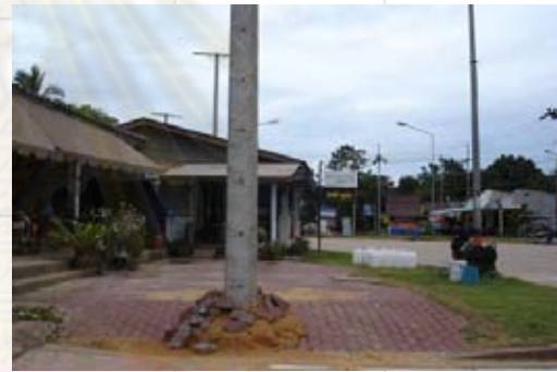
ภาพที่ 2.43 ทางเท้าที่มีสิ่งกีดขวางซึ่งเกิดจากการก่อสร้าง
