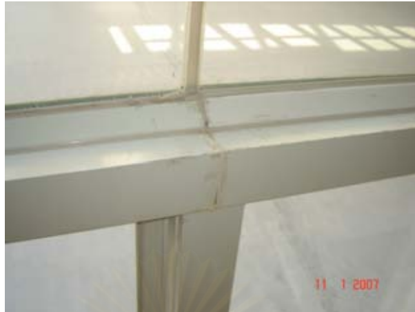
รูปที่ ข.14 แสดงข้อบกพร่องของงานหน้าต่าง ในความไม่เรียบร้อยของการฉีดยึด “อี พ็อก ซี” กันซึม
