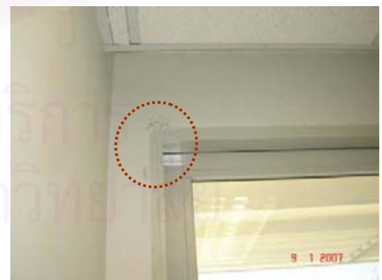
รูปที่ ข.18 แสดงข้อบกพร่องของงานหน้าต่าง จากรอยแตกร้าวบริเวณกรอบ และมุมที่ต่อกับผนัง
