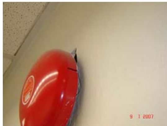
รูปที่ ข.20 แสดงข้อบกพร่องของความไม่พอดี ไม่ลงรอยของชิ้นงานต่างๆ
