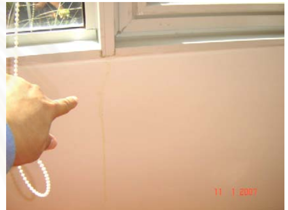
รูปที่ ข.17 แสดงข้อบกพร่องของงานหน้าต่าง จากรอยรั่วซึมของน้ำ
