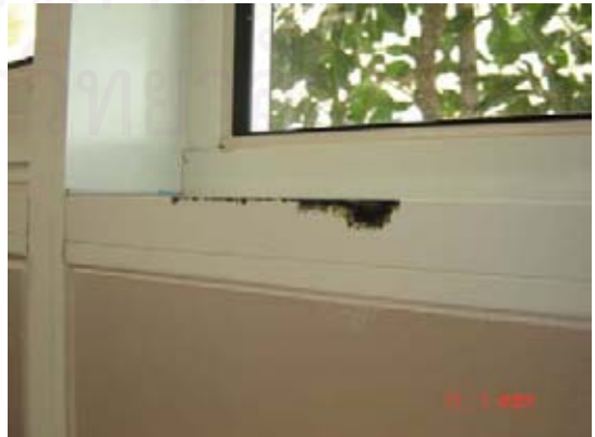
รูปที่ ข.15 แสดงข้อบกพร่องของงานประตู-หน้าต่าง ในส่วนงานที่เป็นรอยเประอะเปื้อนบริเวณชิ้นงานและวงกบ
