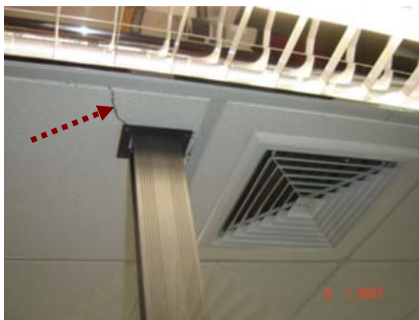
รูปที่ ข.8 แสดงข้อบกพร่องของฝ้าเพดานที่เกิดรอยแตก
