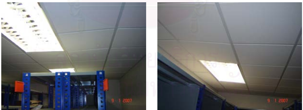
รูปที่ ข.7 แสดงข้อบกพร่องของฝ้าเพดานที่เกิดจากแฉ่นตัว ไม่ได้ระดับ
