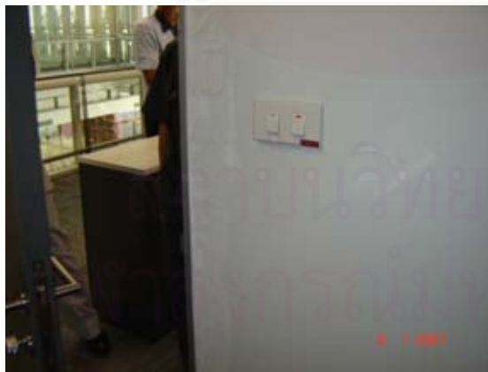
รูปที่ ข.1 แสดงข้อบกพร่องของผนังที่เกี่ยวกับความเรียบ ความเนียนของพื้นผิวผนัง
