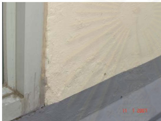
รูปที่ ข.1 แสดงข้อบกพร่องของผนังที่เกี่ยวกับความเรียบ ความเนียนของพื้นผิวผนัง
