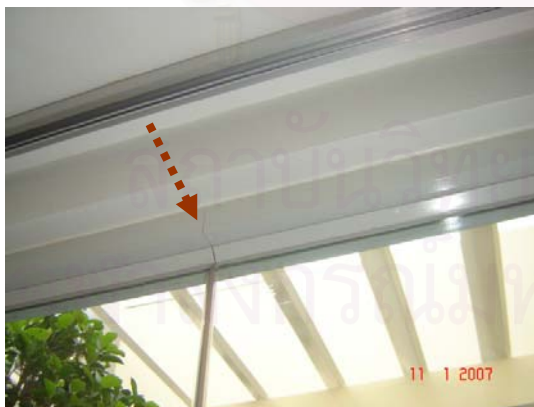
รูปที่ ข.18 แสดงข้อบกพร่องของงานหน้าต่าง จากรอยแตกร้าวบริเวณกรอบ และมุมที่ต่อกับผนัง
