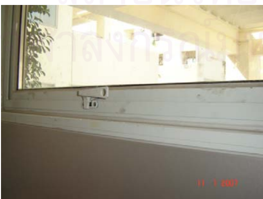
รูปที่ ข.15 แสดงข้อบกพร่องของงานประตู-หน้าต่าง ในส่วนงานที่เป็นรอยเประอะเปื้อนบริเวณชิ้นงานและวงกบ
