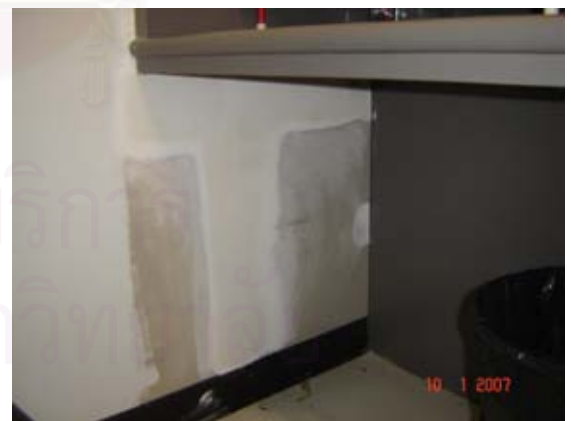
รูปที่ ข.1 แสดงข้อบกพร่องของผนังที่เกี่ยวกับความเรียบ ความเนียนของพื้นผิวผนัง
