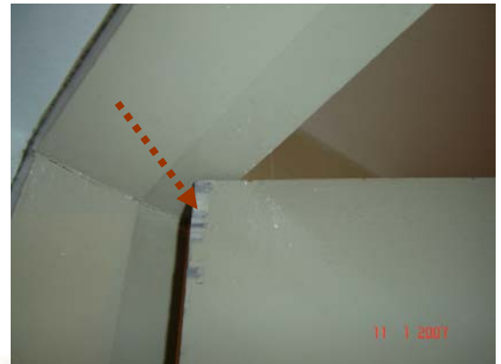
รูปที่ ข.16 แสดงข้อบกพร่องของงานประตู ในด้านความไม่พอดีหรือความลงตัวของชิ้นงานในการติดตั้ง เมื่อเปิด-ปิด จะเกิดมีรอยครูด
