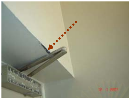
รูปที่ ข.16 แสดงข้อบกพร่องของงานประตู ในด้านความไม่พอดีหรือความลงตัวของชิ้นงานในการติดตั้ง เมื่อเปิด-ปิด จะเกิดมีรอยครูด
