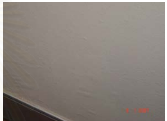
รูปที่ ข.1 แสดงข้อบกพร่องของผนังที่เกี่ยวกับความเรียบ ความเนียนของพื้นผิวผนัง
