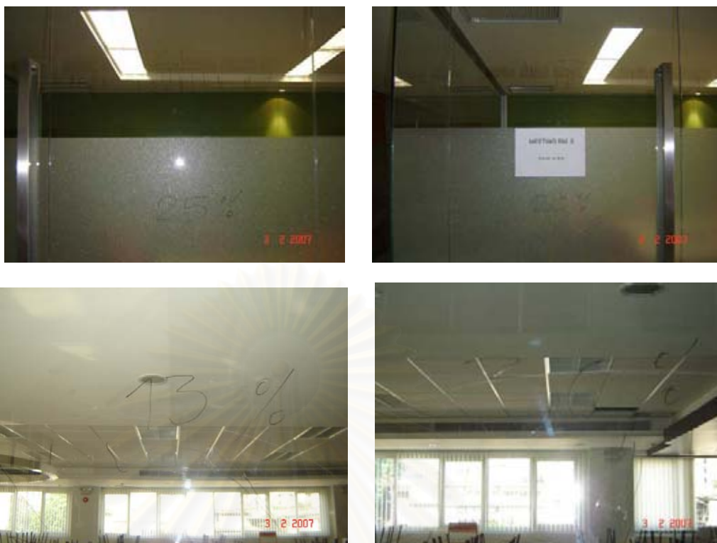
รูปที่ ข.4 แสดงข้อบกพร่องของผนังที่เป็นกระจก ที่เป็นรอยขีดข่วน
