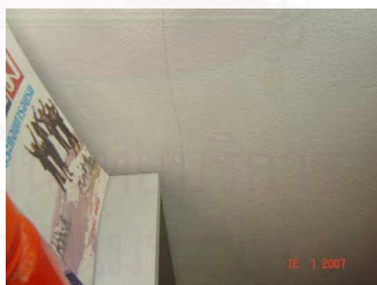
รูปที่ ข.3 แสดงข้อบกพร่องของผนังที่เกี่ยวกับรอยแตกร้าวของพื้นผิวผนัง
