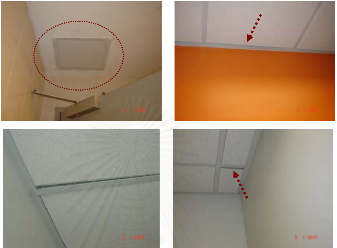
รูปที่ ข.6 แสดงข้อบกพร่องของฝ้าเพดานที่เกิดจากการทำงานที่ไม่เรียบร้อย
