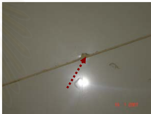
รูปที่ ข.10 แสดงข้อบกพร่องของงานพื้น เนื่องจากความไม่พอดีของการตัดต่อวัสดุปู
