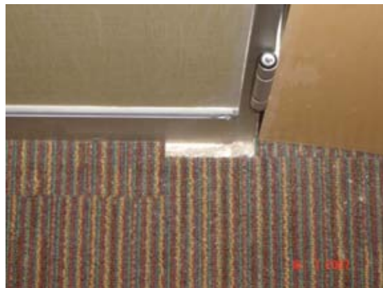
รูปที่ ข.10 แสดงข้อบกพร่องของงานพื้น เนื่องจากความไม่พอดีของการตัดต่อวัสดุปู
