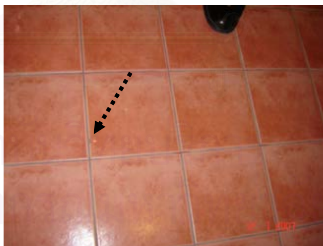
รูปที่ ข.11 แสดงข้อบกพร่องของงานพื้น เนื่องจากรอยร้าว และรอยป็น ของวัสดุปูที่เป็นกระเบื้อง
