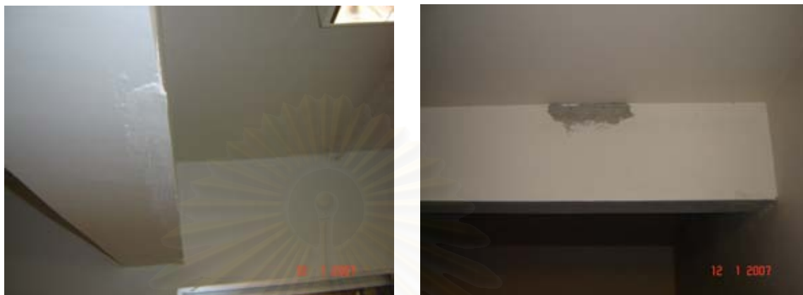
รูปที่ ข.12 แสดงข้อบกพร่องของงานผิวคาน กรณีที่เป็นรูโพรง
