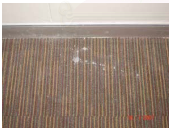
รูปที่ ข.9 แสดงข้อบกพร่องของงานพื้น เนื่องจากรอยหก หยด ของสี
