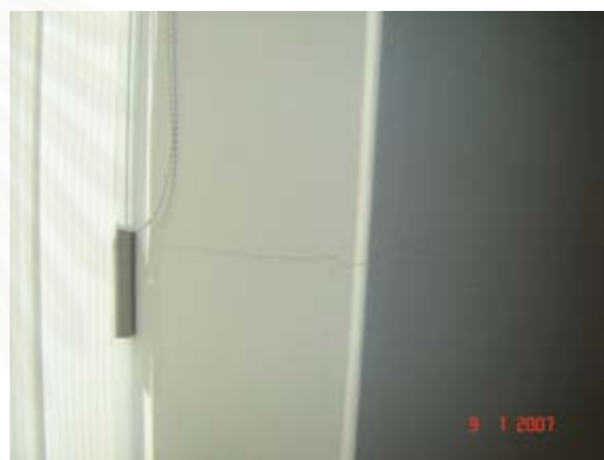
รูปที่ ข.2 แสดงข้อบกพร่องของผนังที่เกี่ยวกับรอยเปื้อน และรอยต่างของพื้นผิวผนัง
