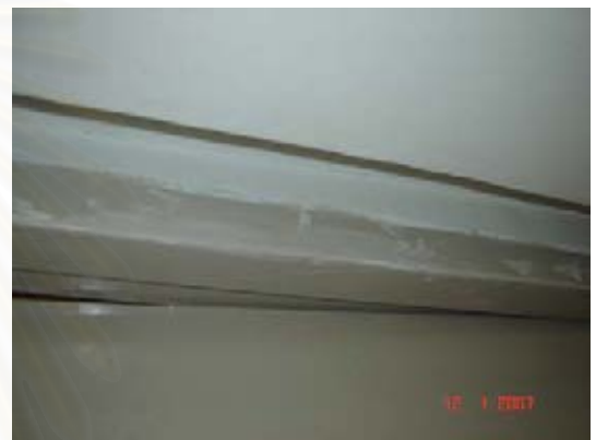
รูปที่ ข.14 แสดงข้อบกพร่องของงานหน้าต่าง ในความไม่เรียบร้อยของการฉีดยึด “อี พ็อก ซี” กันซึม
