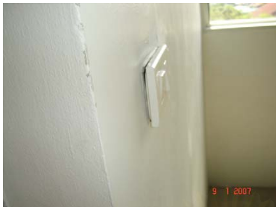
รูปที่ ข.20 แสดงข้อบกพร่องของความไม่พอดี ไม่ลงรอยของชิ้นงานต่างๆ
