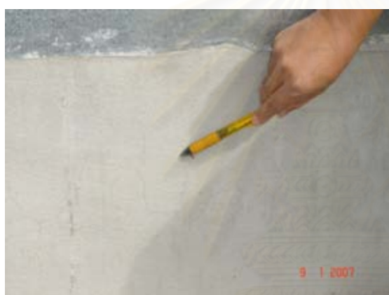
รูปที่ ข.2 แสดงข้อบกพร่องของผนังที่เกี่ยวกับรอยเปื้อน และรอยต่างของพื้นผิวผนัง
