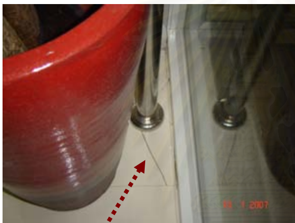
รูปที่ ข.10 แสดงข้อบกพร่องของงานพื้น เนื่องจากความไม่พอดีของการตัดต่อวัสดุปู
