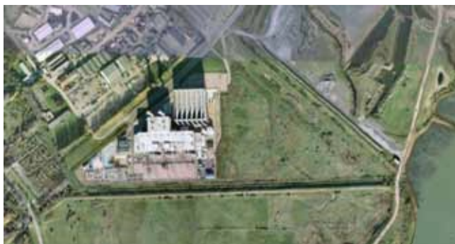
ภาพที่ 2.17 แสดงผังโครงการ Damhead Creek 2 Power Station
