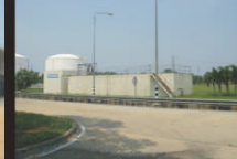
ส่วนบำบัดน้ำเสีย
