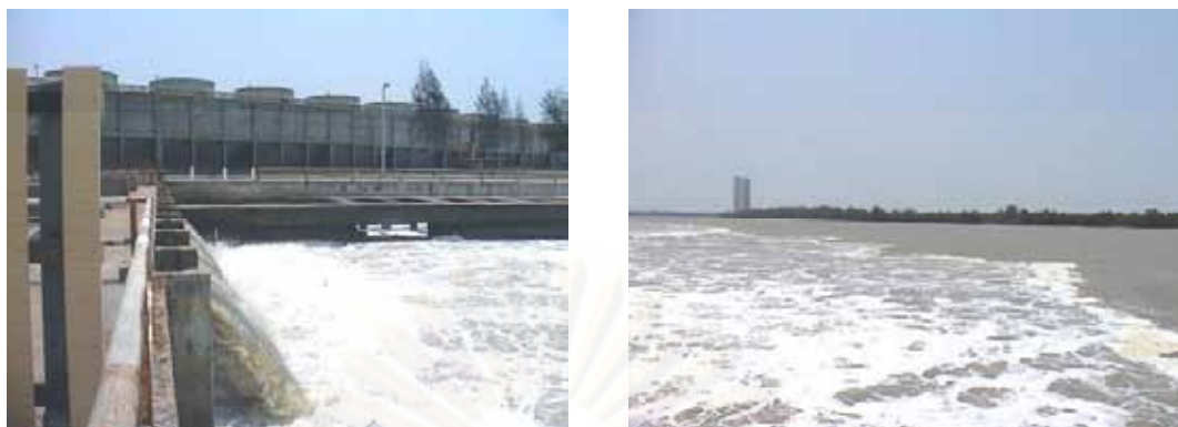
ภาพที่ 3.4 แสดงการปล่อยน้ำจากหอระบายความร้อนลงสู่แม่น้ำบางปะกง
