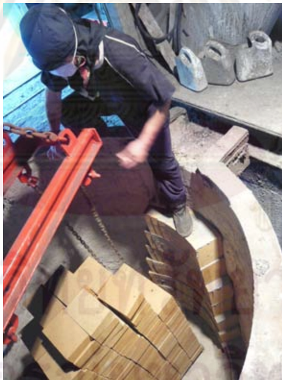
รูปที่ 2-7 การท่อก่เข้รับน้ำเหล็ก
