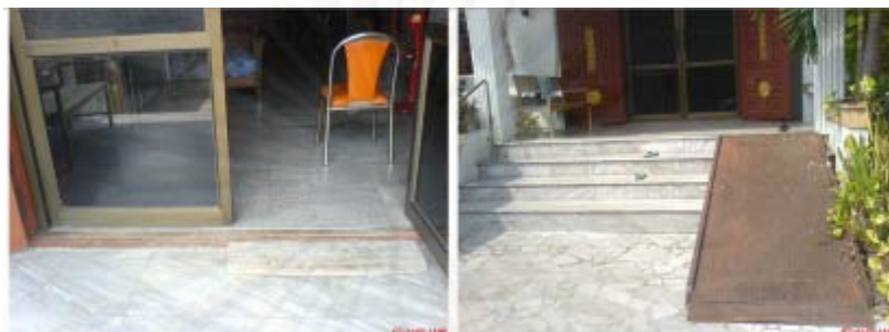
ภาพที่ 4.102 แสดงการติดตั้งทางลาดเพื่อให้ผู้ป่วยสามารถนั่งเก้าอี้รถเข็นผ่านไปได้
