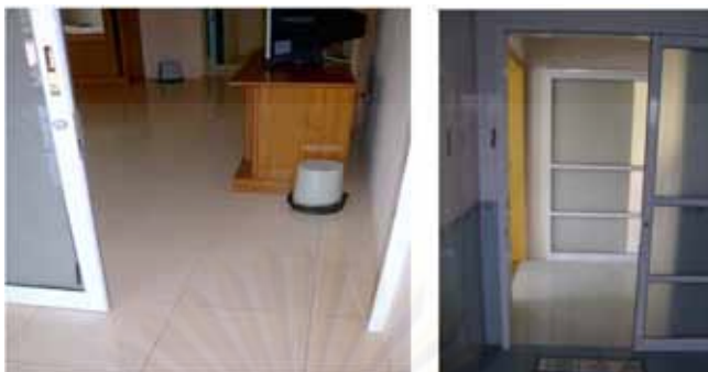
ภาพที่ 2.14 แสดงประตูบานเลื่อนความกว้างไม่น้อยกว่า 90 ซม. และพื้นเรียบเสมอกัน 26
