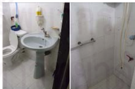
ภาพที่ 4.36 แสดงห้องน้ำที่ติดตั้งราวจับสำหรับผู้ป่วย
