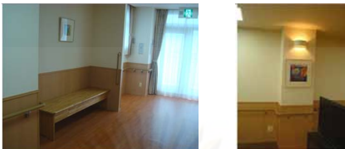
ภาพที่ 2.12 แสดงการติดตั้งราวจับ และไฟฟ้าแสงสว่างบริเวณทางเดินภายใน 24
