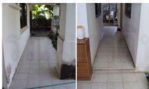
ภาพที่ 4.56 แสดงทางลาดบริเวณทางเข้าหลัก
