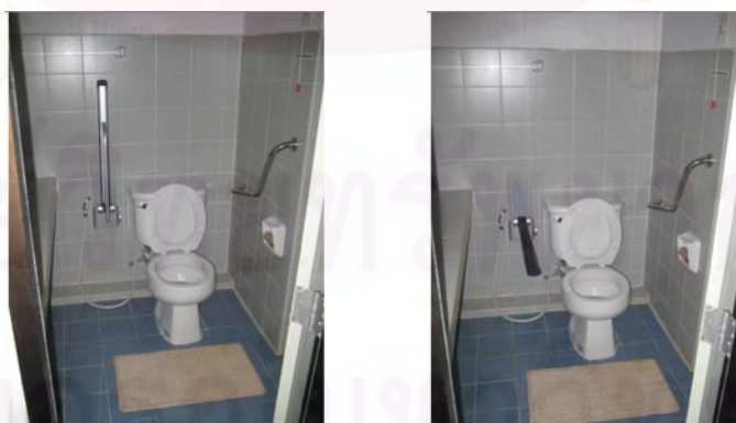
ภาพที่ 2.15 แสดงราวจับแบบโยกขึ้น-ลง สำหรับช่วยพยุงตัวผู้ป่วยขณะลุก-นั่ง 27
