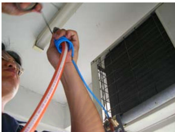
รูปที่ 4.19 แสดงการติดตั้งหัวฉีดแบบ P12 บริเวณหลังชุดคอนเดนเซอร์ของเครื่องปรับอากาศ
