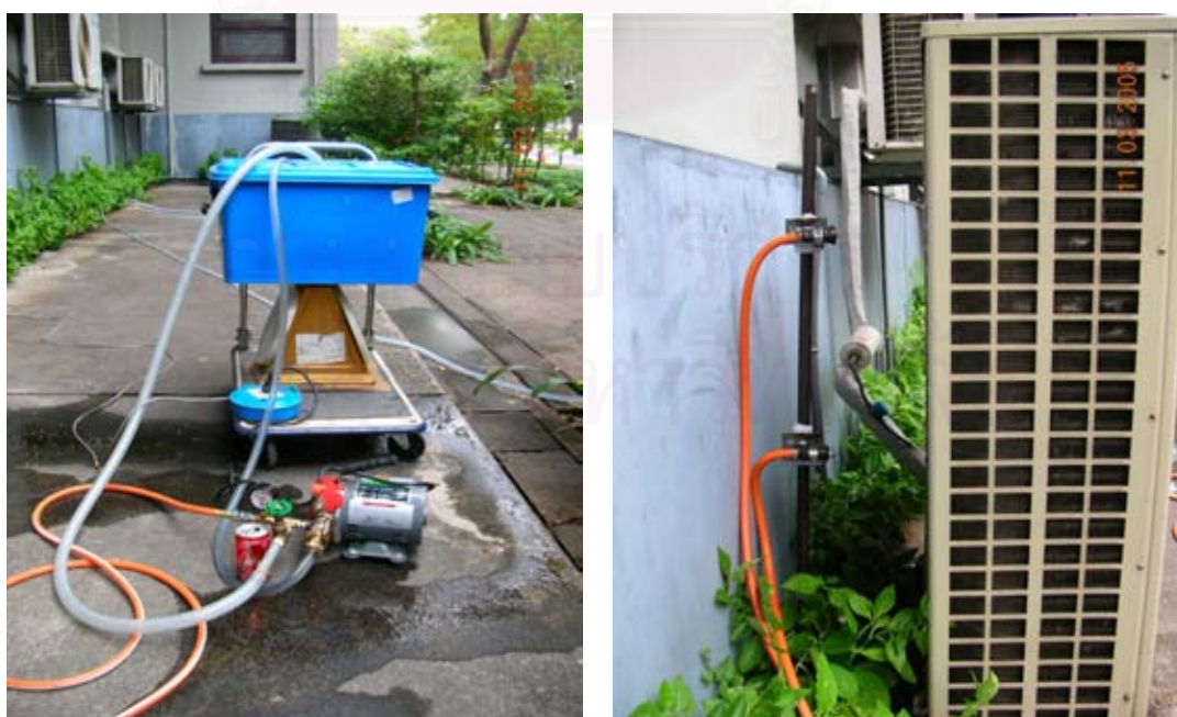
รูปที่ 4.36 แสดงเครื่องปรับอากาศแบบระบายความร้อนโดยการพ่นน้ำ
