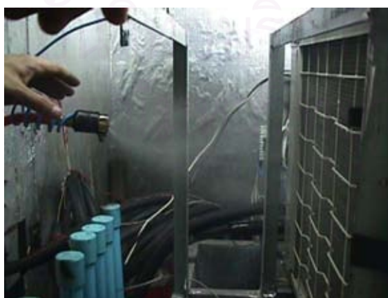
รูปที่ 4.31 แสดงการติดตั้งหัวฉีดที่ด้านหลังชุดคอนเดนเซอร์
