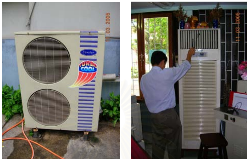
รูปที่ 4.35 แสดงเครื่องปรับอากาศแบบระบายความร้อนด้วยอากาศขนาด 48,000 Btu/hr
