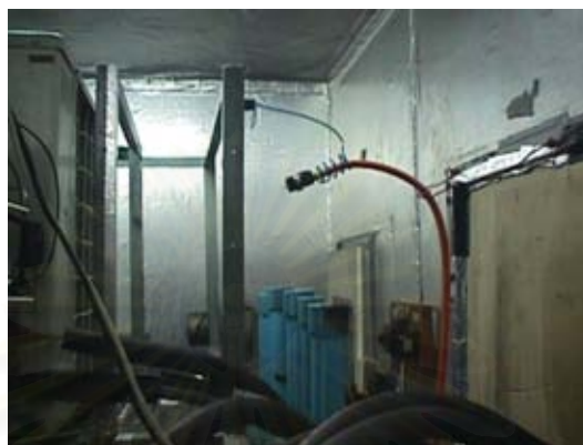
รูปที่ 4.27 การเดินท่อน้ำยาสารทำความเย็น R-22
