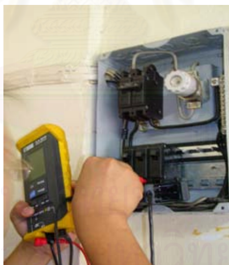
รูปที่ 4.20 แสดงการวัดค่ากระแสไฟฟ้า, แรงดัน, เพาเวอร์แฟคเตอร์ และกำลังไฟฟ้า
