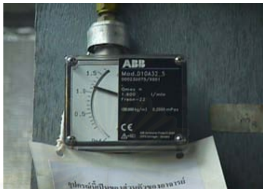
รูปที่ 4.11 อุปกรณ์วัดอัตราการไหลของสารทำความเย็น
