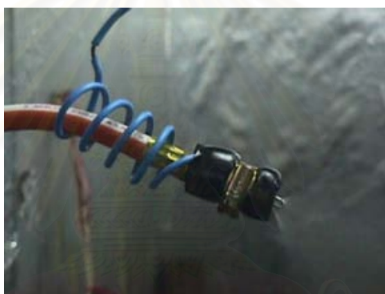
รูปที่ 4.33 หัวฉีดแบบ PJ12 สำหรับติดตั้งด้านหลังชุดคอนเดนเซอร์
