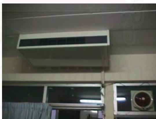
รูปที่ 4.15 แผงคอยล์เย็น (Evaporator) ที่ใช้ในการทดสอบ
