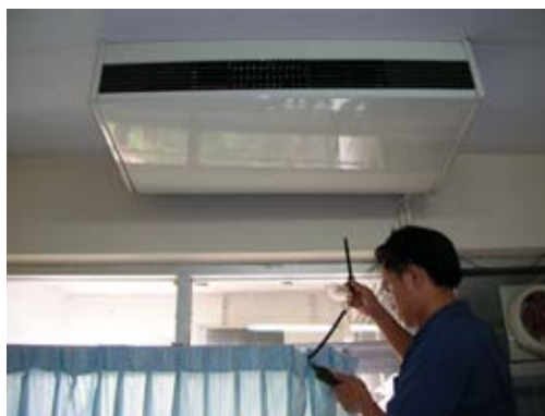
รูปที่ 4.21 แสดงการตรวจวัดและบันทึกข้อมูลที่ได้จากการทดสอบเครื่องปรับอากาศ
