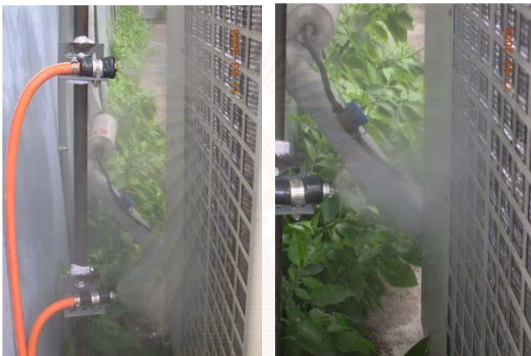
รูปที่ 4.37 แสดงการทำงานของหัวฉีดพ่นน้ำ
