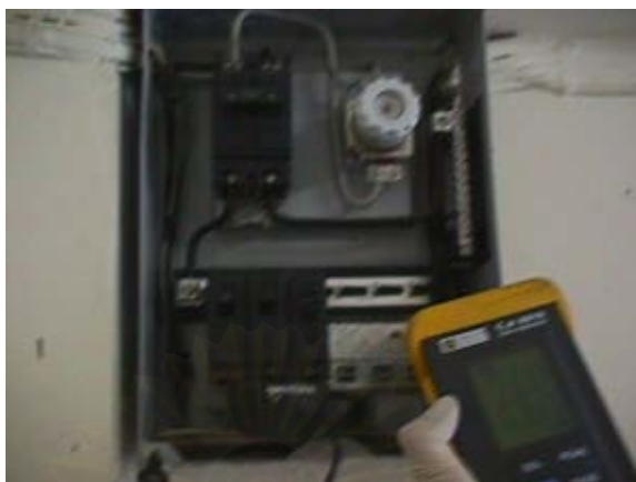
รูปที่ 4.18 การวัดกระแสและกำลังไฟฟ้าโดยรวมของเครื่องปรับอากาศที่ใช้ในการทดสอบ
