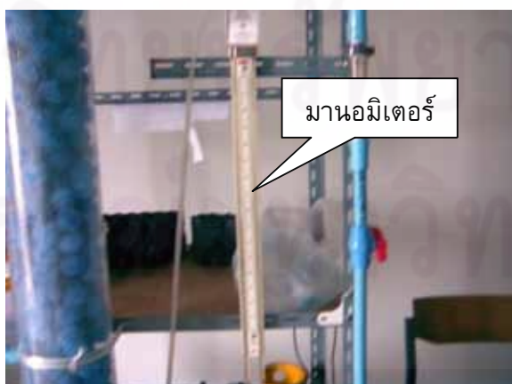
รูปที่ 3.17 การติดตั้งมานอมิเตอร์
