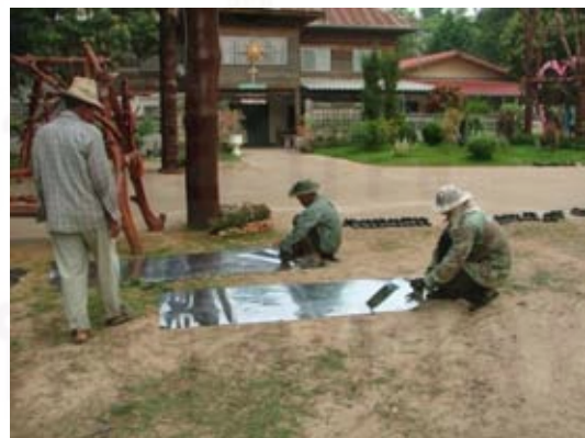
ภาพที่ 5.100 (ซ้าย) การทำสีและลงน้ำยาป้องกันเนื้อไม้สำหรับไม้แป้นซึ่งใช้มุงหลังคาโบสถ์
