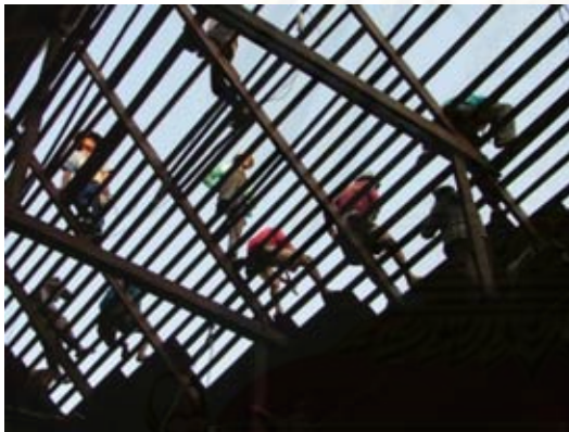
ภาพที่ 5.98-5.99 มุมมองจากในตัวโบสถ์ระหว่างการรื้อปรับปรุงโครงสร้างและมุงหลังคาใหม่
