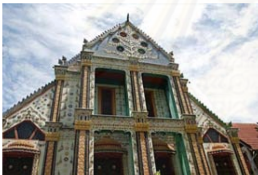
ภาพที่ 4.27 (ซ้าย) มุมมองจากทางทิศตะวันตกซึ่งเป็นทางเข้าโบสถ์ facade แบ่งความสูงเป็น 3 ระดับ โดยชั้นที่สองเป็น stained glass เพื่อนำแสงเข้ามาภายในอาคาร (ที่มาภาพ: http://www.diokorat.in.th )
