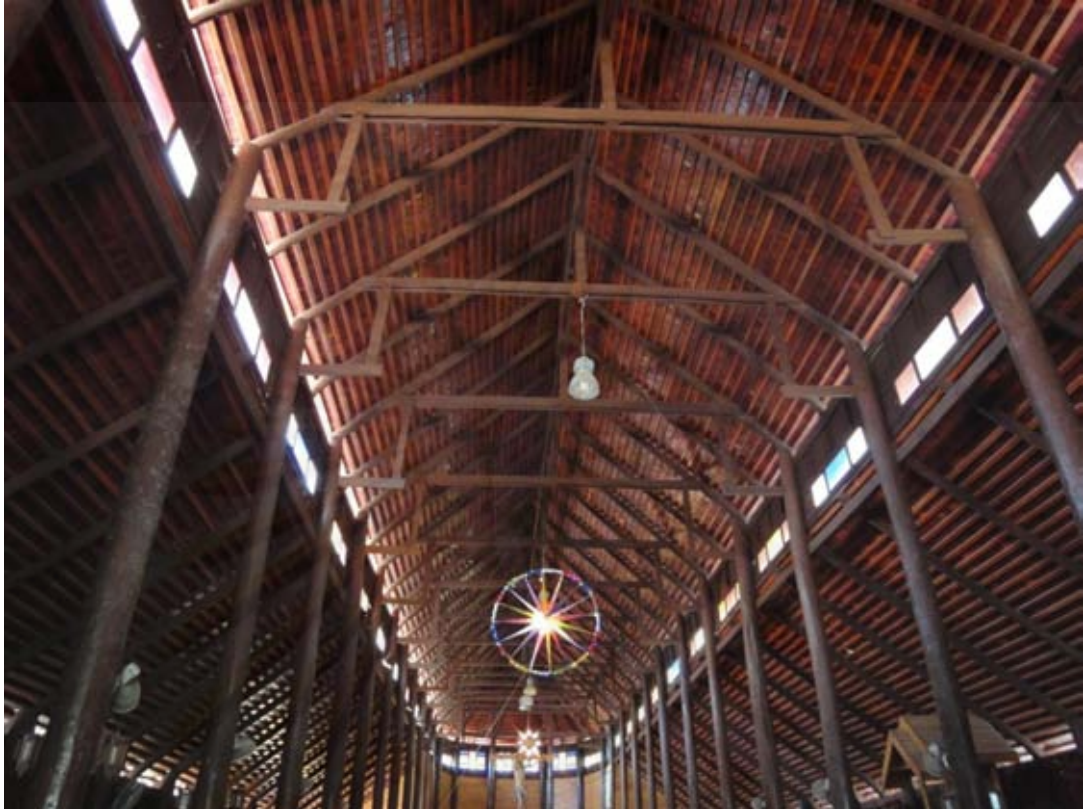
ภาพที่ 5.122 หลังคาโครงสร้างไม้จากมุมมองภายในโบสถ์วัดซ่งแย้ แสดงถึงส่วนที่เป็นเด้า ยื่นออกมารับเสาดู๊กตาซึ่งช่วยรับชื้อ ด้านบนชื้อเป็นดั่ง ตั้งขึ้นไปรับน้ำหนักอกไก่ หลังคาแบ่งเป็นสองระดับระหว่างโครงสร้างหลังคาทั้งสอง เป็นช่องคอสองนำแสงเข้ามาสู่อาคารผ่านช่องเปิดซึ่งประดับด้วยกระจกลี
