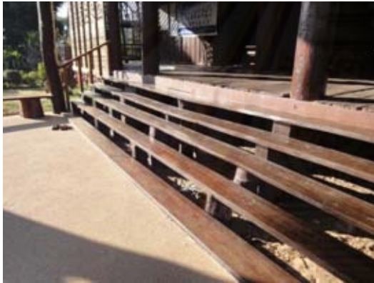
ภาพที่ 5.118 (ซ้าย) มุมมองบันไดด้านหน้าโถงทางเข้าโบสถ์ แสดงการยกยกระดับอาคารที่ความสูง 1.10 เมตรจากระดับพื้นดิน
