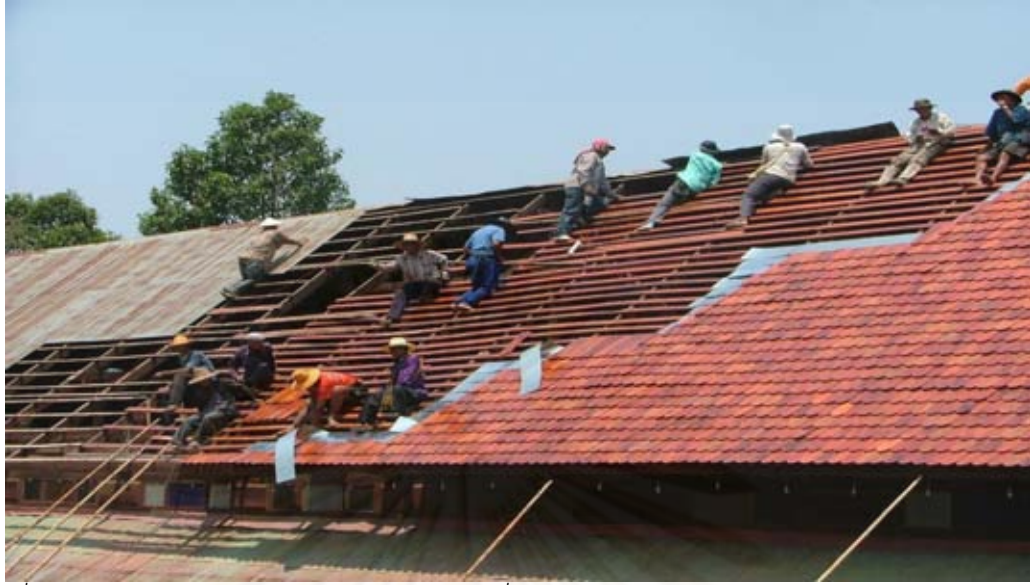
ภาพที่ 5.97 การบูรณะโครงสร้างหลังคาและการเปลี่ยนวัสดุหลังคาจากสังกะสีมาเป็นไม้แป้นตามแบบโบราณ ในระหว่างการปรับปรุงครั้งที่ 3
