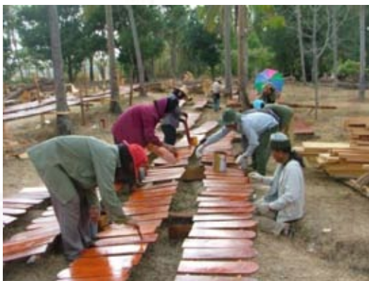
ภาพที่ 5.100 (ซ้าย) การทำสีและลงน้ำยาป้องกันเนื้อไม้สำหรับไม้แป้นซึ่งใช้มุงหลังคาโบสถ์
