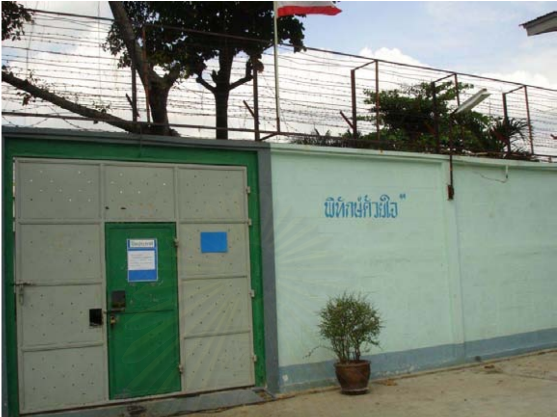
ภาพที่ 18 รั้วและประตูกันระหว่างบริเวณอาคารบริหารและบริเวณที่อยู่ของเด็กและเยาวชน
