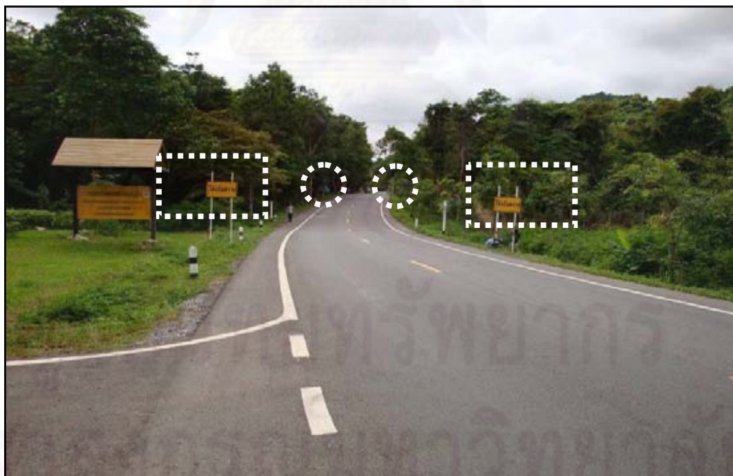
ภาพที่ ก.24 การติดตั้งป้ายรูปแบบ D บนทางโค้งดิ่งขึ้นเนิน สายทาง ชบ.1003
