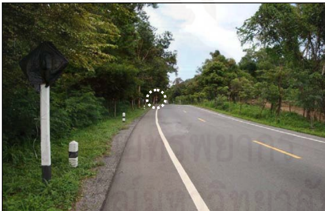
ภาพที่ ก.22 การติดตั้งป้ายรูปแบบ B บนทางโค้งดิ่งขึ้นเนิน สายทาง ชบ.1008
