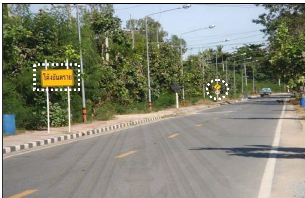
ภาพที่ ก.3 การติดตั้งป้ายรูปแบบ C บนทางโค้งราบรัศมีกว้าง สายทาง ชบ.1008
