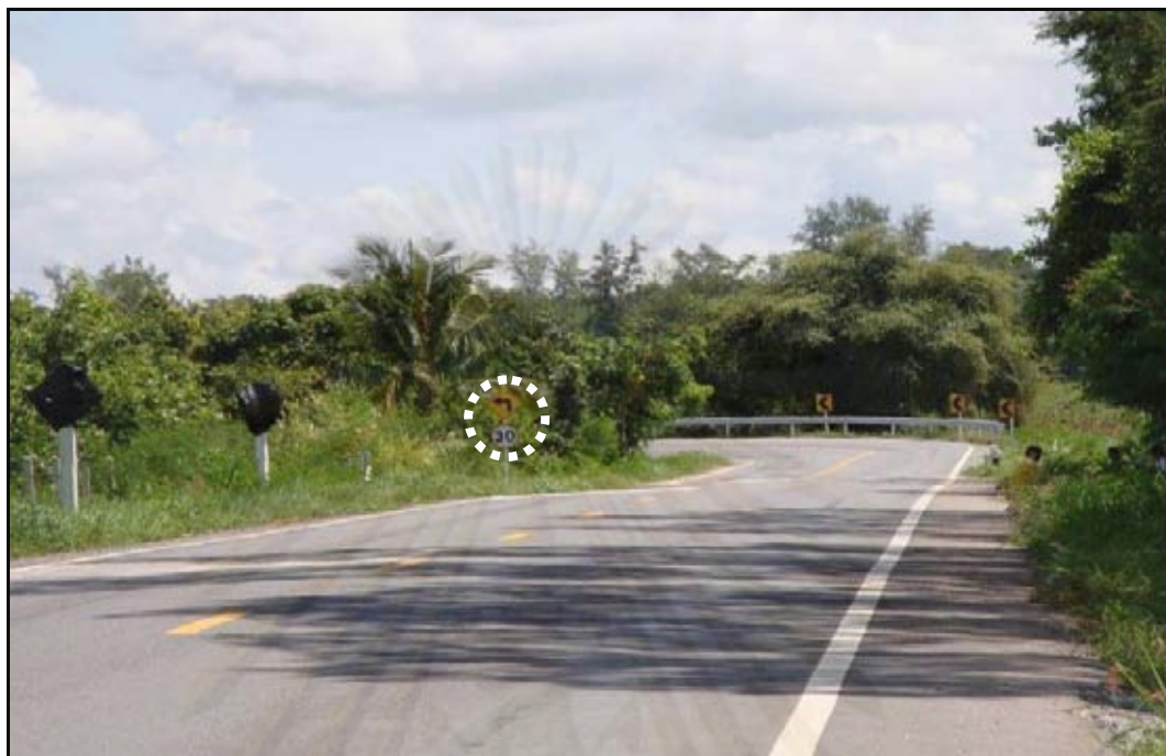
ภาพที่ ก.7 การติดตั้งป้ายรูปแบบ B บนทางโค้งราบริศมีแคบ สายทาง ชบ.5010
