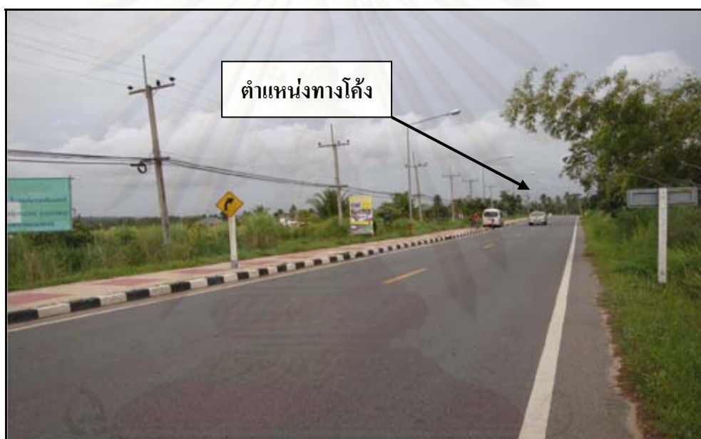
ภาพที่ 4.4 ทางโค้งรัศมีกว้าง สายทาง ชบ.1008
