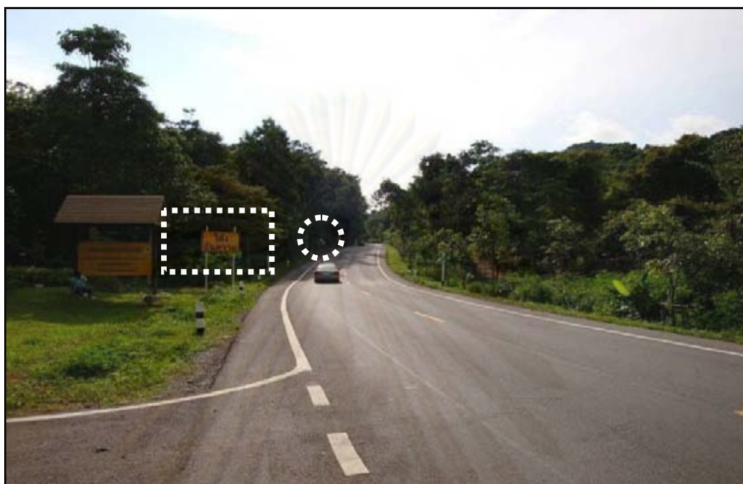
ภาพที่ ก.25 การติดตั้งป้ายรูปแบบ E บนทางโค้งดิ่งขึ้นเนิน สายทาง ชบ.1003
