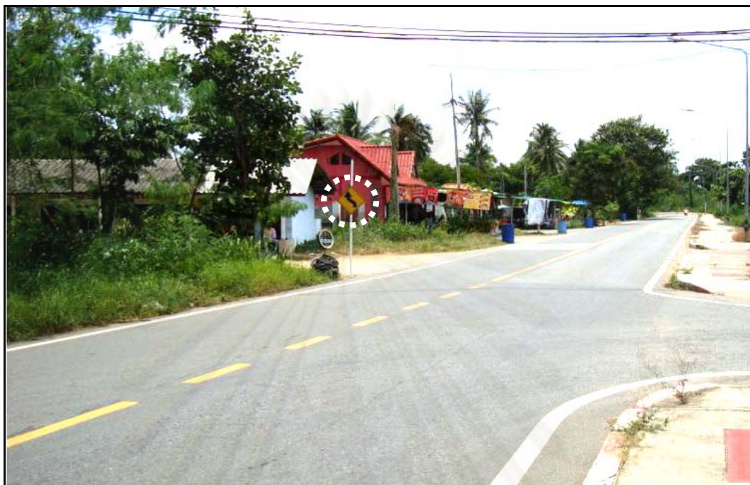
ภาพที่ ก.11 การติดตั้งป้ายรูปแบบ A บนทางโค้งราบกลับทิศรัศมีกว้าง สายทาง ชบ.1008
