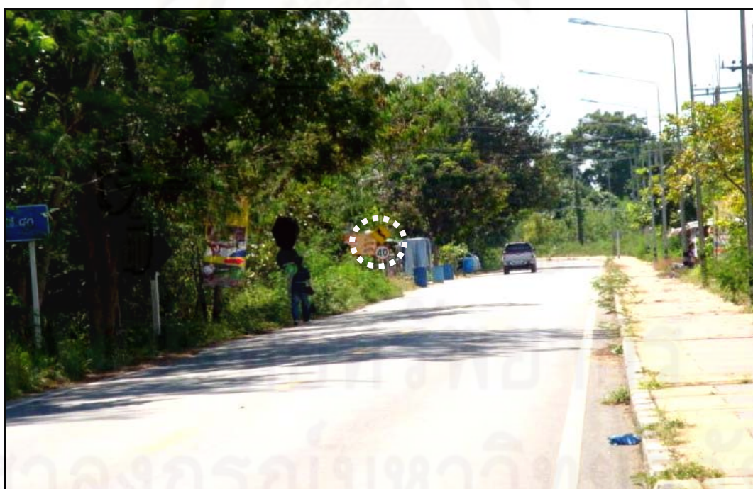
ภาพที่ ก.12 การติดตั้งป้ายรูปแบบ B บนทางโค้งราบกลับทิศรัศมีกว้าง สายทาง ชบ.1008
