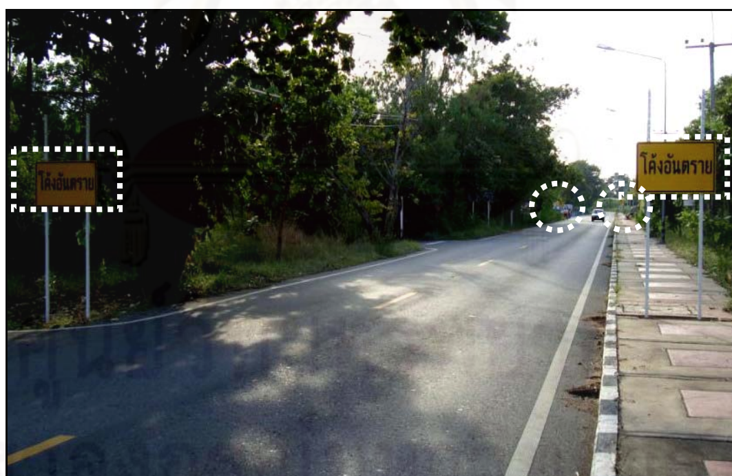
ภาพที่ ก.14 การติดตั้งป้ายรูปแบบ D บนทางโค้งกลับทิศรัศมีกว้าง สายทาง ชบ.1008
