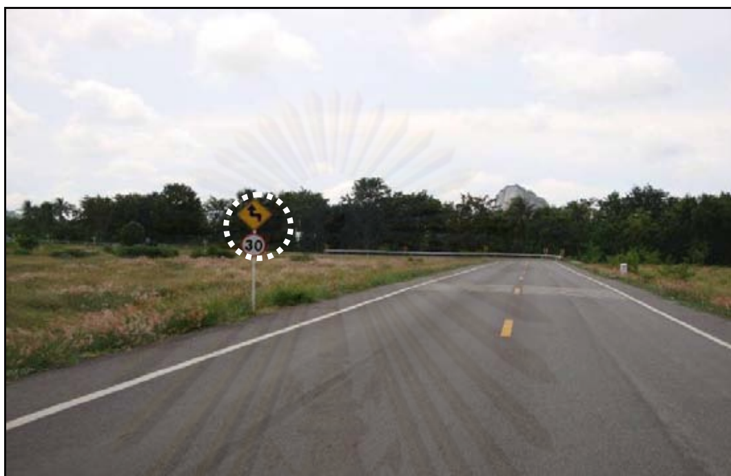
ภาพที่ ก.17 การติดตั้งป้ายรูปแบบ B บนทางโค้งราบกลับทิศรัศมีแคบ สายทาง ชบ.5010
