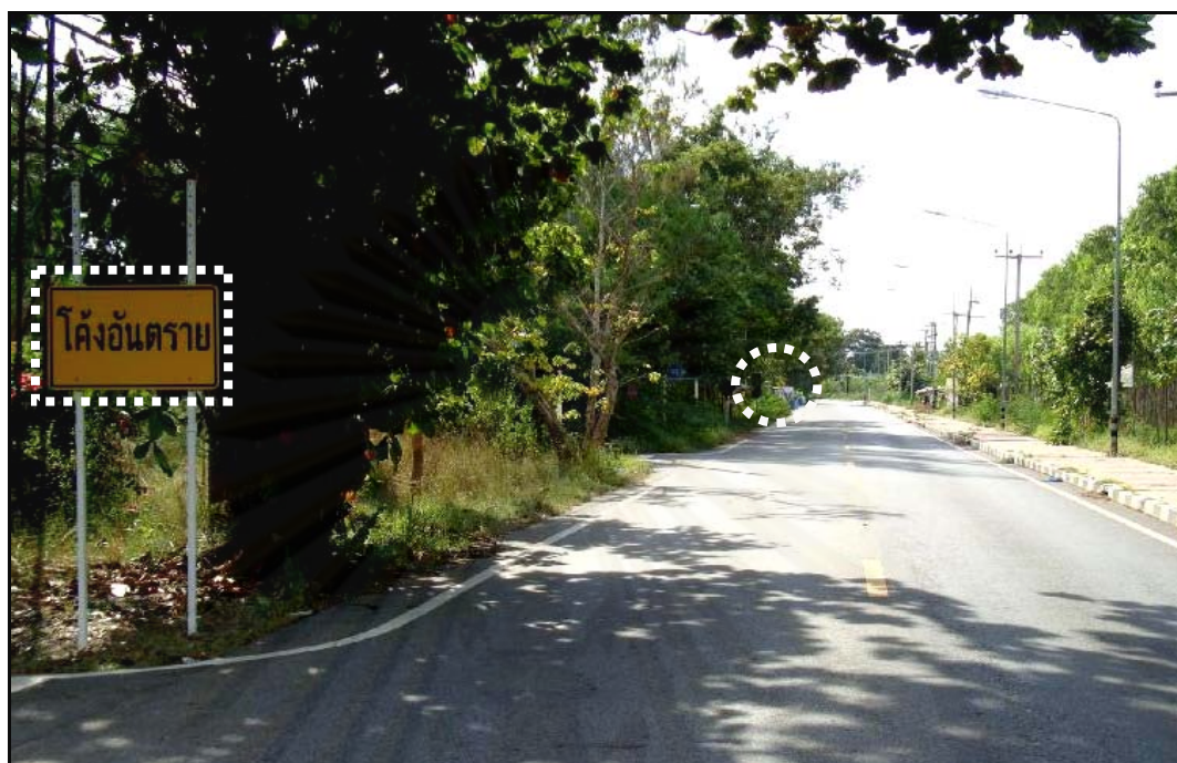
ภาพที่ ก.13 การติดตั้งป้ายรูปแบบ C บนทางโค้งราบกลับทิศรัศมีกว้าง สายทาง ชบ.1008
