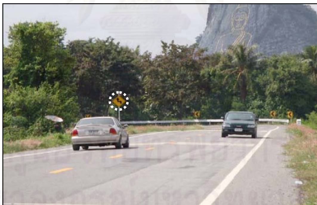
ภาพที่ ก.16 การติดตั้งป้ายรูปแบบ A บนทางโค้งราบกลับทิศรัศมีแคบ สายทาง ชบ.5010
