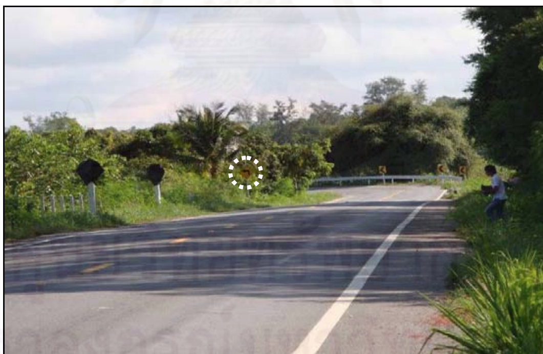
ภาพที่ ก.6 การติดตั้งป้ายรูปแบบ A บนทางโค้งราษฎร์มีแคบ สายทาง ชบ.5010
