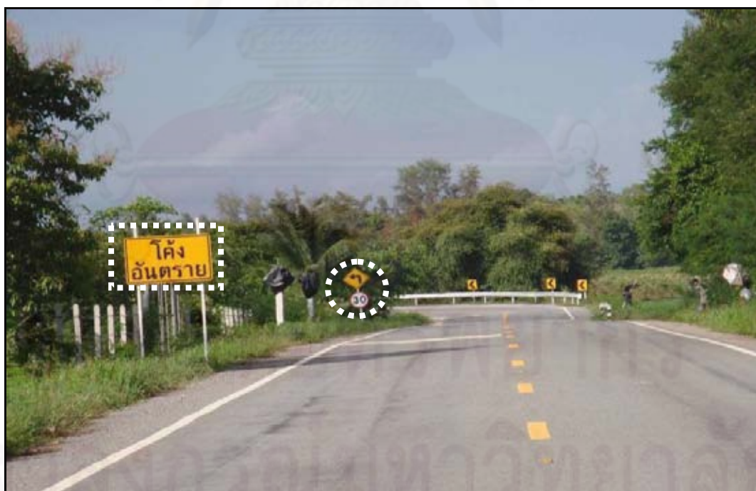
ภาพที่ ก.10 การติดตั้งป้ายรูปแบบ E บนทางโค้งราบรัศมีแคบ สายทาง ชบ.5010
