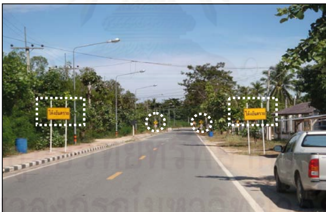
ภาพที่ ก.4 การติดตั้งป้ายรูปแบบ D บนทางโค้งราบรัศมีกว้าง สายทาง ชบ.1008
