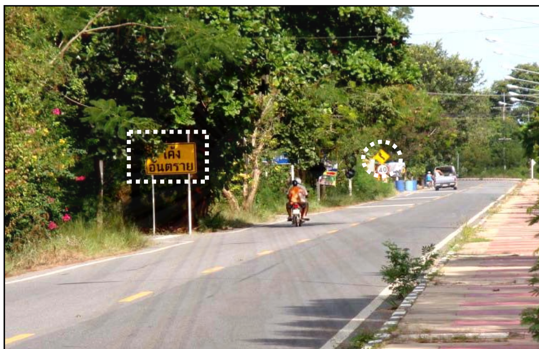
ภาพที่ ก.15 การติดตั้งป้ายรูปแบบ E บนทางโค้งราบกลับทิศรัศมีกว้าง สายทาง ชบ.1008
