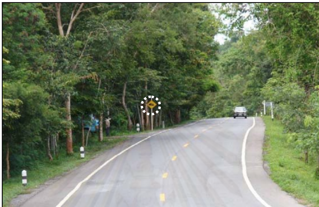
ภาพที่ ก.21 การติดตั้งป้ายรูปแบบ A บนทางโค้งดิ่งขึ้นเนิน สายทาง ชบ.1003
