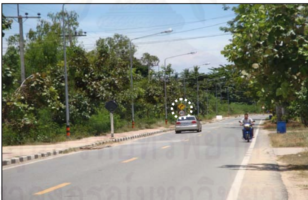
ภาพที่ ก.2 การติดตั้งป้ายรูปแบบ B บนทางโค้งราบรัศมีกว้าง สายทาง ชบ.1008
