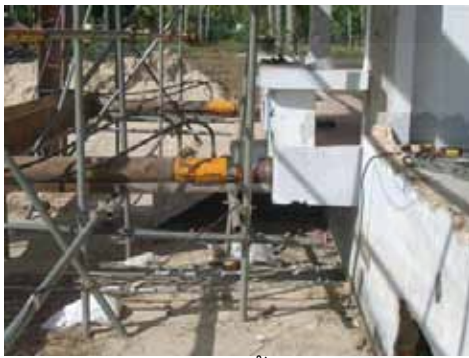
(ก) การติดตั้งแจ๊คไฮดรอลิก
