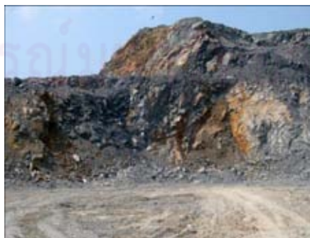
รูปที่ 4.9 ผนังบ่อเหมืองที่มีโอกาสเกิดการพังทลายรูปปลี้ม
