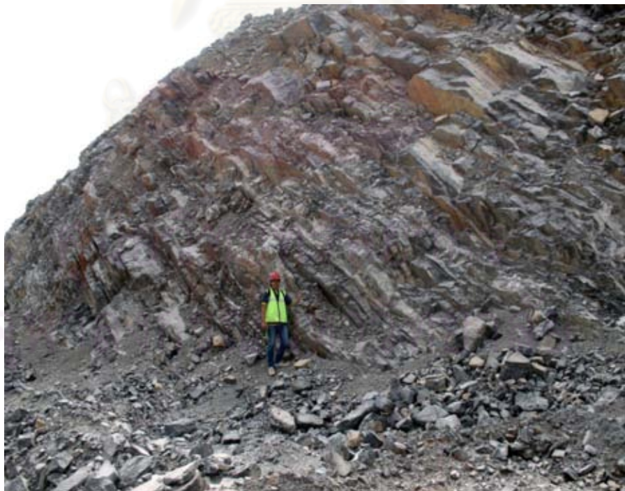
รูปที่ 4.12 ผนังบ่อเหมืองที่มีโอกาสเกิดการพังทลายแบบคะมา
