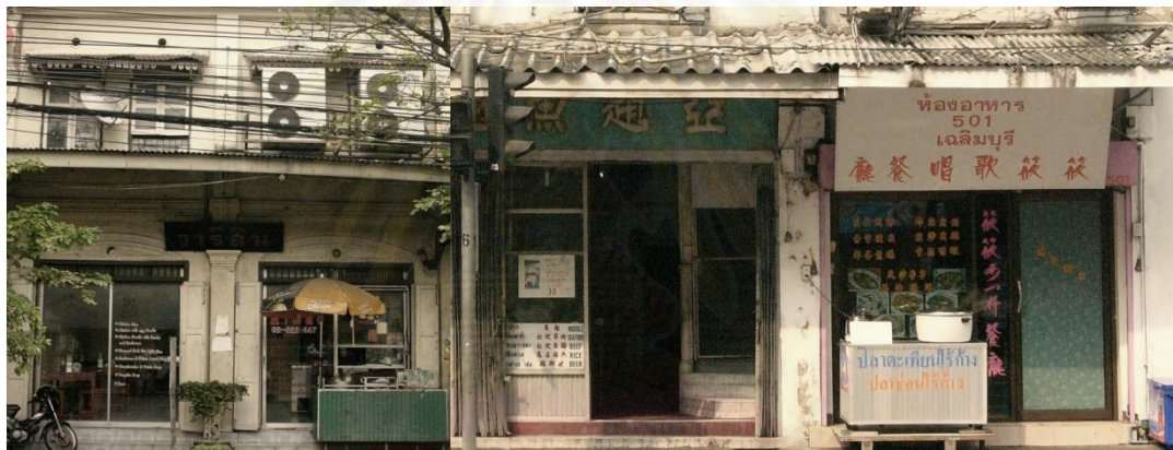
ภาพที่ 4.2 แสดงการเปลี่ยนแปลงบานเพ็ยมเดิมเป็นกระจกอลูมิเนียม
