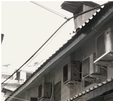
ภาพที่ 4.7 แสดงการเพิ่มช่องระบายอากาศหลังคาเพิงแขนงสังกะสี
