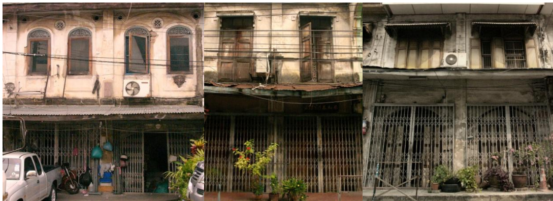
ภาพที่ 4.1 แสดงการเพิ่มประตูเหล็กยึดบนบานเพ็ยมเดิมของตึกแถว
