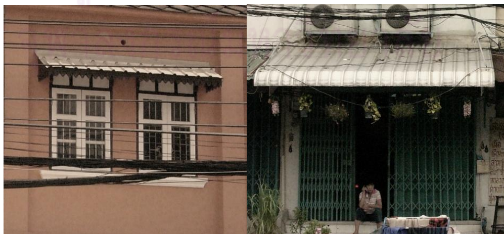
ภาพที่ 4.6 แสดงการเพิ่มกันสาดเมทัลชีทบนตึกแถว
