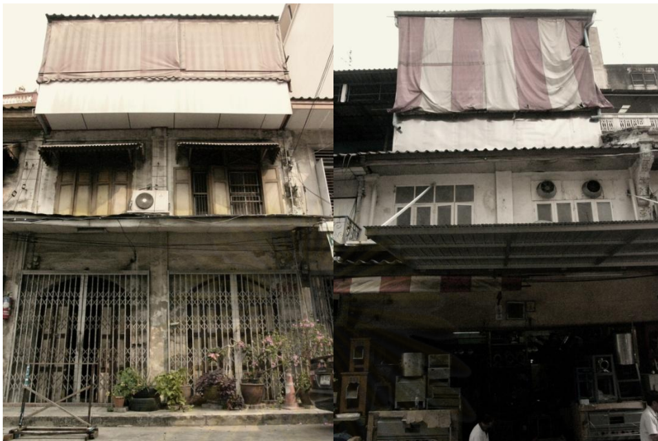
ภาพที่ 4.12 แสดงการเปลี่ยนแปลงรูปทรงโดยการต่อเติม ชั้น 3 ทั้งชั้น ต่อเติมโดยอาศัยโครงสร้าง อาคารตึกแถวเดิมเริ่มจากส่วนหน้าตลอดแนวอาคาร ทั้งอาคาร
