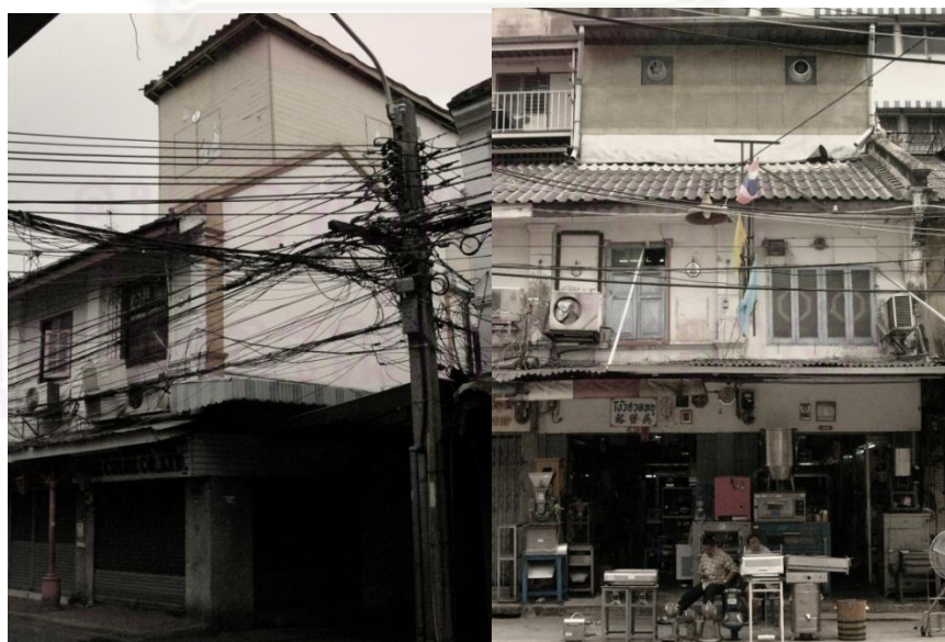
ภาพที่ 4.11 แสดงการเปลี่ยนแปลงรูปทรงโดยต่อเติมชั้น 3 จากหลังสันหลังคาจั่วตลอดความยาวอาคารของอาคารตึกแถวถนนวานิช 1 และ บริเวณเวียงนครเขษม
