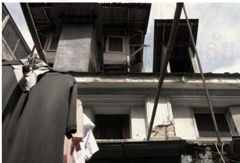
ภาพที่ 4.9 แสดงการเพิ่มช่องติดตั้งรอกส่งของบนหลังคาตึกแถว
