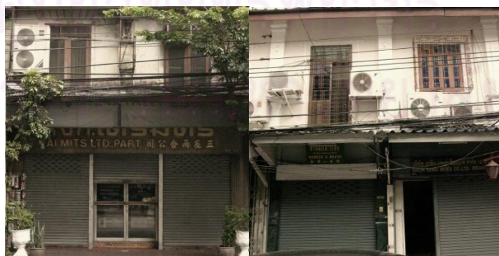
ภาพที่ 4.3 แสดงการเพิ่มประตูเหล็กม้วนบนตึกแถว
