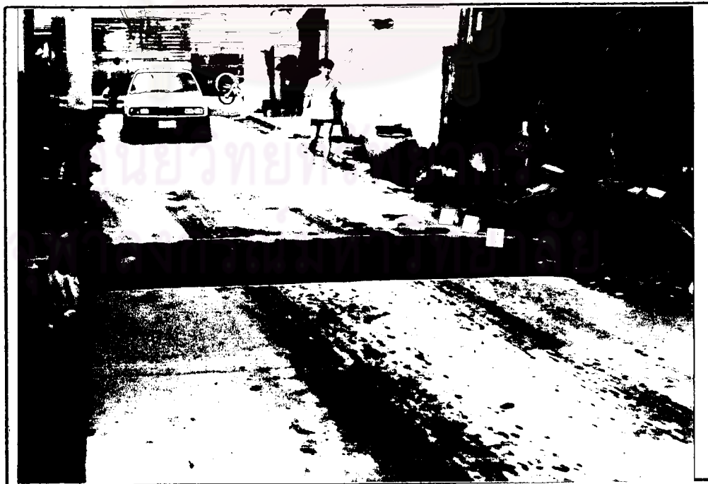
รูปที่ 6.12 ความแตกต่างของผิวทางทดลองกรวดดินเผาและหินปูนภายหลังจากน้ำลงแล้วประมาณ 10 ชม.
