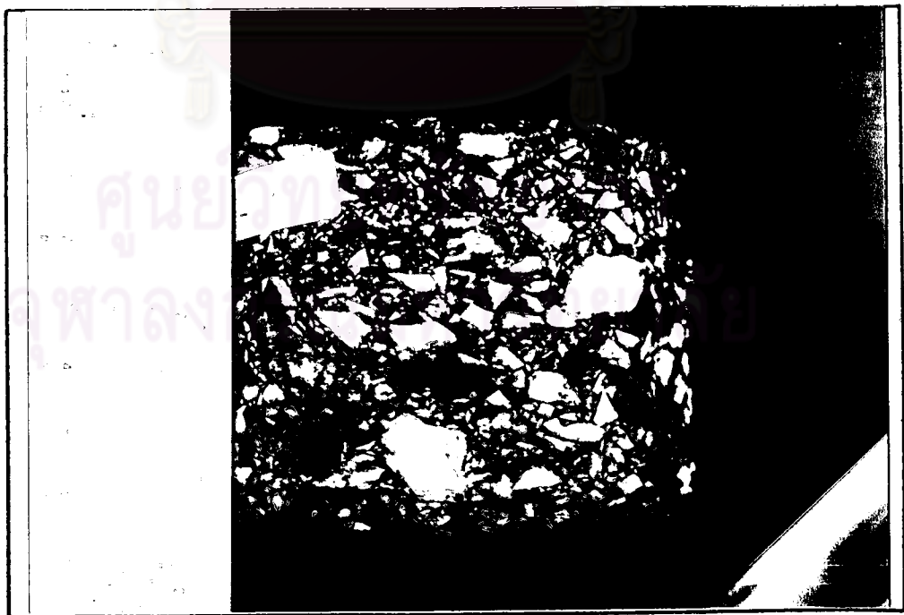
รูปที่ 6.14 (ข) ก้อนตัวอย่างแอสฟัลต์ติกคอนกรีตหินปูนที่เจาะขึ้นมาจากผิวทดลอง แปลง (ข) ภายหลังจากก่อสร้าง 113 วัน (L 22 )
