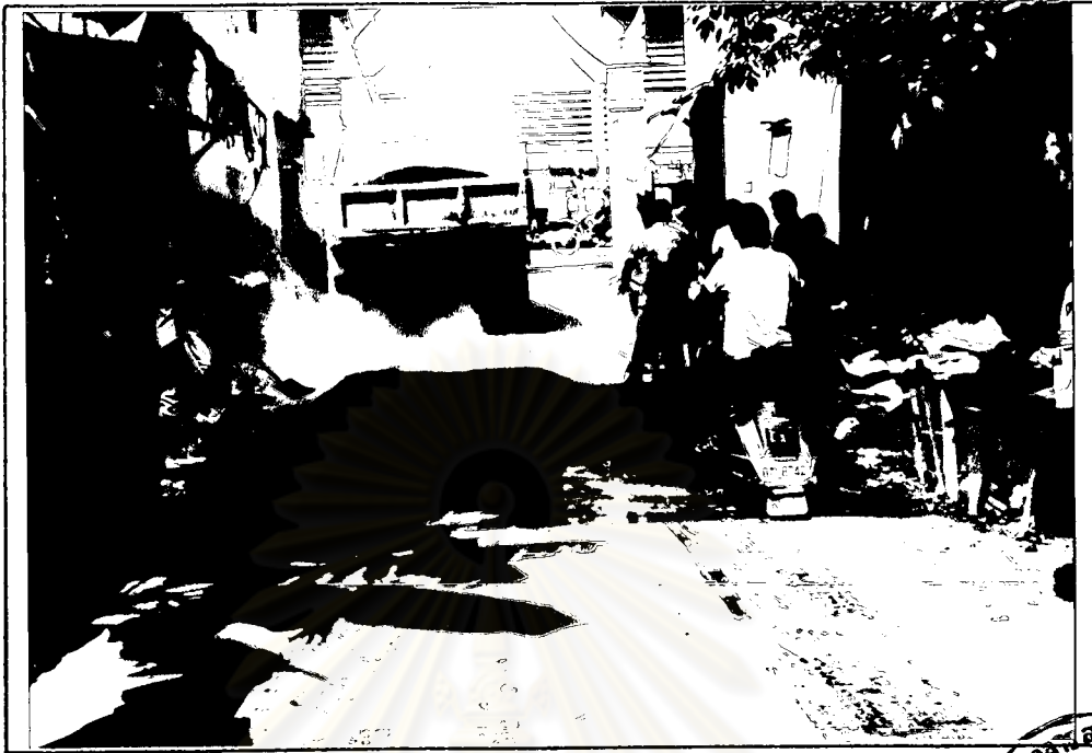
รูปที่ 6.7 (ก) แอสฟัลต์ติกคอนกรีตใหม่ถูกเทลงบนล้งนผิวทาง
