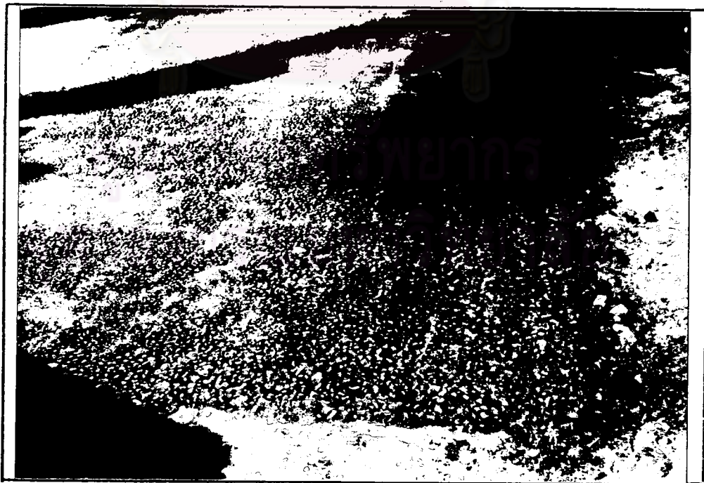
รูปที่ 6.8 (ข) ลักษณะผิวทางแอสฟัลต์ติกกวาดดินเผาหลังจากบดอัดแล้ว
