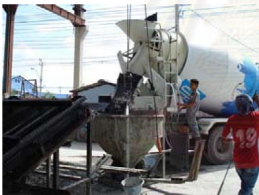
ภาพที่ 5.57 แสดงการ Load คอนกรีตผสมเสร็จใส่ Bucket
