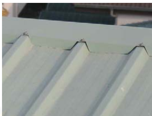
ภาพที่ 5.188 แสดงการติดตั้งแผ่นเหล็กที่ดลอน
