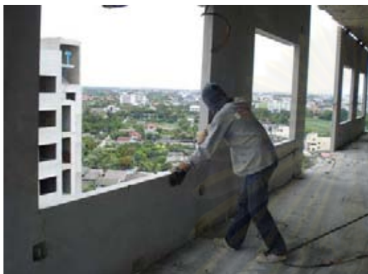
ภาพที่ 5.203 แสดงการปรับแต่งตำแหน่ง ผนัง ค.ส.ล. สำเร็จรูป
