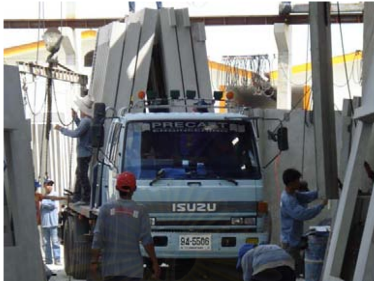
ภาพที่ 5.47 แสดงการขนส่งชิ้นส่วนสำเร็จรูป
