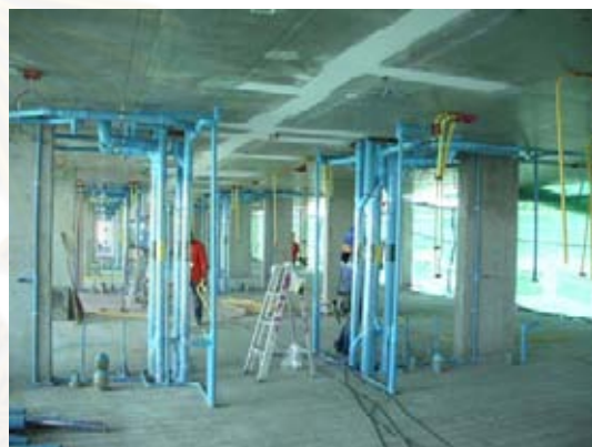
ภาพที่ 5.242 แสดงการติดตั้งเสาเอ็นสำเร็จรูป ภาพที่ 5.243 แสดงการเดินงานระบบภายในอาคาร
