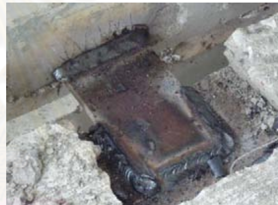
ภาพที่ 5.210 แสดง Plate ที่เชื่อมติดเรียบร้อย
