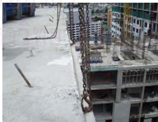
ภาพที่ 5.202 แสดงตาขอรอกที่ติดกับโซ่ไปคล้องไว้กับหัวหิ้วด้านบน
