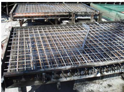
ภาพที่ 5.17 การเตรียมงานหล่อพื้นสำเร็จรูป
