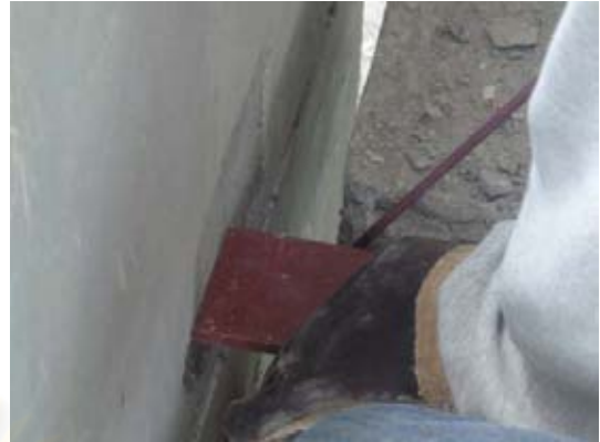
ภาพที่ 5.208 แสดงการนำPlateขนาด 75 X 125 X 9 มม.มาเชื่อมติดกันตามแนวนอน
