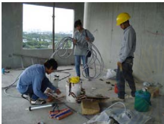
ภาพที่ 5.219 แสดงทีมงานอุด Sealant
