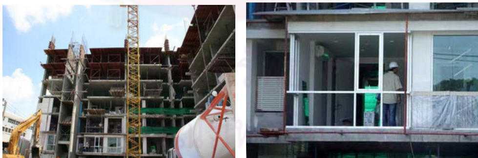
ภาพที่ 3.5 แสดงการก่อสร้างโครงการ 5
