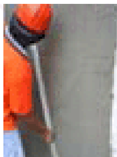
ภาพที่ 5.139 แสดงการฉาบปูน และ ลงฟองน้ำ
