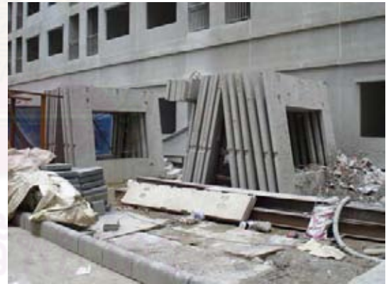
ภาพที่ 5.191 แสดงการกองผนัง ค.ส.ล. สำเร็จรูปข้างอาคาร
