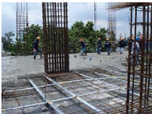
ภาพที่ 5.170 แสดงการเทคอนกรีต
