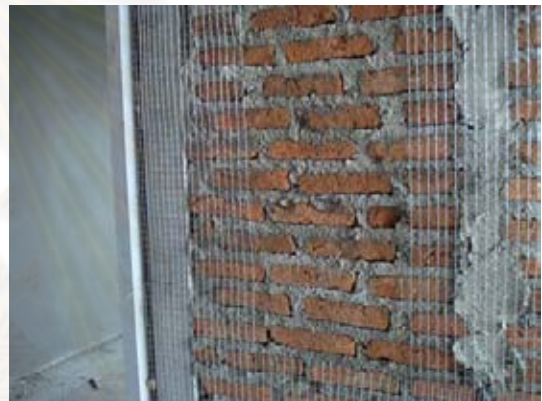
ภาพที่ 5.239 แสดงการติดตาข่ายกรองไก่
