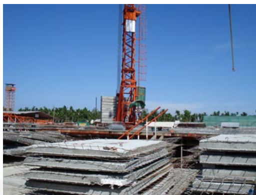
ภาพที่ 5.3 พื้นชนิด Precast Slab
