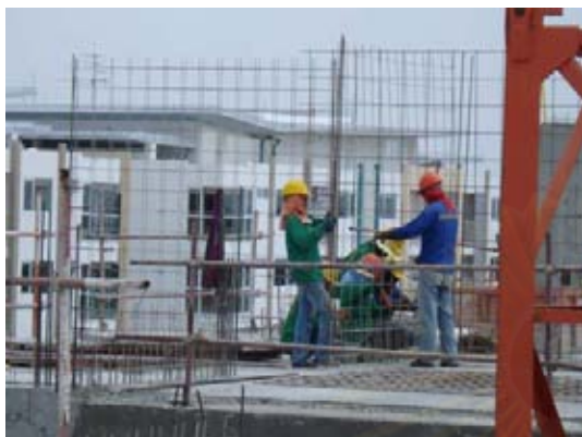
ภาพที่ 5.112 แสดงการติดตั้งตะแกรงเหล็ก
