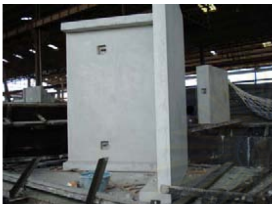
ภาพที่ 5.71 แสดงชิ้นส่วนสำเร็จรูปแผ่นฉาก
