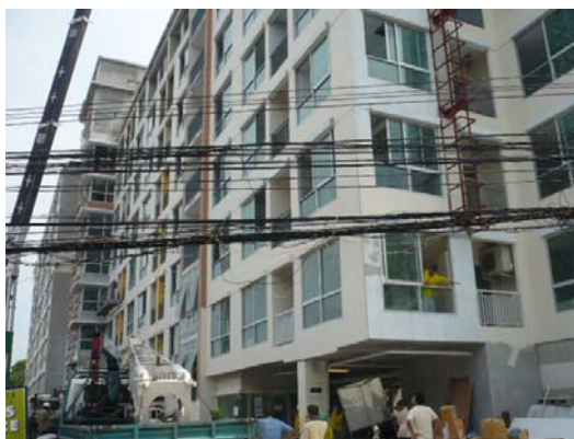
ภาพที่ 3.4 แสดงการก่อสร้างโครงการ 4
