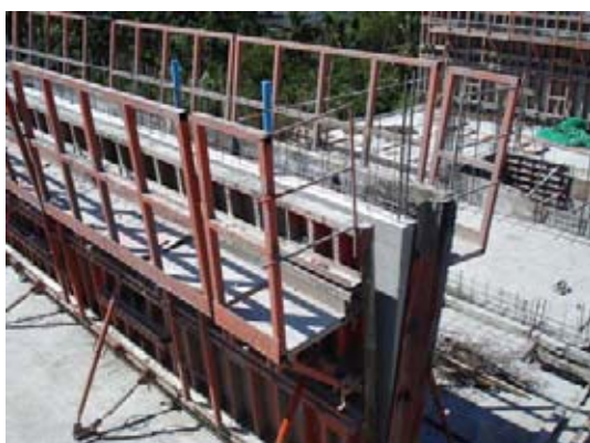
ภาพที่ 5.119 แสดงการเปิดแบบเหล็ก
