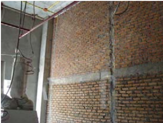
ภาพที่ 5.238 แสดงคานเอ็นคอนกรีต ค.ส.ส.
