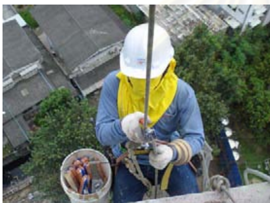
ภาพที่ 5.225 ช่างโรยตัวพร้อมอุปกรณ์ในการอุดร่อง
