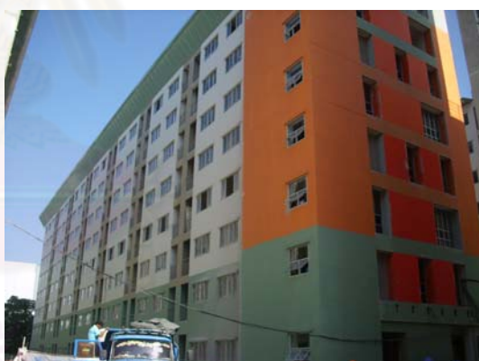
ภาพที่ 5.253 แสดงงานสีภายนอกอาคาร
