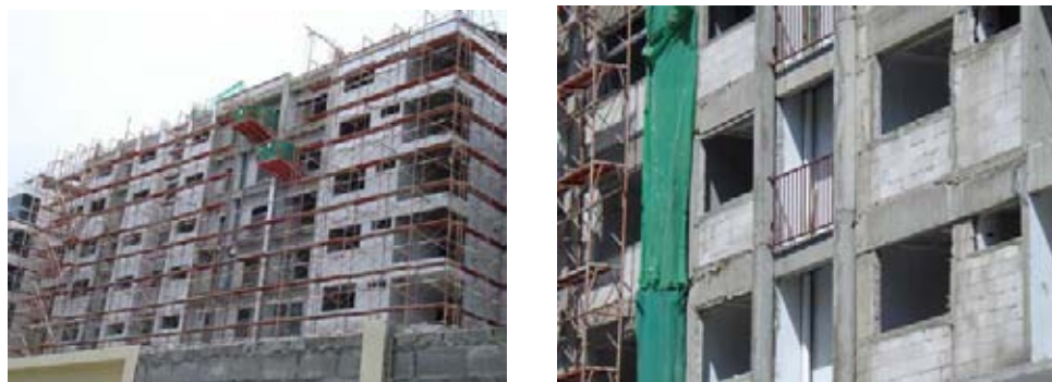
ภาพที่ 3.1 แสดงการก่อสร้างโครงการ 1
