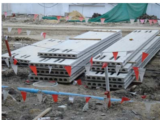
ภาพที่ 5.2 พื้นชนิด Hollow Core Floor
