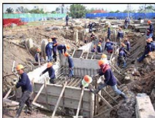
ภาพที่ 5.152 แสดงการลงเหล็กเสริม
