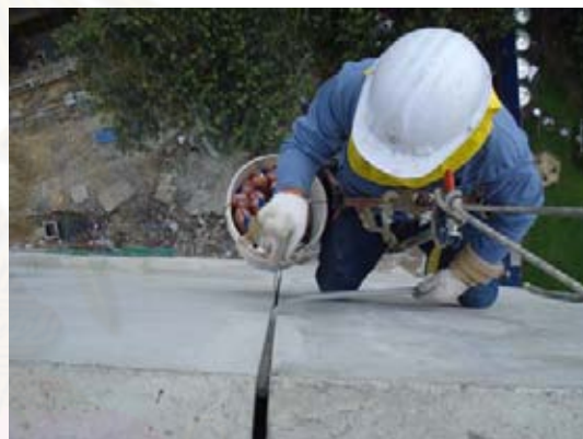
ภาพที่ 5.226 แสดงการใส่ Backing Rod
