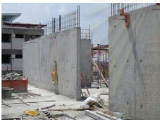
ภาพที่ 5.120 แสดงผนังรับน้ำหนัก หนา 15 ซม.
