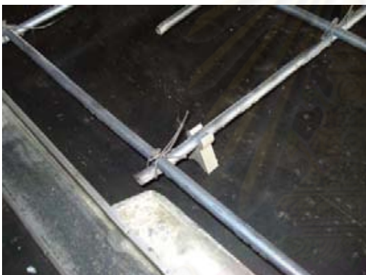
ภาพที่ 5.54 ขา PVC จัดระยะห่างจากตัวแบบหล่อ
