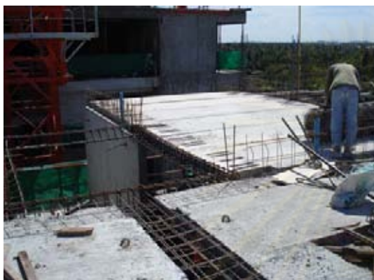
ภาพที่ 5.126 แสดงการติดตั้งพื้น ค.ส.ล.สำเร็จรูป ภาพที่ 5.127 แสดงตะแกรงกันวัสดุและคน Precast Slab
