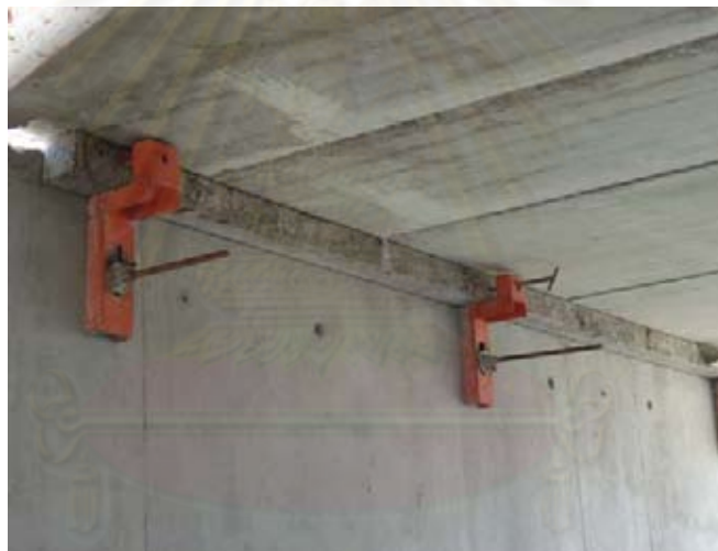
ภาพที่ 5.132 การเข้าแบบใต้ท้องพื้นและเป็นค้ำยันแผ่นในตัวก่อนเทคอนกรีต
