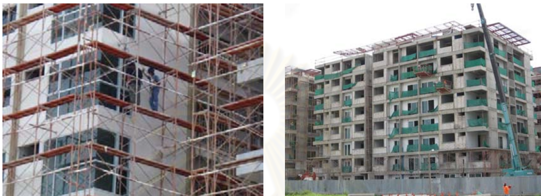
ภาพที่ 5.143 แสดงงานติดตั้งประตู-หน้าต่างอลูมิเนียม
