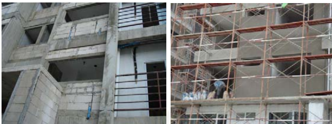
ภาพที่ 5.87 ผนังก่ออิฐเป็นผนังภายนอก ภาพที่ 5.88 งานฉาบผนังภายนอกโครงการ 1
