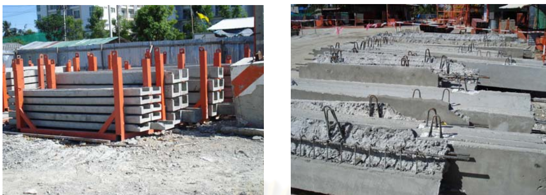
ภาพที่ 5.13 แสดงส่วนสต็อกชิ้นส่วนสำเร็จรูป
