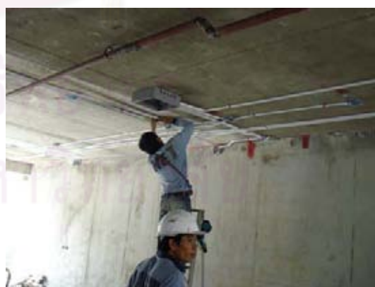
ภาพที่ 5.142 แสดงการติดตั้งงาน ระบบภายในอาคาร
