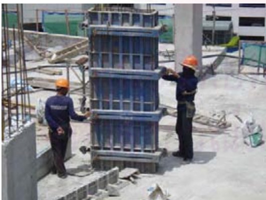
ภาพที่ 5.186 แสดงการถอดแบบเสาโดยคลายน๊อตยึด และ ใช้ทาวเวอร์เครนยกขึ้น
