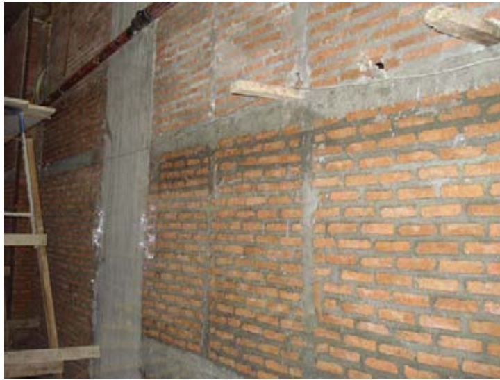
ภาพที่ 5.90 ผนังก่ออิฐเป็นผนังภายในของโครงการ 2
