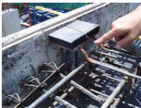
ภาพที่ 5.159 แสดงฟองน้ำแข็งที่ใช้ติด Insert Plate
