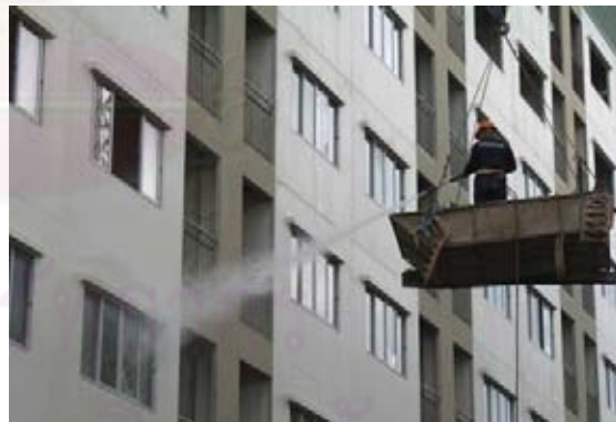
ภาพที่ 5.249 แสดงการทดสอบการรั่วซึม
