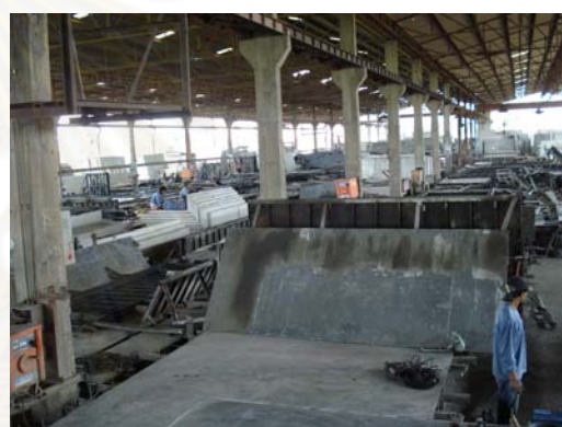
ภาพที่ 5.38 ลานหล่อชิ้นส่วนสำเร็จรูป Line 2
