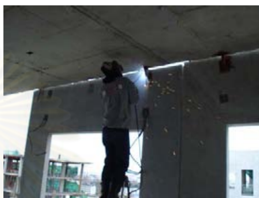
ภาพที่ 5.213 แสดงการเชื่อม Plateด้านบน
