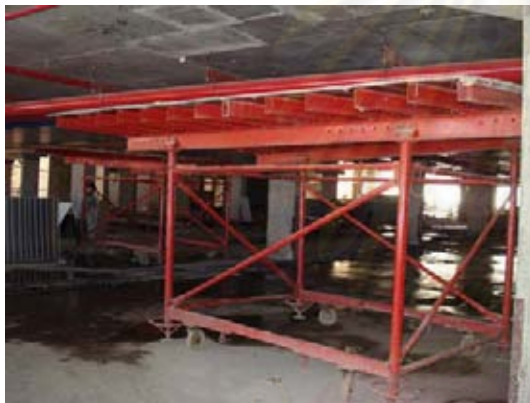
ภาพที่ 5.154 แสดงแบบหล่อระบบ Table Form
