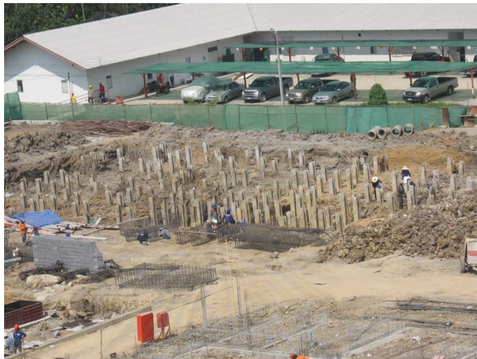
ภาพที่ 5.107 แสดงการตอกเสาเข็มคอนกรีตอัดแรง รูปตัวไอ ขนาด 0.30 X 0.30 X 28.50 เมตร
