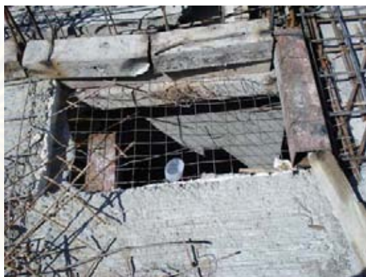
ภาพที่ 5.126 แสดงการติดตั้งพื้น ค.ส.ล.สำเร็จรูป ภาพที่ 5.127 แสดงตะแกรงกันวัสดุและคน Precast Slab
