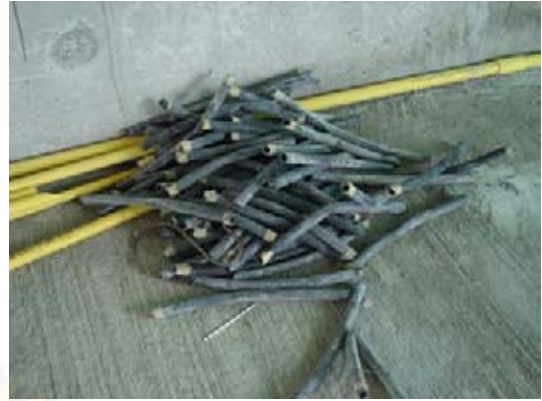
ภาพที่ 5.180 แสดงท่อรับน้ำปูนตัดทิ้งเมื่อน้ำปูนแข็งตัว
