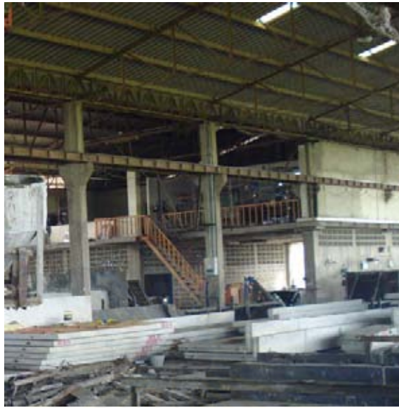
ภาพที่ 5.32 ส่วนห้องเก็บอุปกรณ์บริเวณที่ 1
