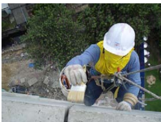
ภาพที่ 5.227 แสดงการปัดทำความสะอาด ข้างร่องทั้งสองข้าง
