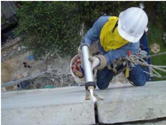
ภาพที่ 5.231 แสดงยิง Sealant ลงให้เต็มร่อง
