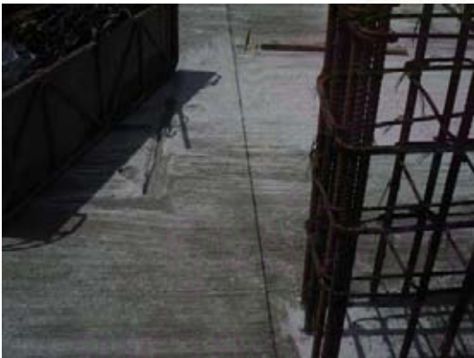
ภาพที่ 5.181 แสดง Line เสาที่ฝ่ายเซอร์เวย์วาง
