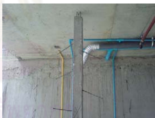
ภาพที่ 5.235 แสดงการตั้งเสาเอ็นสำเร็จรูป
