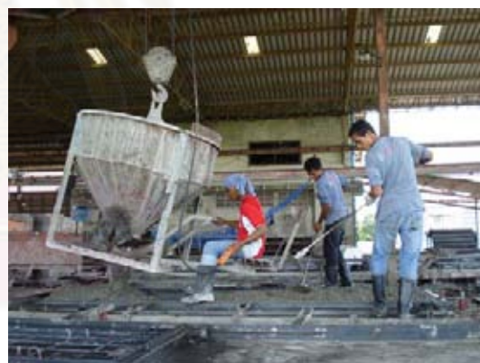
ภาพที่ 5.58 แสดงการเทคอนกรีตโดยผู้บังคับเครนวาง
