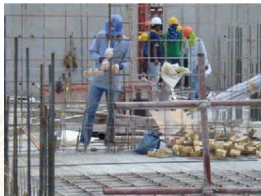
ภาพที่ 5.113 แสดงการติดตั้งวัสดุในผนังรับน้ำหนักชนิดหล่อในที่
