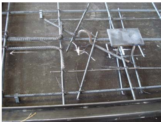
ภาพที่ 5.53 แสดงการลงตะแกรงเหล็กของแบบได้
