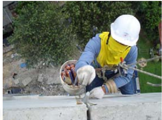
ภาพที่ 5.230 แสดงการใส่ Backing Rod ชีคคั้ง
