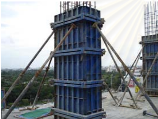
ภาพที่ 5.185 แสดงการประกอบแบบเสา
