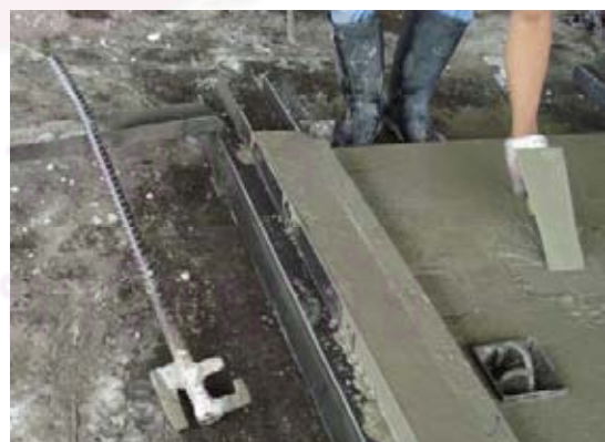
ภาพที่ 5.64 แสดงเครื่องมือปรับแต่งPlate เหล็ก
