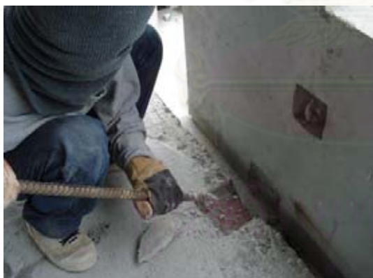
ภาพที่ 5.205 แสดงการจัดฟองน้ำแข็งที่ติดไว้ บน Insert Plate ออก
