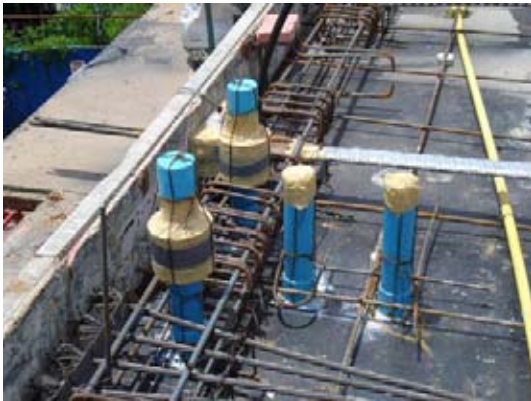
ภาพที่ 5.165 แสดงการติดตั้งระบบประปาขึ้น
