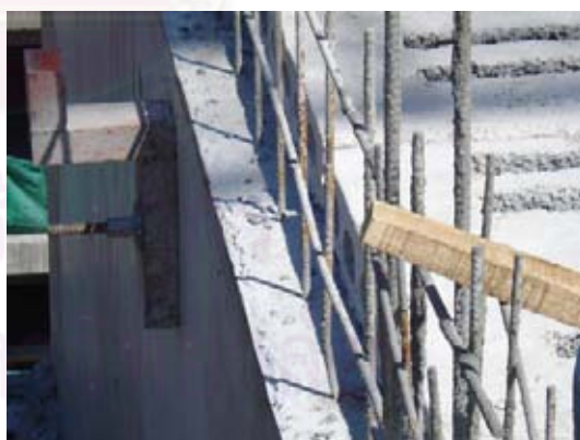
ภาพที่ 5.129 แสดงการวางพื้นบนผนังรับน้ำหนักชนิดหล่อในที่
