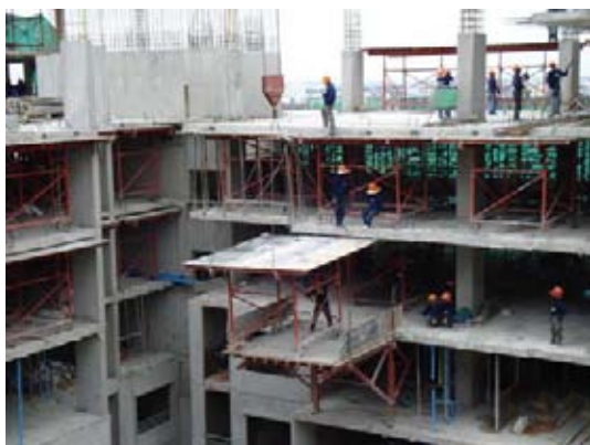
ภาพที่ 5.176 แสดงการถอดแบบหล่อ
