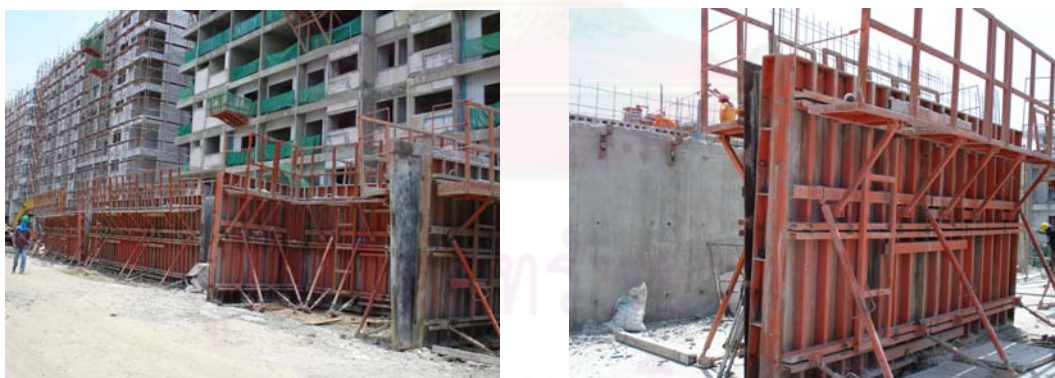
ภาพที่ 5.7 แสดงแบบหล่อผนังรับน้ำหนัก
