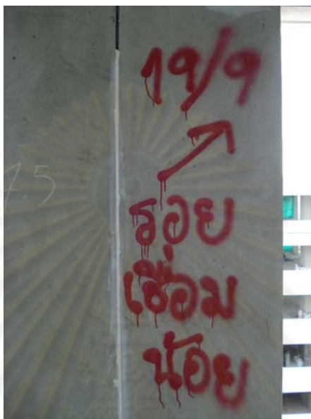
ภาพที่ 5.273 แสดงการเชื่อมยึดผนัง ค.ส.ล. สำเร็จรูป น้อยกว่าข้อกำหนด และการสังแก้ไข
