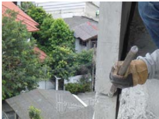
ภาพที่ 5.204 แสดงการปรับแต่งแนวตั้ง ผนัง ค.ส.ล. สำเร็จรูป ให้เสมอแผ่นล่าง
