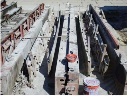
ภาพที่ 5.20 แบบหล่อคาน
