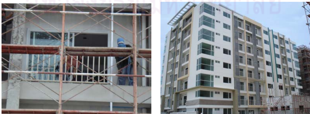
ภาพที่ 5.144 แสดงการติดตั้งราวกันตก
