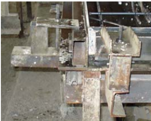
ภาพที่ 5.52 แสดงการยึดแบบข้างปรับระยะ Plate เหล็ก และ หนุนให้ตามตำแหน่งที่กำหนด
