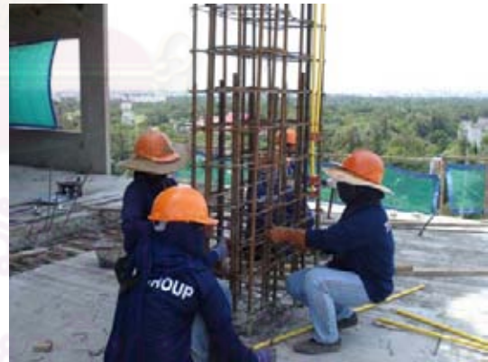
ภาพที่ 5.182 แสดงการผูกเหล็กเสา
