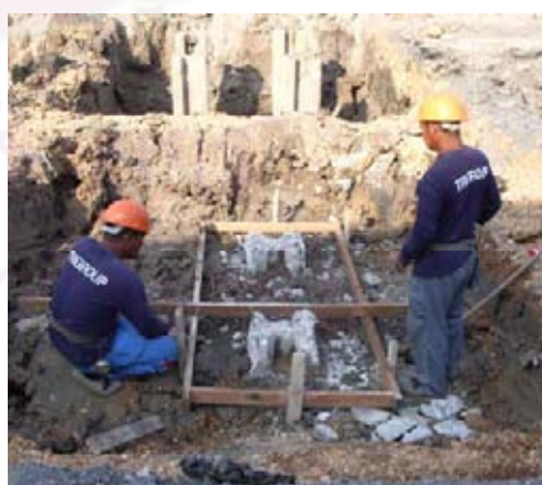
ภาพที่ 5.147 แสดงการตัดเสาเข็มและเข้าแบบเตรียมเท Lean Concrete
