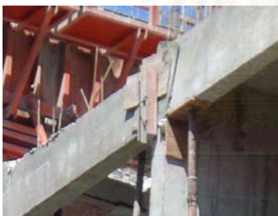
ภาพที่ 5.124 แสดงการปิดแบบเทคอนกรีต
