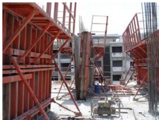
ภาพที่ 5.119 แสดงการเปิดแบบเหล็ก
