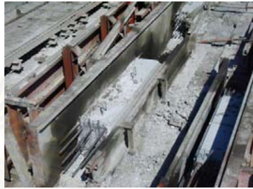
ภาพที่ 5.21 การกั้นแบบ และหล่อคานสำเร็จรูป
