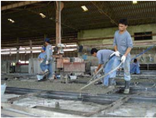
ภาพที่ 5.59 แสดงการเขย่าคอนกรีตด้วยเครื่องจักร
