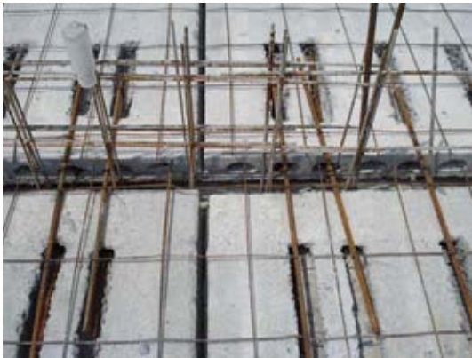
ภาพที่ 5.130 เหล็กเสริมพิเศษด้านบนรอยต่อ ภาพที่ 5.131 เหล็กเสริมพิเศษสอดในช่องพื้นตรง ระหว่างพื้น Hollow Core ที่วางบนผนังรับน้ำหนัก รอยต่อระหว่างพื้น ที่วางบนผนังรับน้ำหนัก ชนิดหล่อในที่ ชนิดหล่อในที่
