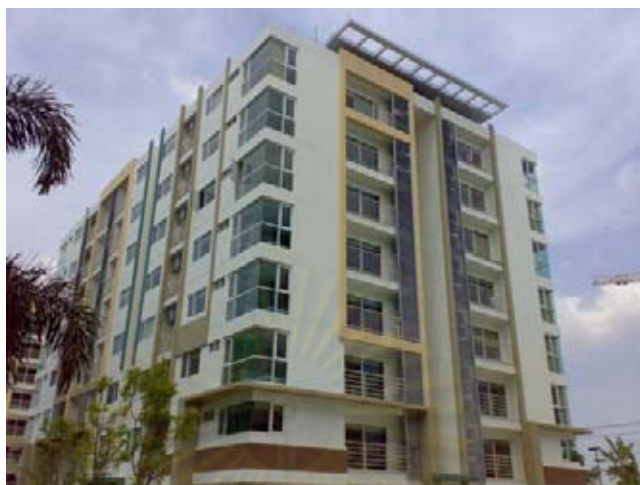
ภาพที่ 5.261 งานทาสีภายนอกอาคาร และ งานก่อสร้างอาคาร J เสร็จสมบูรณ์
