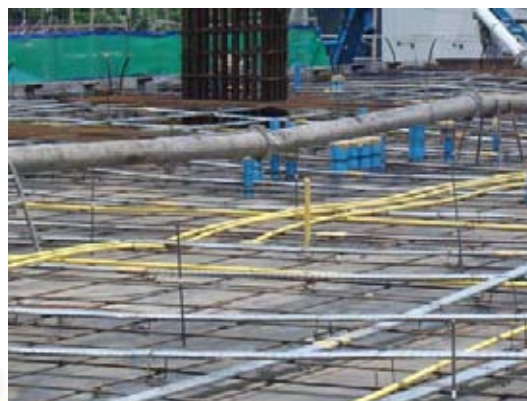
ภาพที่ 5.171 แสดงท่อส่งคอนกรีตของ Pump Concrete ต้องมีขารองรับไม่ให้กดลวด
