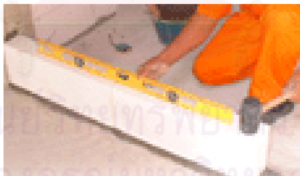
ภาพที่ 5.135 แสดงการใช้ค้อนยางและระดับน้ำช่วยจัดแนว
