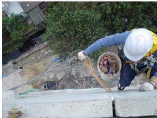
ภาพที่ 5.233 แสดงการดึงเทปกาวออกเสร็จขั้นตอนการอุด Sealant
