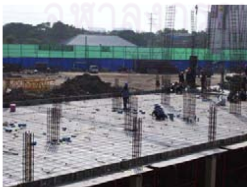
ภาพที่ 5.158 แสดงการวางเหล็กเสริมล่าง
