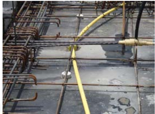
ภาพที่ 5.166 แสดงการติดตั้งระบบไฟฟ้า
