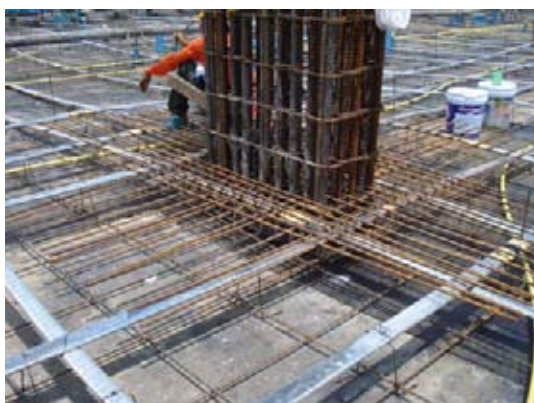
ภาพที่ 5.168 แสดงการวางเหล็กเสริมบน บริเวณหัวเสา
