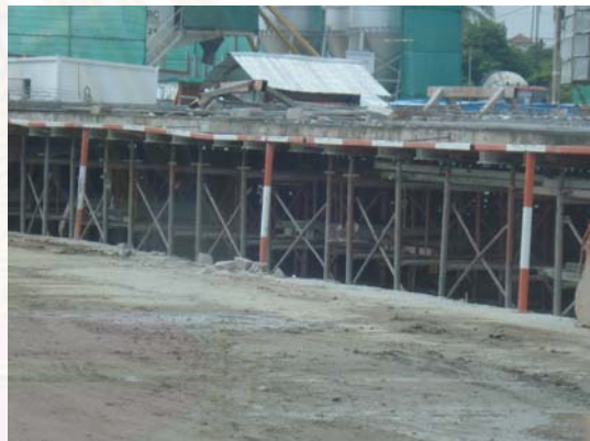
ภาพที่ 5.12 แสดงโต๊ะหล่อขึ้นส่วนสำเร็จรูป
