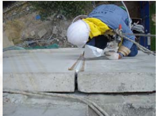
ภาพที่ 5.232 การปาด Sealant ให้เรียบเสมอลบ
