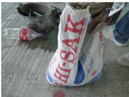
ภาพที่ 5.216 แสดงปูนตักแต่งผิวคอนกรีตเรียบมัน ใช้ตักแต่งผิวผนังนอกอาคาร
