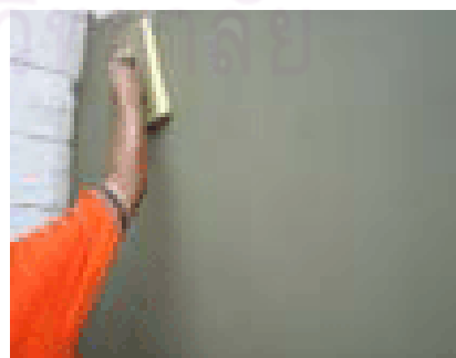
ภาพที่ 5.139 แสดงการฉาบปูน และ ลงฟองน้ำ
