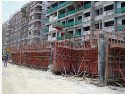
ภาพที่ 5.121 การเก็บแบบเหล็ก
