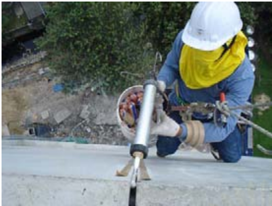
ภาพที่ 5.229 แสดงยิง Sealant ลงในร่อง
