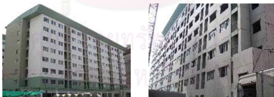
ภาพที่ 3.2 แสดงการก่อสร้างโครงการ 2
