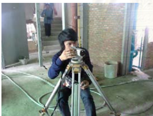
ภาพที่ 5.234 แสดงทิมเซอร์เวย์ให้แนวการก่อ
