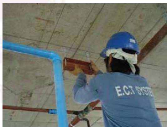
ภาพที่ 5.245 แสดงการติดตั้งระบบดับเพลิง
