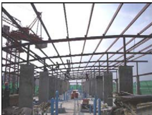
ภาพที่ 5.187 แสดงการติดตั้งโครงหลังคาเหล็ก
