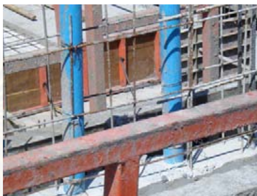
ภาพที่ 5.118 แสดงผนังรับน้ำหนักที่เทคอนกรีตแล้ว และ วัสดุติดตั้งในผนัง
