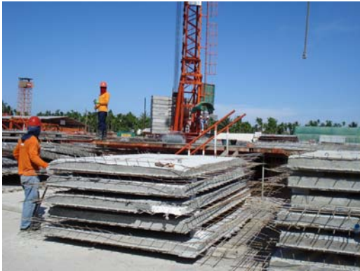
ภาพที่ 5.8 แสดงพื้นสำเร็จรูป Precast Slab
