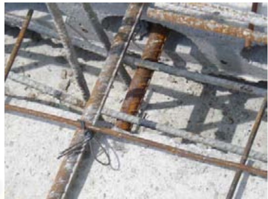
ภาพที่ 5.130 เหล็กเสริมพิเศษด้านบนรอยต่อ ภาพที่ 5.131 เหล็กเสริมพิเศษสอดในช่องพื้นตรง ระหว่างพื้น Hollow Core ที่วางบนผนังรับน้ำหนัก รอยต่อระหว่างพื้น ที่วางบนผนังรับน้ำหนัก ชนิดหล่อในที่ ชนิดหล่อในที่
