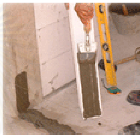
ภาพที่ 5.134 แสดงการป้ายปูนก่อด้านข้าง
