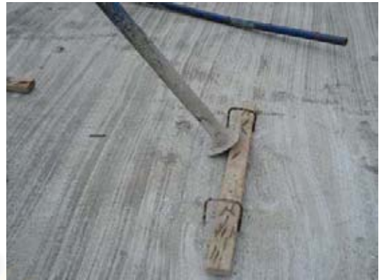
ภาพที่ 5.184 แสดงเหล็กที่ฝังไว้ที่พื้นเป็นตัวยึด
