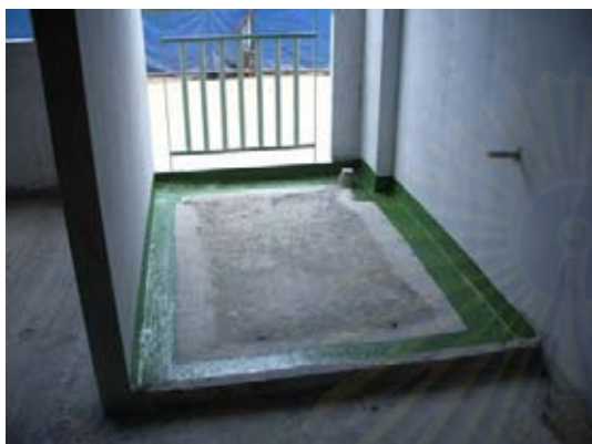
ภาพที่ 5.250 แสดงการทาน้ำยากันซึม
