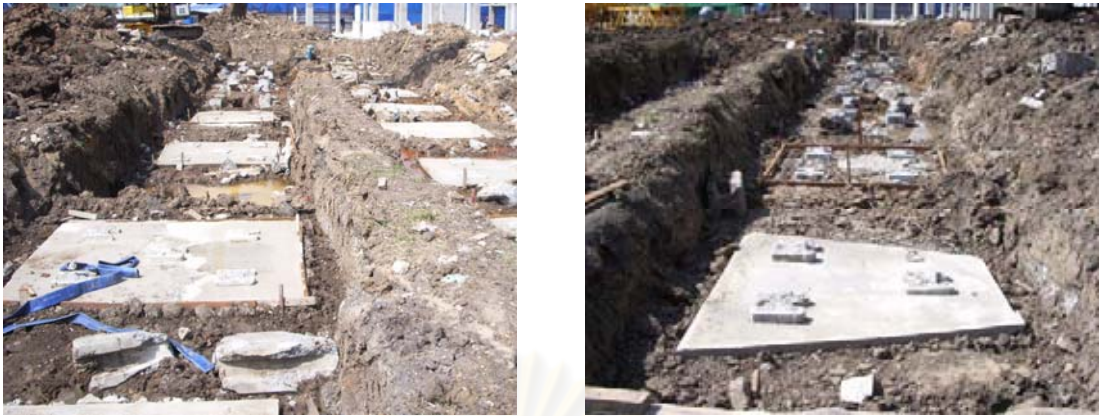
ภาพที่ 5.148 แสดงการเทคอนกรีตหยาบหุ้มหัวเสาเข็มที่ตัดแล้ว
