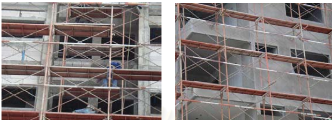
ภาพที่ 5.140 แสดงงานฉาบปูนภายนอกอาคาร
