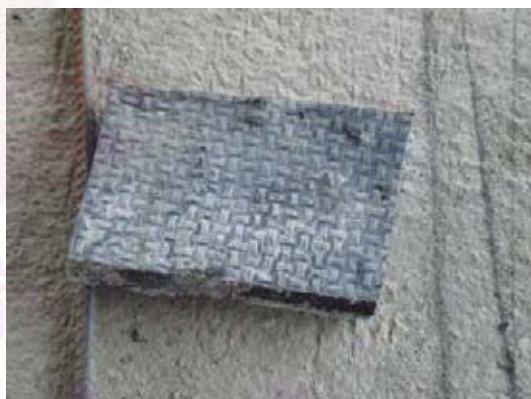
ภาพที่ 5.206 ฟองน้ำแข็งที่ติดไว้ บน Insert Plate
