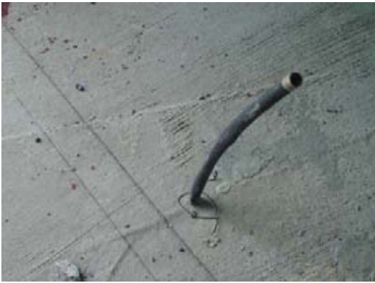
ภาพที่ 5.179 แสดงท่อรับน้ำปูน
