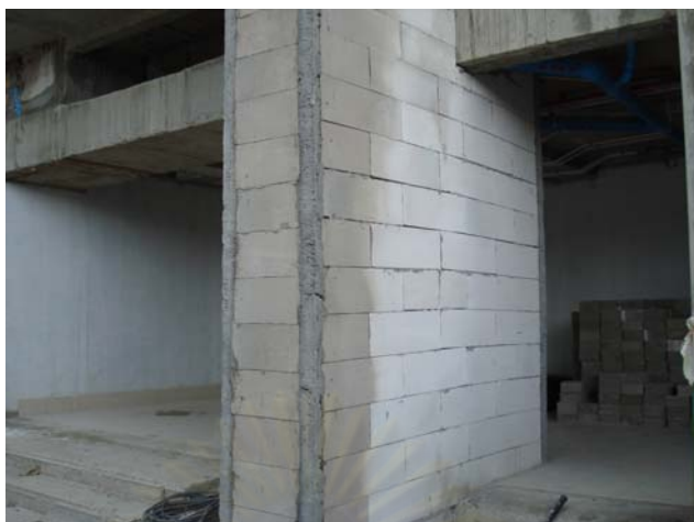
ภาพที่ 5.137 แสดงเสาเอ็นที่มุมกำแพง
