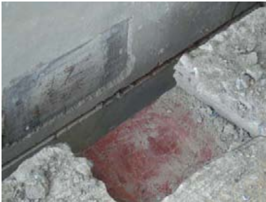
ภาพที่ 5.207 แสดง Plate ที่พื้นและผนัง ค.ส.ล.สำเร็จรูป
