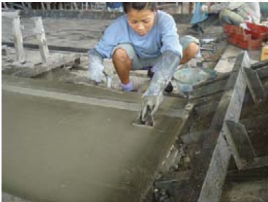
ภาพที่ 5.61 แสดงการใส่แบบเหล็กกันหุบผิว
