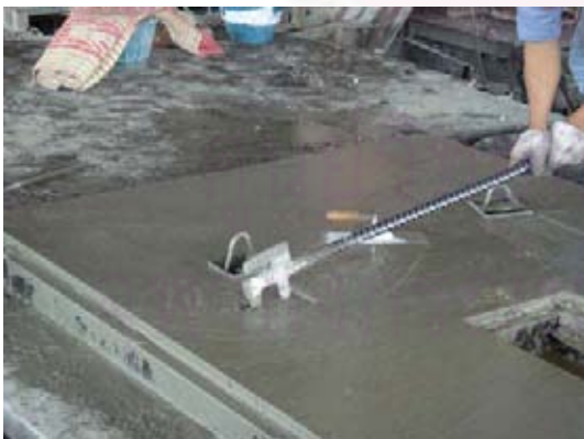
ภาพที่ 5.63 แสดงการปรับแต่งPlate เหล็ก
