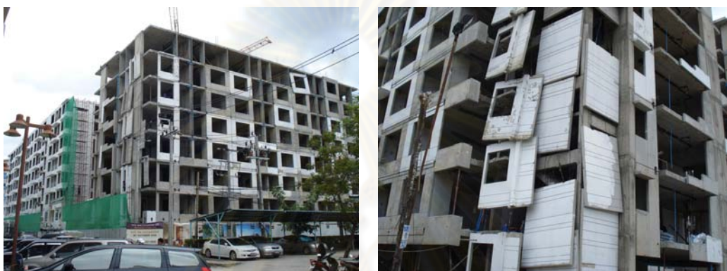
ภาพที่ 3.3 แสดงการก่อสร้างโครงการ 3
