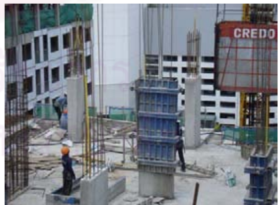
ภาพที่ 5.186 แสดงการถอดแบบเสาโดยคลายน๊อตยึด และ ใช้ทาวเวอร์เครนยกขึ้น
