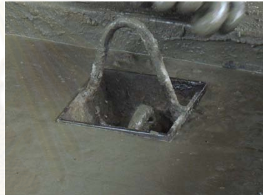
ภาพที่ 5.62 หูหิ้วแผ่นลวดกลางแบบ
