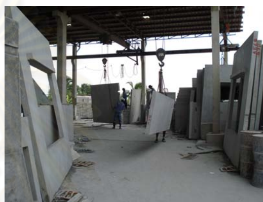
ภาพที่ 5.68 เครื่องยกชิ้นส่วนเข้าลานเก็บชิ้นส่วน
