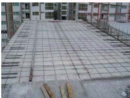
ภาพที่ 5.128 แสดงการติดตั้งพื้น Hollow Core
