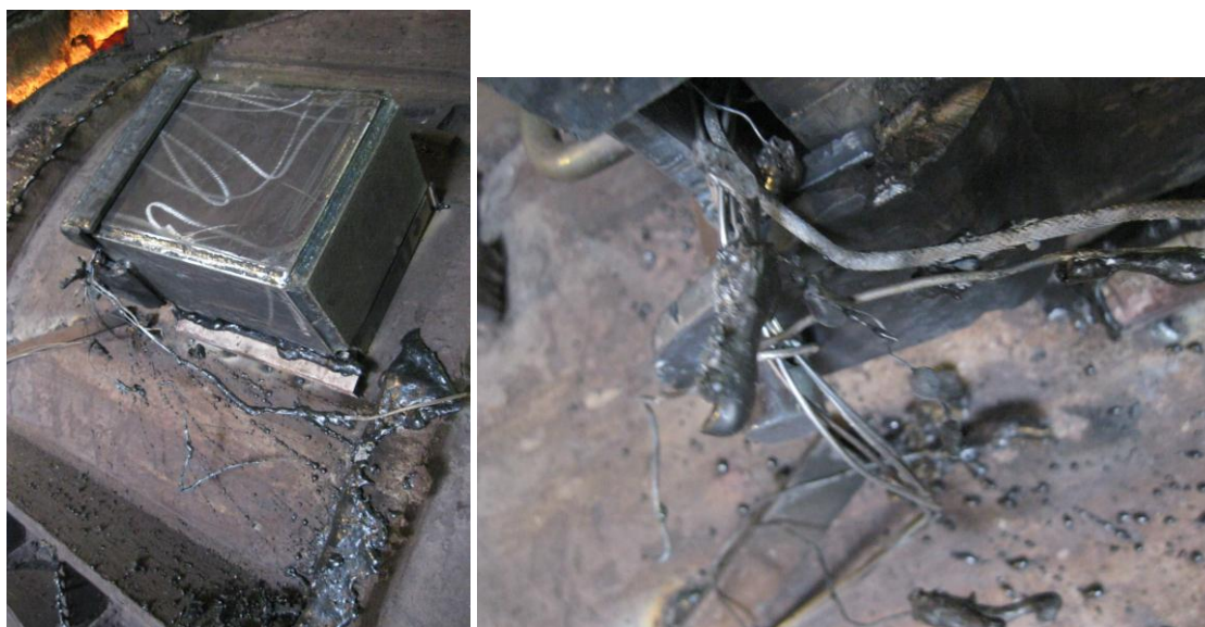
ลักษณะความเสียหายของอุปกรณ์จากการสัมผัสน้ำเหล็กที่ล้นออกจากเบ้ารับน้ำเหล็ก
