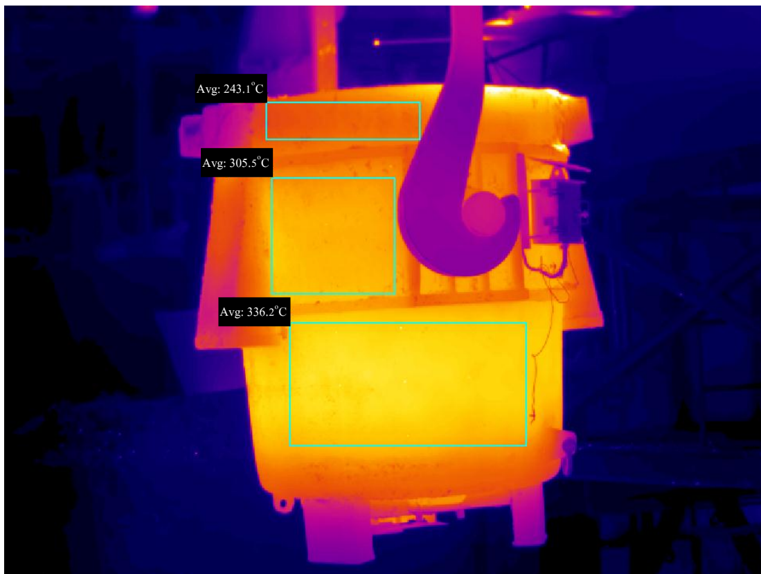
รูปที่ 5-16 ภาพถ่ายความร้อนผนังภายนอกเข้รับน้ำเหล็กขณะรอเทน้ำเหล็กที่ สถานีหล่อแบบต่อเนื่อง
