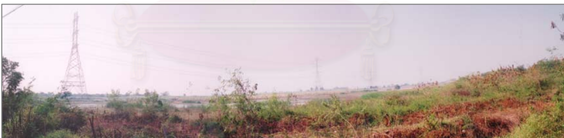
ภาพที่ 5.57 ภาพตัวแทนที่ 48 ภาพเสาไฟฟ้าแรงสูง (78-TDelectric)
