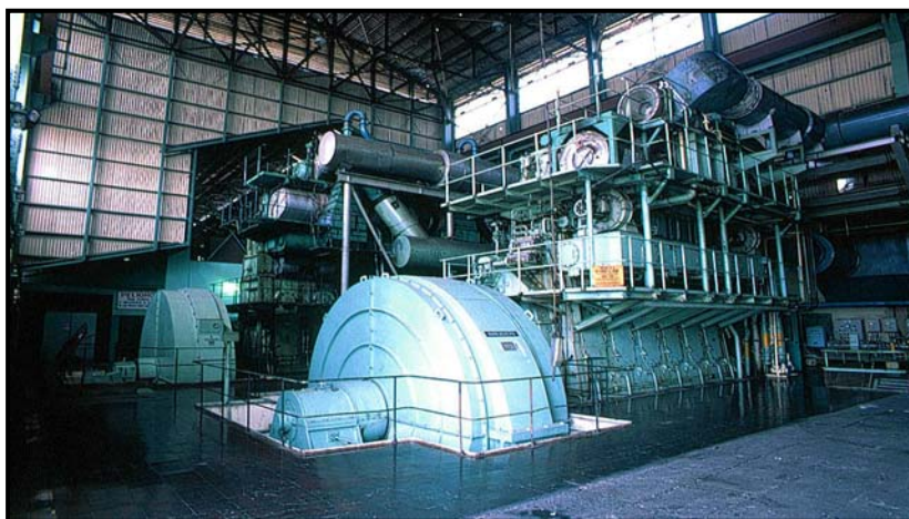
รูปที่ 2.5 เครื่องยนต์ดีเซลโดยสังเขปของโรงไฟฟ้าดีเซล (มหาวิทยาลัยขอนแก่น, 2552 : ออนไลน์)
