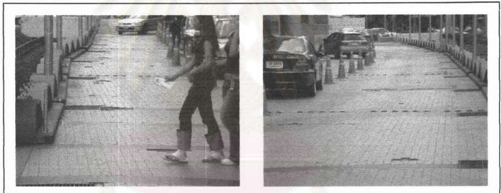
แผนภาพที่ 4.21 แสดงสภาพวัสดุปูพื้นบริเวณด้านหน้าศูนย์การค้าเซ็นทรัลพลาซาพระราม 3
