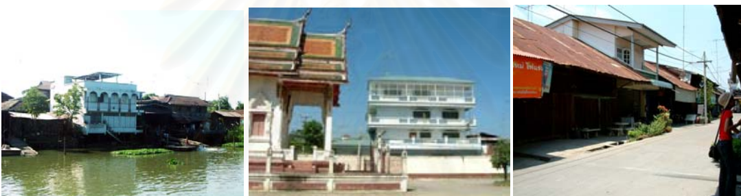
ปัญหาการก่อสร้างอาคารใหม่ที่ไม่สอดคล้องกับอาคารใกล้เคียง
