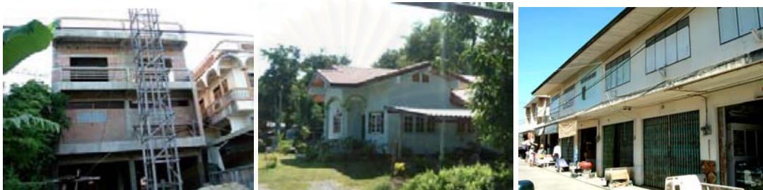
ปัญหาการก่อสร้างอาคารรูปแบบใหม่
