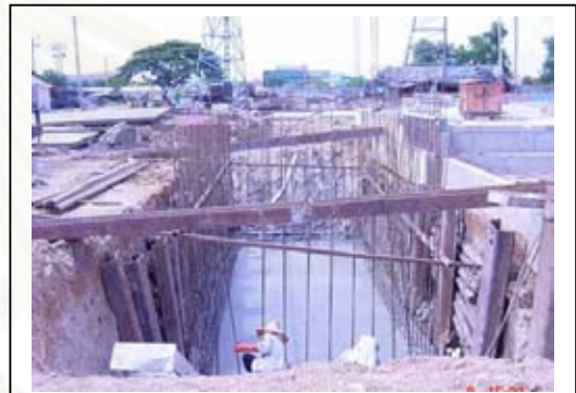
ภาพที่ 4.122 ผูกเหล็กผนังถังเก็บน้ำใต้ดิน
