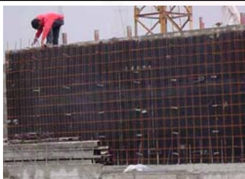
ภาพที่ 4.100 ส่วนที่เป็นผนังรับแรง
