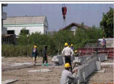
ภาพที่ 4.64 วิศวกรควบคุมการวางคาน
