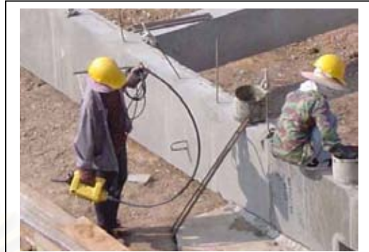
ภาพที่ 4.67 เครื่องจี้ไฟฟ้าเกร้าท์ ปูน
