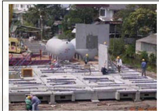
ภาพที่ 4.73 การติดตั้งผนังหลักลำดับแรก
