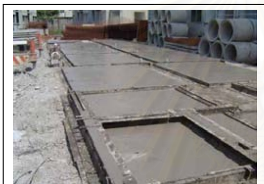
ภาพที่ 4.112 การบ่มคอนกรีต
