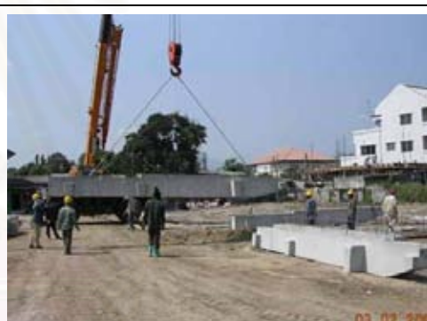
ภาพที่ 4.63 การเตรียมวางคานสำเร็จรูป
