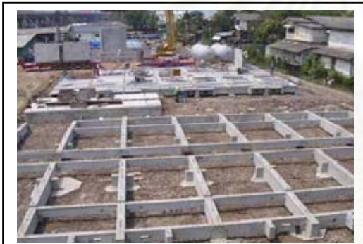
ภาพที่ 4.68 การเสียบเหล็กและเกร้าท์ปูน
