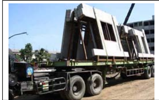
ภาพที่ 4.31 การขนส่งแผ่นผนังสำเร็จรูป
