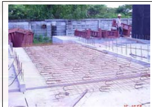
ภาพที่ 4.132 เตรียมตระแกรงเหล็กผูก
