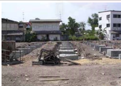
ภาพที่ 4.58 การถอดแบบเหล็กหล่อกับที่
