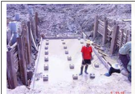
ภาพที่ 4.121 เทพื้นถังเก็บน้ำใต้ดิน
