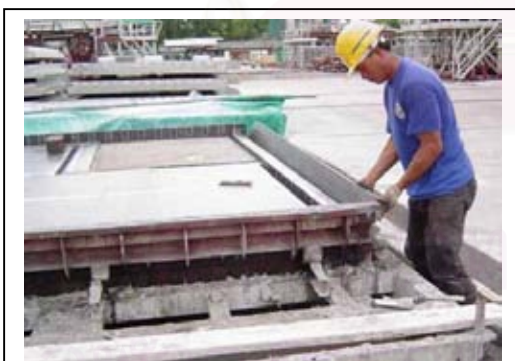
ภาพที่ 4.16 การประกอบแบบข้าง
