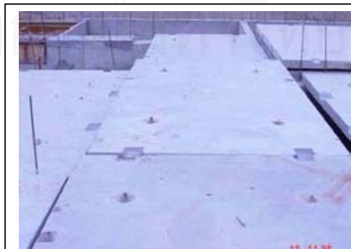
ภาพที่ 4.128 การวางพื้นสำเร็จรูป
