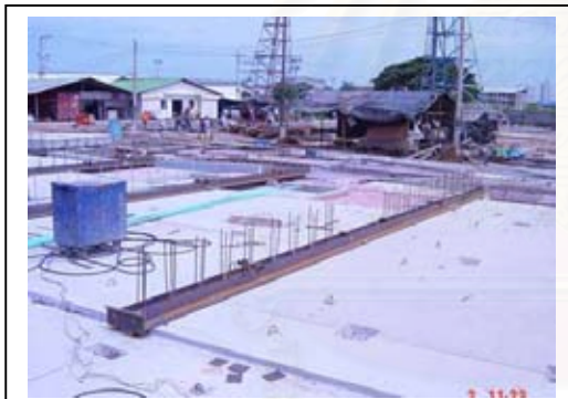
ภาพที่ 4.131 ตั้งแบบ KICKER เหล็ก
