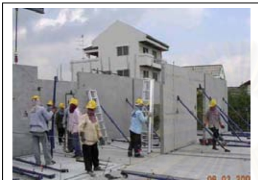
ภาพที่ 4.74 การติดตั้งป๊อบ 2 ชั้นต่อแผ่น
