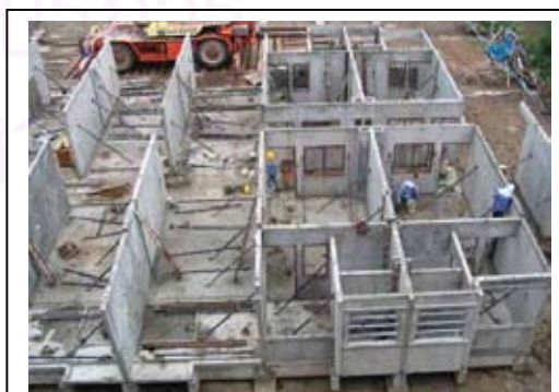
ภาพที่ 4.79 ติดตั้งผนังรองตามลำดับ
