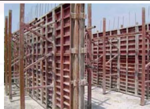
ภาพที่ 4.101 เข้าแบบข้างผนังรับแรง
