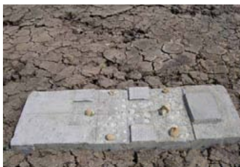
ภาพที่ 4.60 อุดรูเสียบเหล็กด้วยฟองน้ำ
