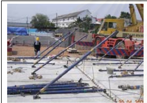
ภาพที่ 4.72 การติดตั้งป๊อบตามผนังหลัก
