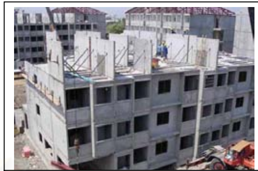
ภาพที่ 4.87 วางผนังหลัก ชั้น 4
