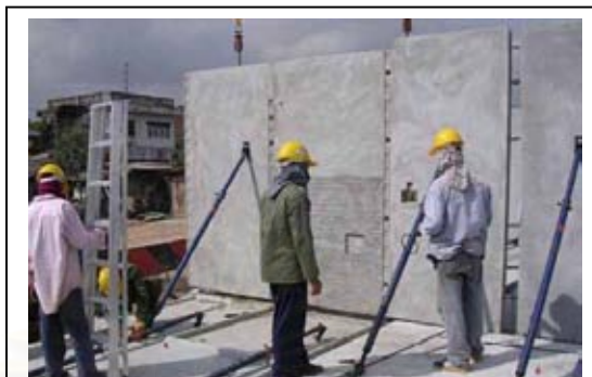
ภาพที่ 4.92 การติดตั้งตำแหน่งยึดป๊อป
