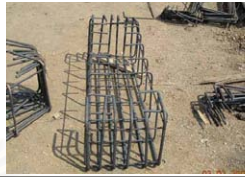
ภาพที่ 4.55 เหล็กเสริมในฐานรากแบบF2
