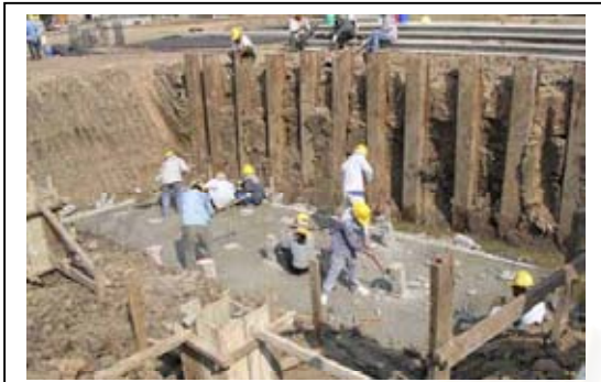
ภาพที่ 4.45 การตัดเข็มให้เข็มไผ่ 10 ซม.
