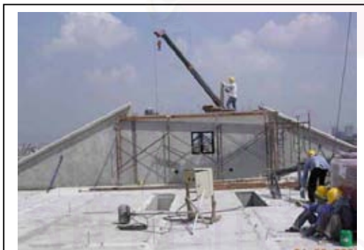
ภาพที่ 4.90 การติดตั้งจั่วสำเร็จรูป
