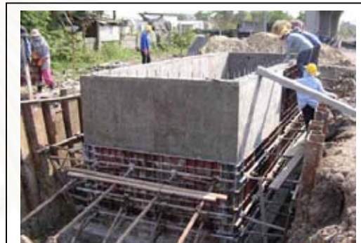
ภาพที่ 4.48 การเข้าแบบผนังหล่อกับที่
