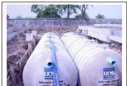
ภาพที่ 4.124 วางถังเก็บน้ำใต้ดิน
