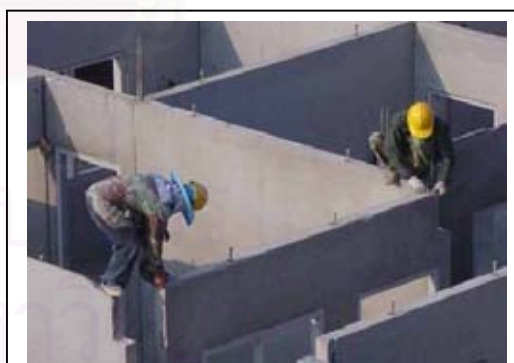
ภาพที่ 4.41 การตีเส้นแนวแผ่นพื้น
