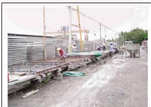
ภาพที่ 4.20 เทคอนกรีตด้วย BUCKET
