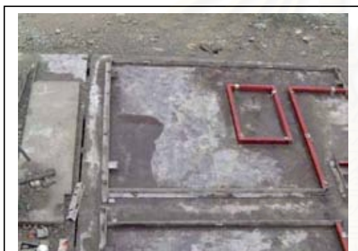
ภาพที่ 4.102 การเข้าแบบเหล็ก
