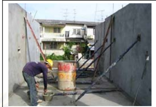
ภาพที่ 4.81 เข้าแบบเหล็ก, เกร้าที่ปูน
