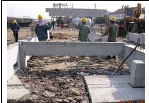
ภาพที่ 4.66 การวางคานรอง
