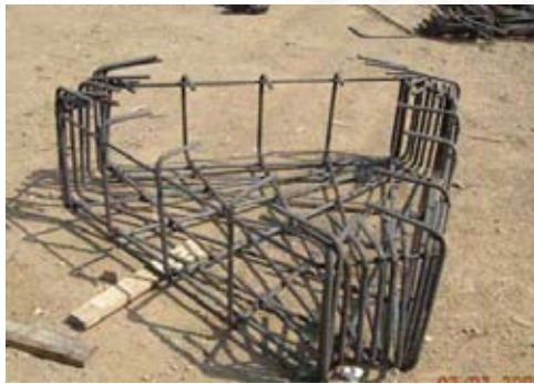
ภาพที่ 4.56 เหล็กเสริมในฐานรากแบบF3
