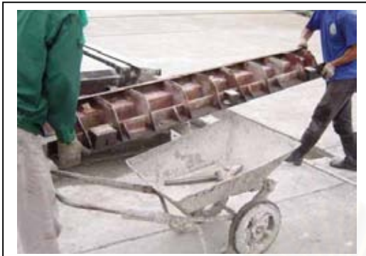
ภาพที่ 4.12 การขนย้ายแบบเหล็ก
