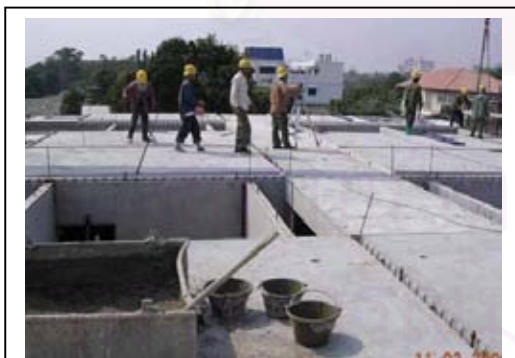
ภาพที่ 4.84 การวางพื้น ชั้น 3
