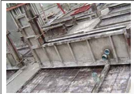
ภาพที่ 4.106 หล่อผนัง 2 ชั้นในตัวเดียวกัน
