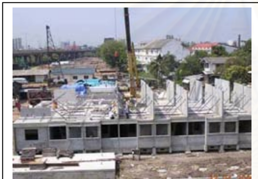
ภาพที่ 4.82 วางผนังหลัก ชั้น 2
