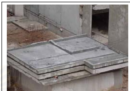
ภาพที่ 4.117 การเก็บแผ่นพื้นสำเร็จรูป
