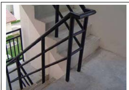
ภาพที่ 5.2 บริเวณบันไดหนีไฟ
