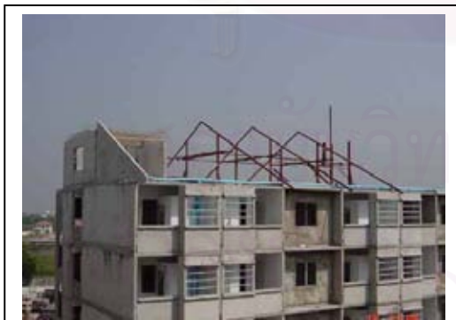
ภาพที่ 4.145 งานติดตั้งโครงหลังคา
