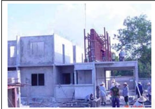
ภาพที่ 4.141 แบบหล่อขึ้นส่วนหล่อทับที่
