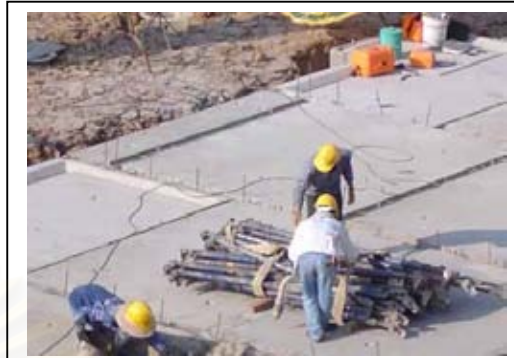
ภาพที่ 4.71 การเตรียมติดตั้งป๊อบ
