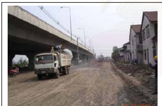
ภาพที่ 4.43 ถนนทางเข้าโครงการ
