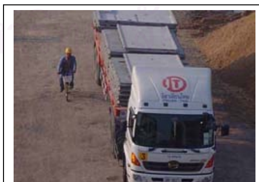
ภาพที่ 4.39 การขนส่งแผ่นพื่นซ้อนทับ
