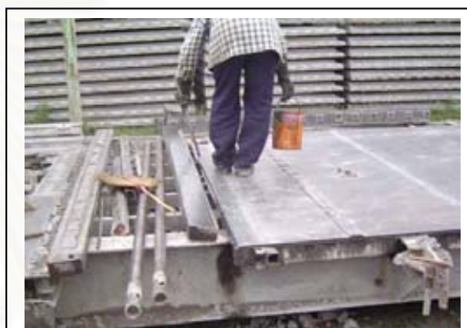
ภาพที่ 4.11 การทาน้ำมันบนแบบเหล็ก
