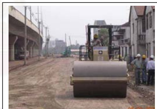
ภาพที่ 4.44 การบดถนนด้วยดินลูกรัง
