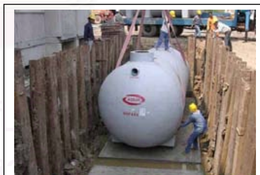
ภาพที่ 4.50 การวางถังบำบัด
