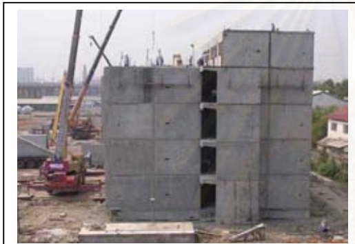
ภาพที่ 4.88 การติดตั้งผนังชั้น 5, พื้นชั้น 6
