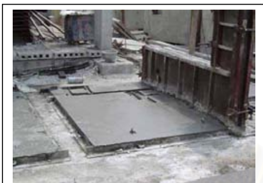
ภาพที่ 4.110 หล่อผนัง 2 ชั้นในตัวเดียวกัน
