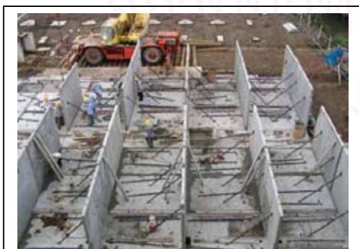
ภาพที่ 4.78 ติดตั้งตามแนวผนังหลัก
