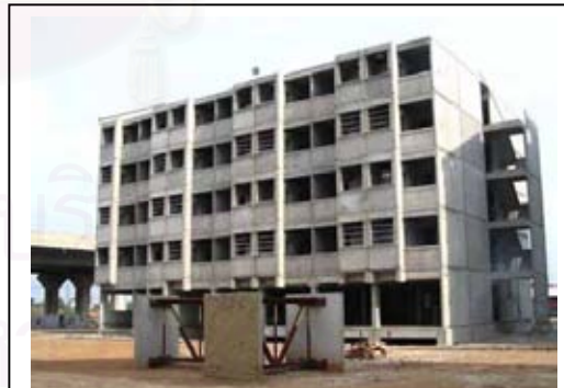
ภาพที่ 4.91 ติดตั้งแผ่นสำเร็จรูปเสร็จ
