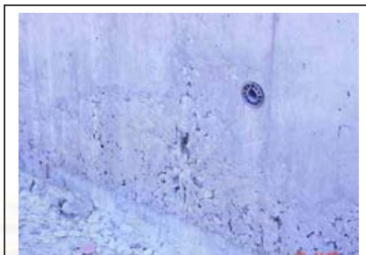
ภาพที่ 4.180 ผนังรับแรงมีช่องอากาศ
