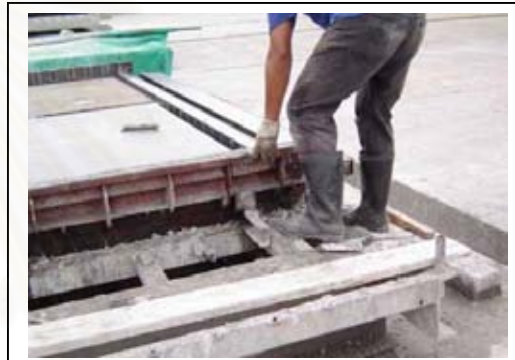
ภาพที่ 4.15 การตั้งแบบหัว,ท้าย
