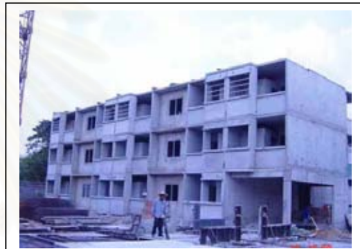
ภาพที่ 4.144 ตั้งแบบ KICKER เหล็กชั้น 3
