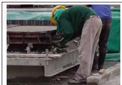
ภาพที่ 4.17 การประกอบแบบยึดนอต
