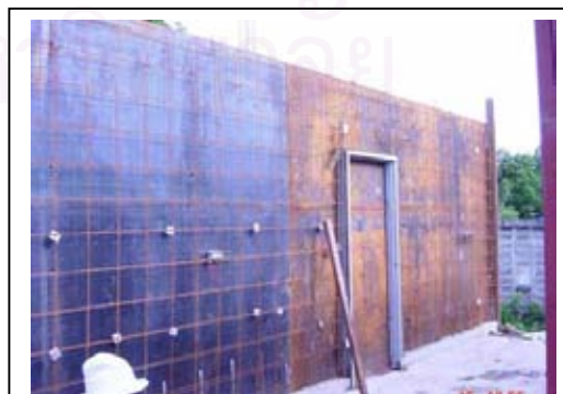
ภาพที่ 4.134 ด้านในของแบบหล่อผนัง
