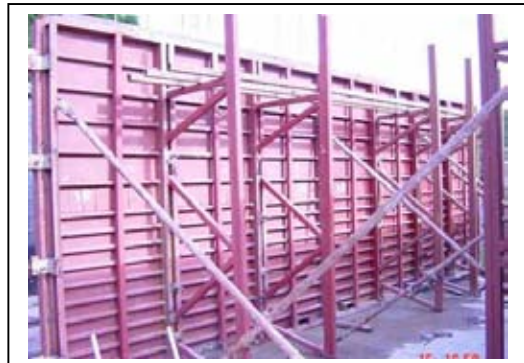
ภาพที่ 4.136 แบบหล่อขึ้นส่วนหล่อกับที่
