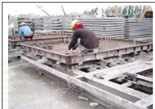
ภาพที่ 4.19 ใส่โครงเหล็กผูกในแบบ
