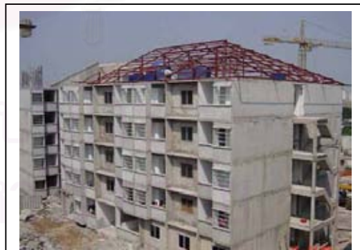
ภาพที่ 4.146 งานเตรียมติดตั้งหลังคา
