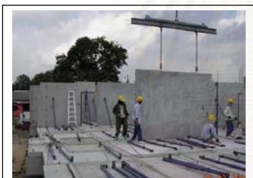
ภาพที่ 4.76 แครนยกแผ่นผนังสำเร็จรูป
