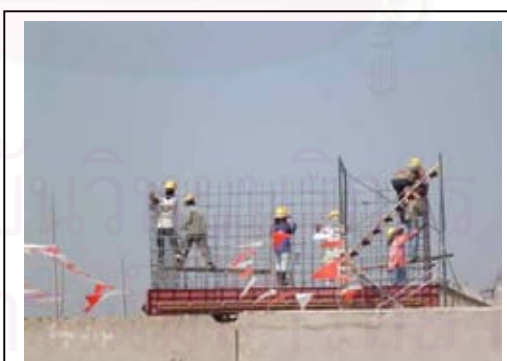
ภาพที่ 4.93 การผูกเหล็กเตรียมหล่อในที่
