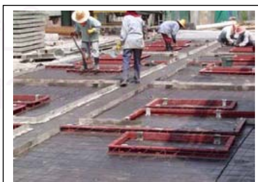
ภาพที่ 4.105 การผูกเหล็ก
