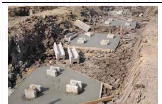
ภาพที่ 4.53 ใ้ระดับโดยเทคอนกรีตฐานราก
