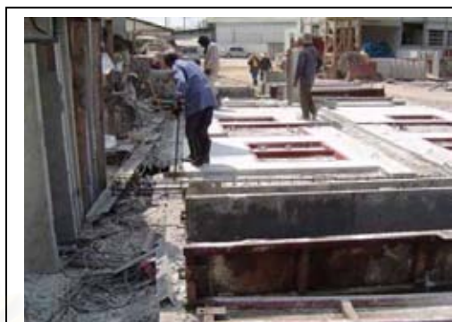
ภาพที่ 4.111 การถอดแบบผนัง
