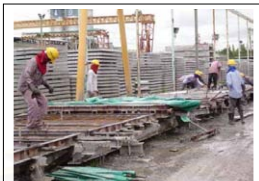
ภาพที่ 4.21 บ่มคอนกรีตด้วยผ้าใบคลุม
