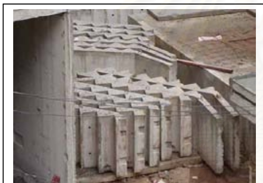
ภาพที่ 4.118 การเก็บบันไดสำเร็จรูป
