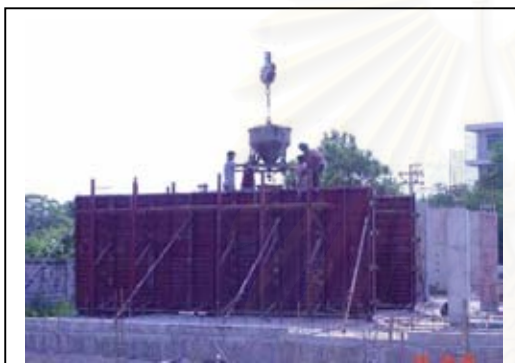
ภาพที่ 4.137 เทแบบผนังรับน้ำหนัก
