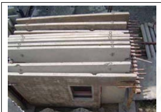
ภาพที่ 4.116 การเก็บแผ่นผนังสำเร็จรูป
