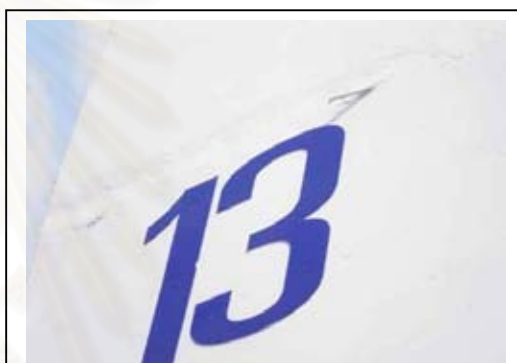
ภาพที่ 5.10 ผิวผนังไม่ได้คุณภาพ-เก็บงาน
