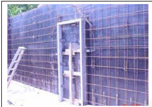
ภาพที่ 4.135 ยึดวงกบก่อนเทคอนกรีต
