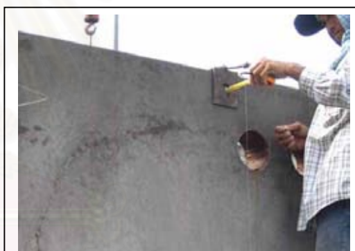
ภาพที่ 4.77 ใช้ดิ่งตรวจสอบว่าผนังตั้งฉาก
