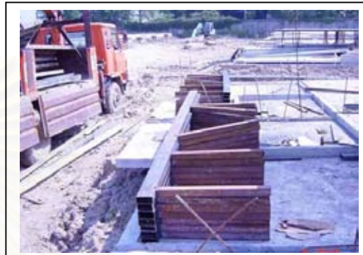
ภาพที่ 4.130 ขาแบบหล่อชั้นส่วนหล่อทับที่
