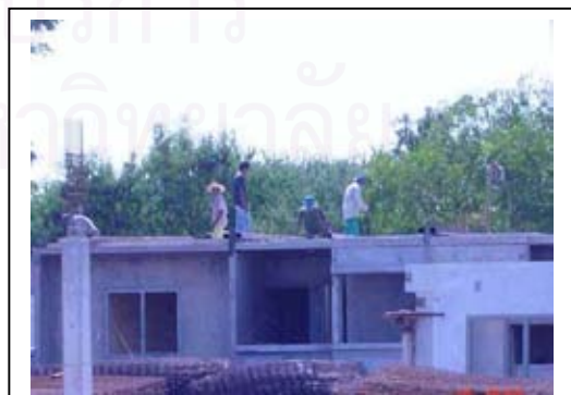
ภาพที่ 4.140 ตั้งแบบ KICKER เหล็กชั้น 2
