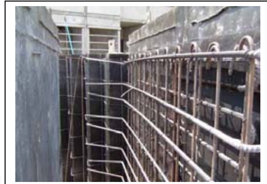
ภาพที่ 4.107 เข้าแบบบันไดสำเร็จรูป
