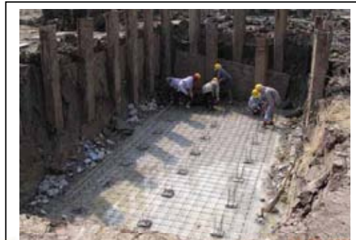
ภาพที่ 4.46 การวางตะแกรงเหล็ก
