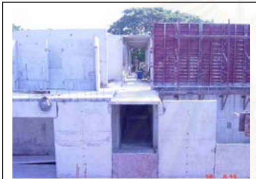
ภาพที่ 4.143 แบบหล่อขึ้นส่วนหล่อทับที่
