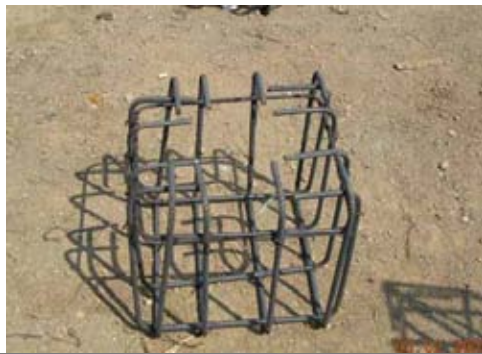
ภาพที่ 4.54 เหล็กเสริมในฐานรากแบบF1
