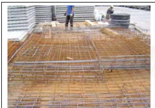
ภาพที่ 4.18 การจัดเตรียมโครงเหล็กผูก
