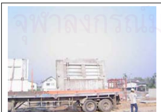
ภาพที่ 4.38 การขนส่งแผ่นผนังตั้งเดียว
