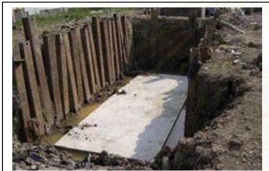
ภาพที่ 4.47 การเทพื้นถึงเก็บน้ำใต้ดิน
