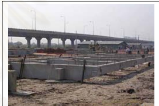
ภาพที่ 4.69 วางคานสำเร็จรูปเสร็จ
