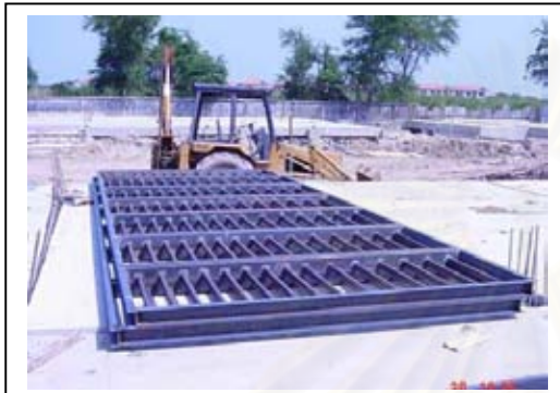
ภาพที่ 4.129 แบบหล่อชั้นส่วนหล่อทับที่
