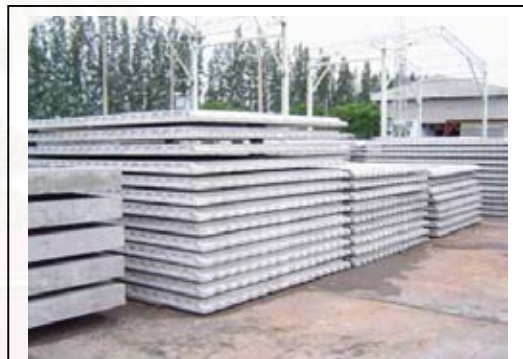
ภาพที่ 4.33 การซ้อนเก็บแผ่นพื้นสำเร็จรูป
