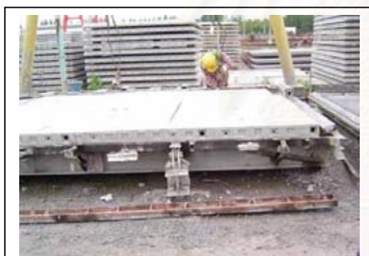
ภาพที่ 4.22 ใช้บล็อกเหล็กในการยก
