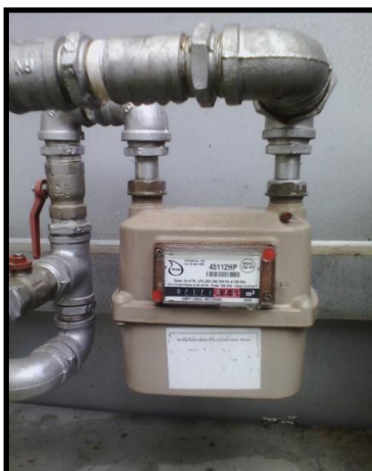
ภาพที่ 3.5 ก๊าซมิเตอร์ที่เชื่อมต่อด้านข้างของถังหมัก
