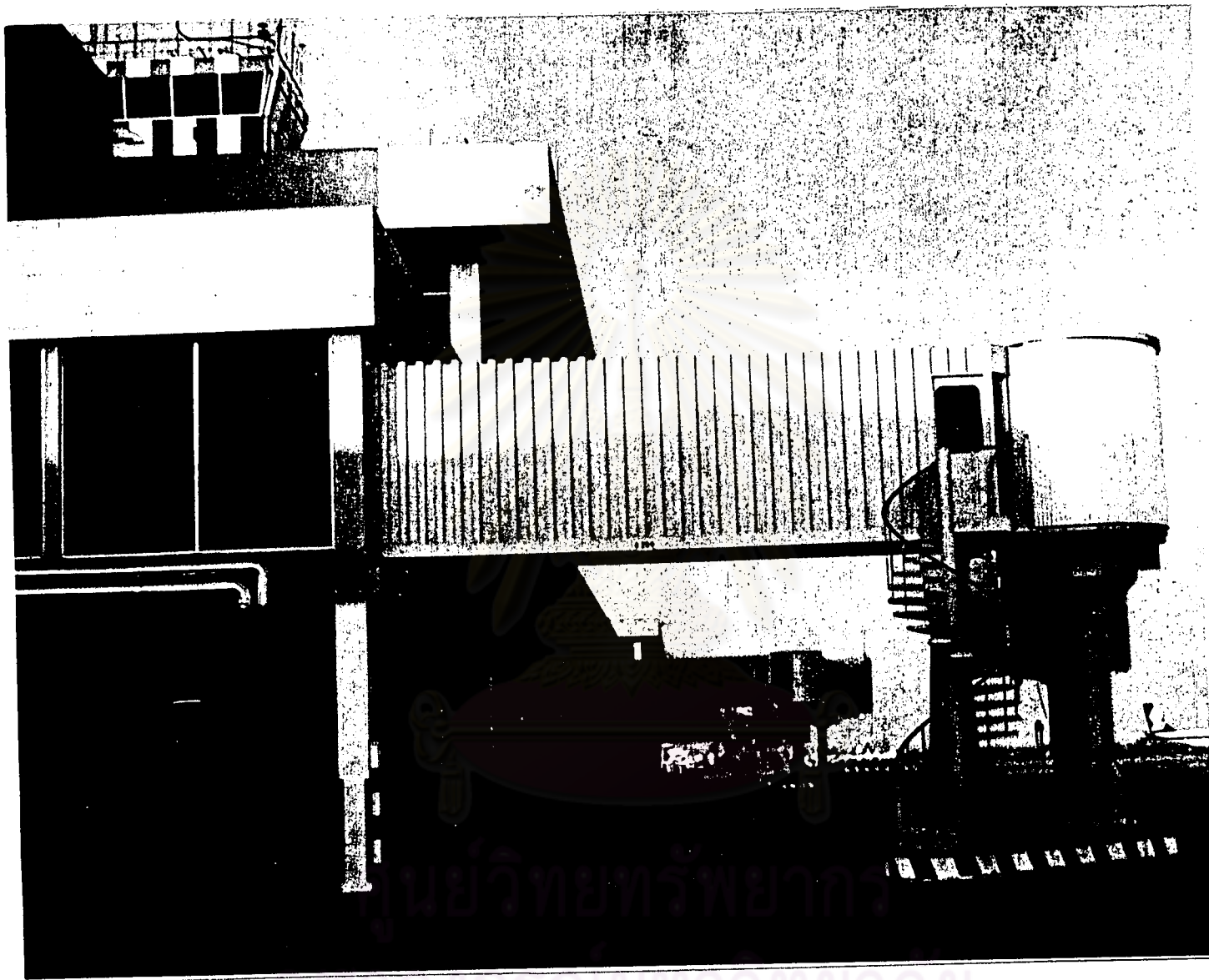
รูปที่ ๓.๗ สะพานเทียบ เครื่องบินซึ่ง เชื่อมระหว่างอาคารผู้โดยสารกับ เครื่องบิน
