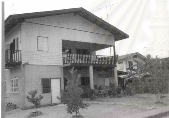
รูปที่ 5.8 ตัวอย่างอาคารบ้านครึ่งปูนครึ่งไม้ 1
