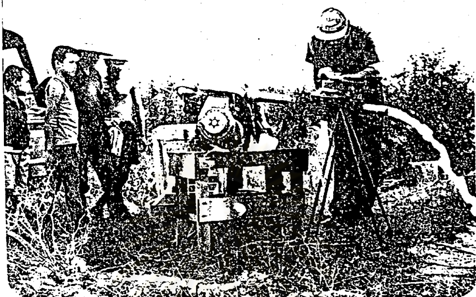
รูปที่ ก-9 อ่านค่ามาตรวัดปริมาณน้ำ และระดับน้ำลค ตามช่วง เวลาต่าง ๆ ขณะกำลังสูบ
