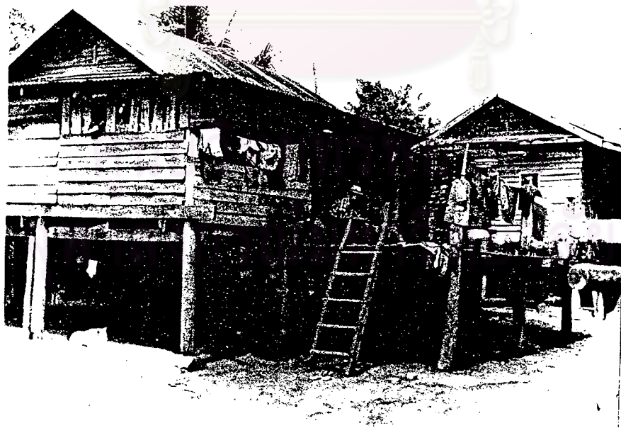
รูปที่ ๕.๗ เรือนหลังคาจั่วทรงตำมีเรือนโข่ง
