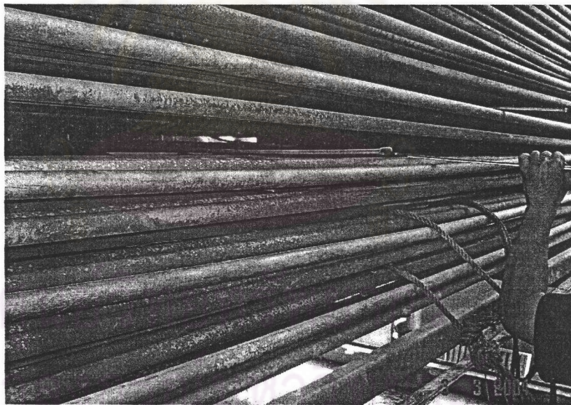
รูปที่ ๑.๙ การทำความสะอาดท่อของเครื่องควบแน่นแบบระเหยด้วยพัดลม ทำการเปิดตัวโครงเหล็กด้านนอกออกก่อนแล้วจึงค่อยทำความสะอาดด้วยการใช้ชะแลง หรือสว่านกระแทกเคาะ
