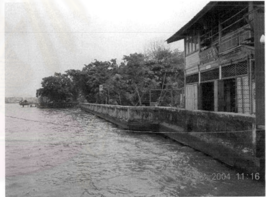
ภาพที่ 4-18 แสดงกำแพงกั้นน้ำ ริมแม่น้ำเจ้าพระยา
