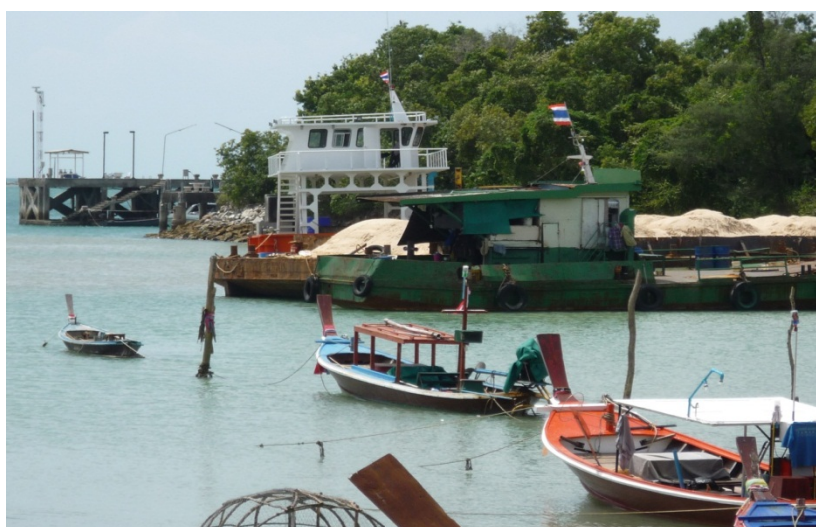
ภาพที่ 1 การก่อสร้างท่าเรือน้ำลึกบริเวณชายฝั่งอ่าวตังเซ็น จังหวัดภูเก็ต
