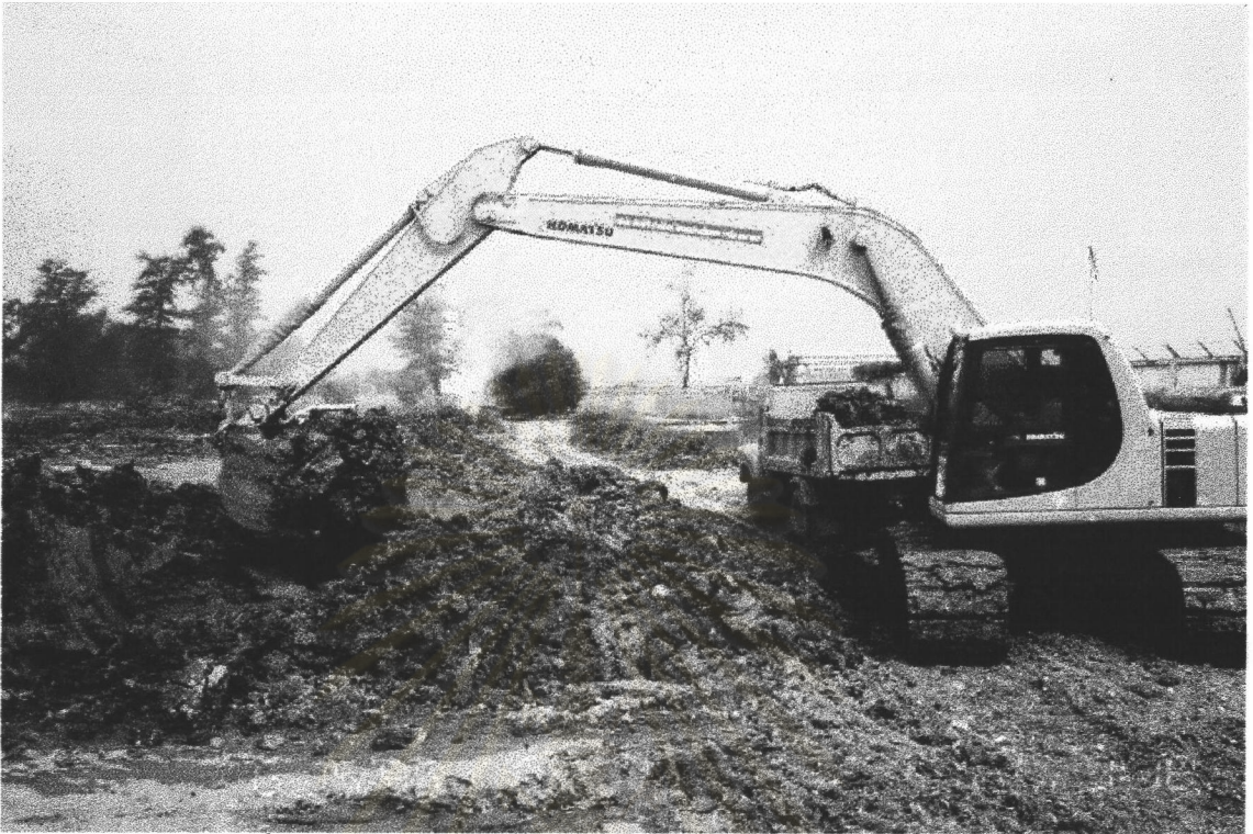
รูปที่ 4.4 การตัดตะกอนเพื่อบรรเทาขนย้ายออกจากโรงผลิตน้ำบางเขน
