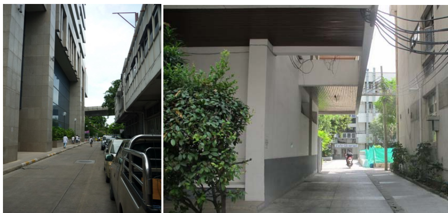
ภาพที่ 3.11 สภาพพื้นที่ข้างอาคาร
