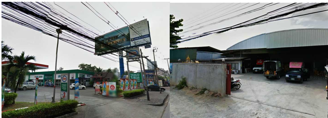
ภาพที่ 3-22 แสดงลักษณะอาคารขนาดใหญ่ที่ประกอบกิจการอยุริมแนวถนน ที่มา : ผู้วิจัย
