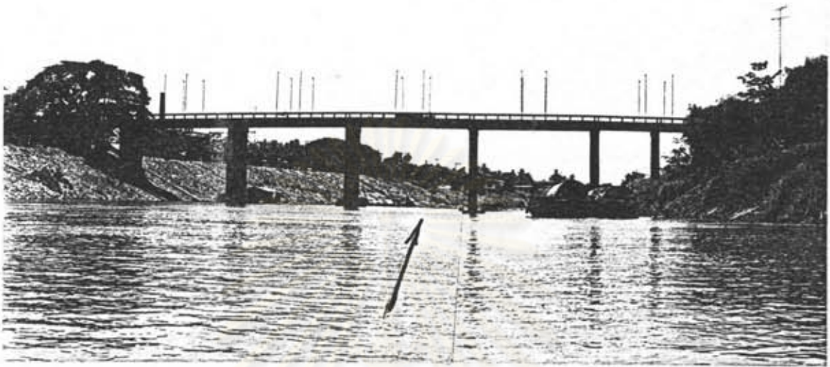
รูป 4-6 ลักษณะช่องเปิดของสะพานตะพานหิน
