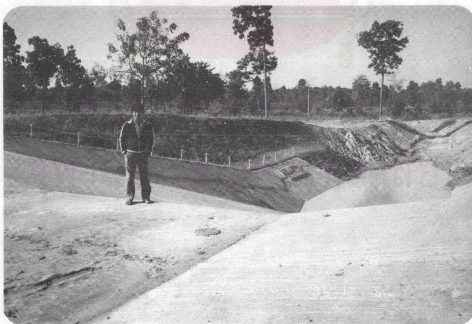
รูป 4-18 ทางระบายน้ำล้น กรมชลประทาน บ้านโนนสมบูรณ์
