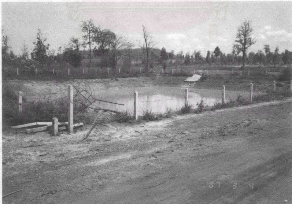
ข) สภาพสระรับน้ำใต้ดินในฤดูแล้ง ซึ่งจะมีน้ำอยู่ เนื่องจากระดับน้ำใต้ดินอยู่สูงกว่าระดับกันสระ
