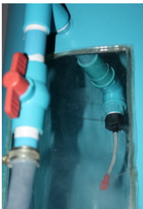
รูปที่ 3.10 การติดตั้งตัวกระจายของเหลว (Liquid Distributor)
