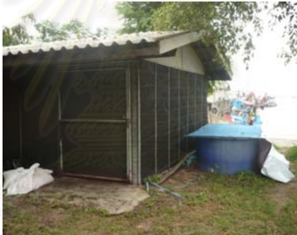
รูปที่ 3.2 บ่อไฟเบอร์ด้านนอกเรือนเลี้ยงเพื่อบำบัดน้ำ
