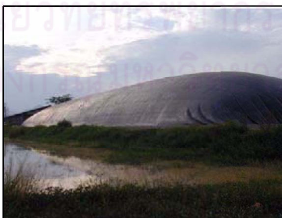
รูปที่ 2.5.10-1 บ่อหมักแบบไร้อากาศ (กรมควบคุมมลพิษ, 2546)
