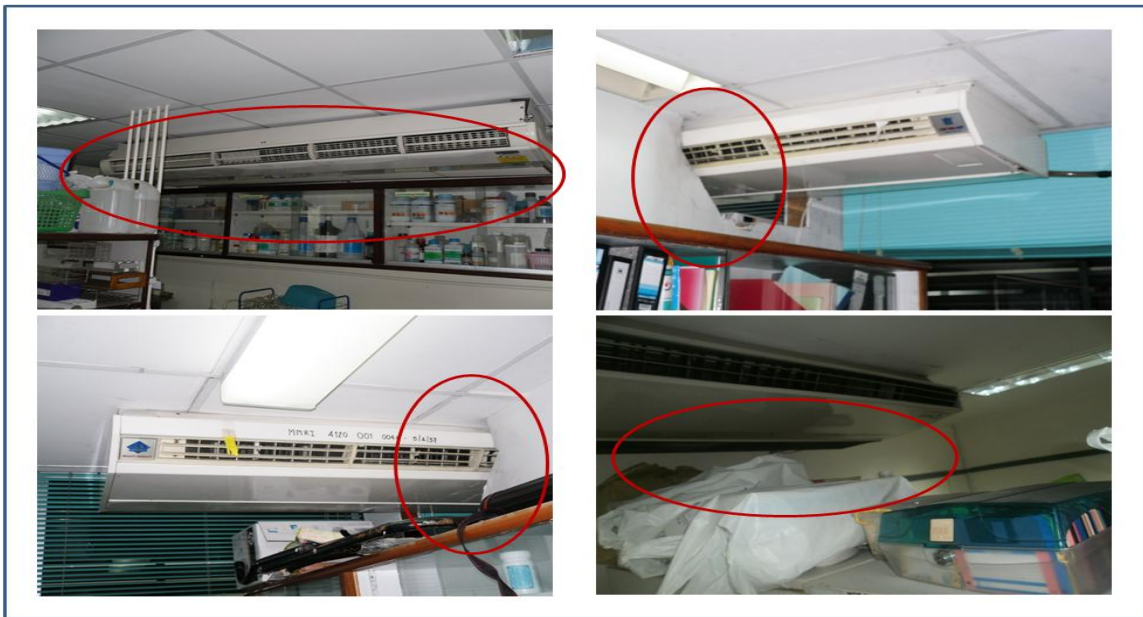
ภาพที่ 4.1 แสดงสภาพการติดตั้งอุปกรณ์ระบบปรับอากาศ
