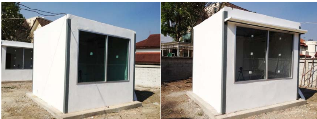
ภาพที่ 4.1 ห้องทดลองพลังงาน 1 ( SHGC_1 mockup) และห้องทดลองพลังงาน 2 ( SC_1 mockup)
