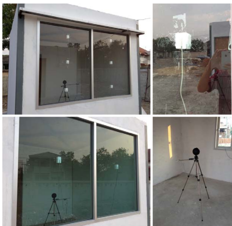
ภาพที่ 3.16 แสดงการติดตั้งอุปกรณ์
