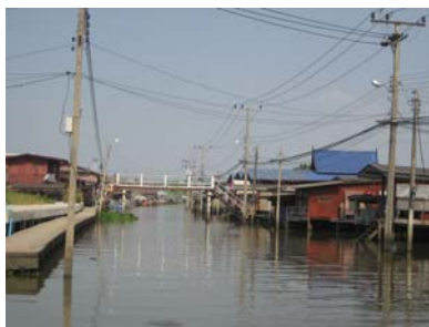
ระบบไฟฟ้า
